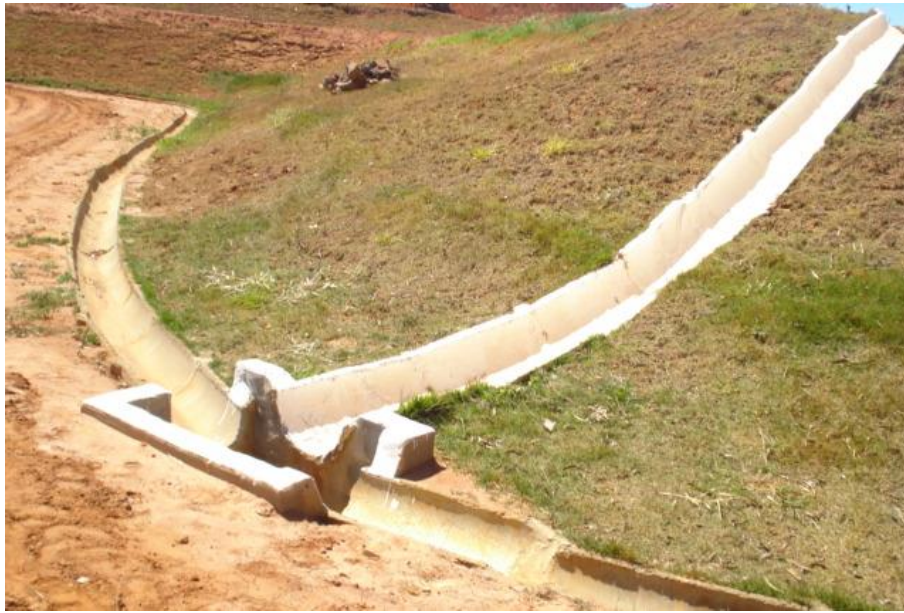
Figura 45 – Vista do Sistema de Drenagem do Aterro - São Pedro.
