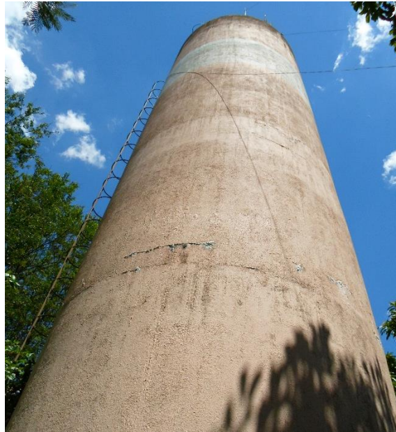
Figura 31 – Reservatório Apoiado de 120 m 3 do Portal dos Nobres.
