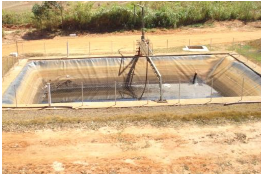
Figura 46 – Vista do Sistema de Tratamento de Chorume do Aterro - São Pedro.
