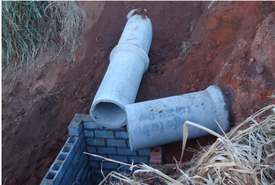
Figura 62 – Tubulação Coletora de Águas Pluviais.
