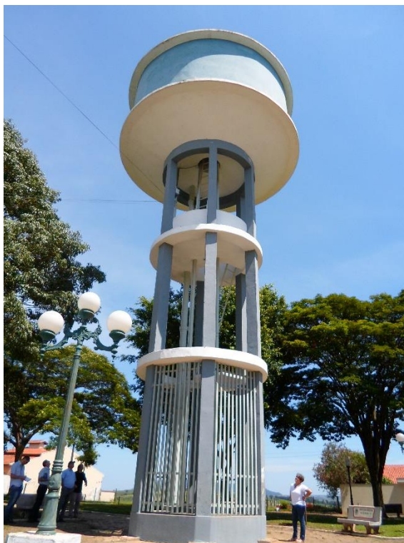
Figura 28 - Reservatório Elevado de 110 m 3 do Centro.
