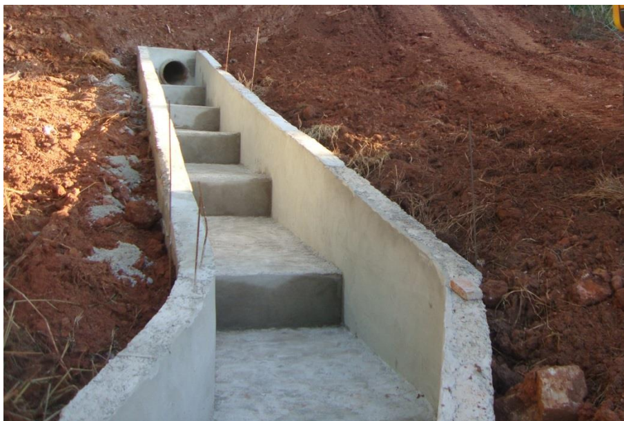
Figura 63 – Escada de Dissipação de Energia.
