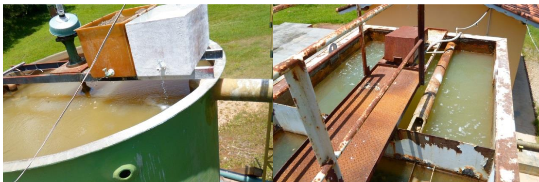
Figura 25 – Vista dos Tanques Onde são Realizadas a Dosagem de PAC e Correção de pH.
