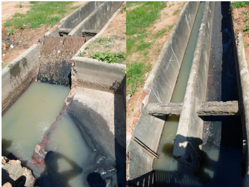
Figura 37 – Vista do Gradeamento e da Caixa de Areia.
