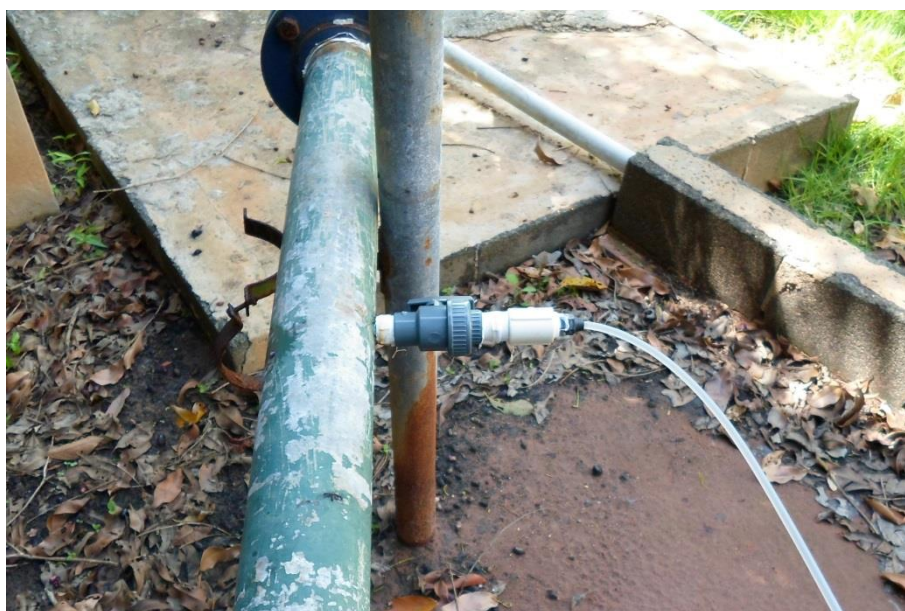
Figura 24 – Dosagem de Hipoclorito de Sódio no Sistema de Distribuição.
