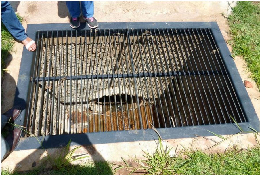
Figura 61 – Galeria de Águas Pluviais.
