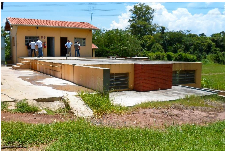
Figura 32 – Reservatório Semi-enterrado de 250 m 3 do Portal do Nobres.
