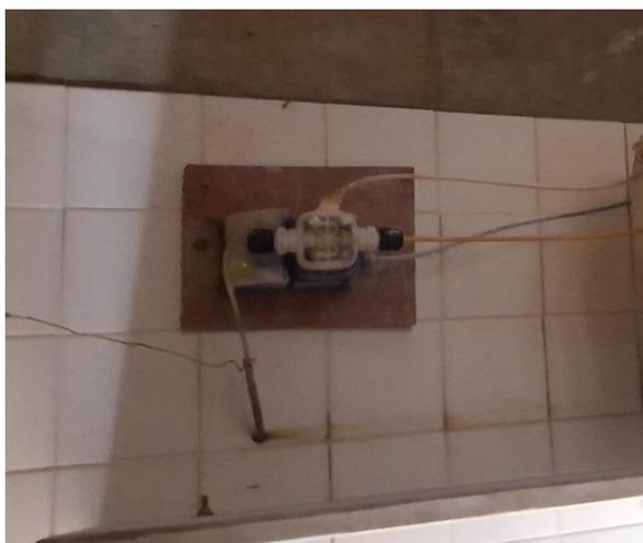
Foto 3.6 - Unidades de Fluoretação e Cloração com bomba dosadora – Reservatório 1.
