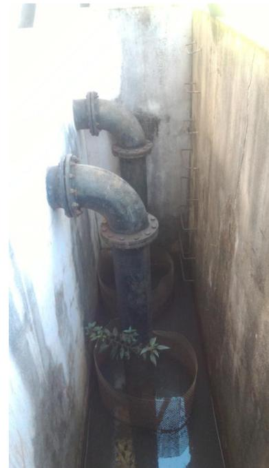
**Foto 3.2 – Poço de sucção de água bruta**
