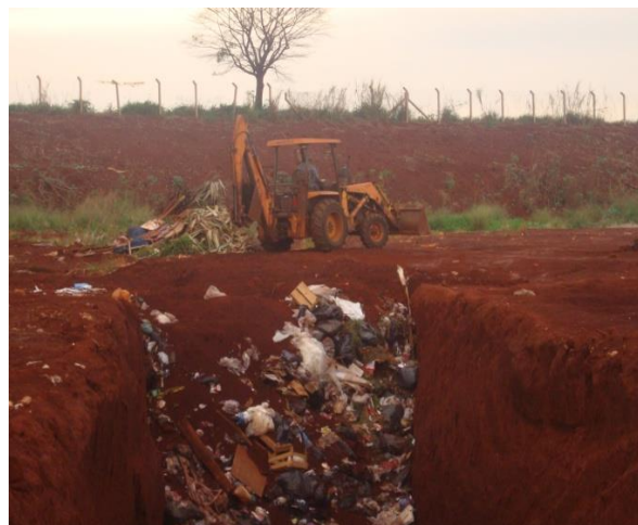
Figuras 42, 43, 44, 45, 46 e 47 - Aterro Sanitário do Município de Ipuã, localizado na zona rural, opera pelo sistema de valas de 03 metros de largura por 03 metros de profundidade. A impermeabilização é através de argila, já que toda área do Aterro Sanitário é composta de solo argiloso.
