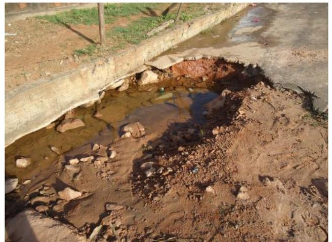
Foto 3.53 – Detalhe do prejuízo na via devido à erosão
