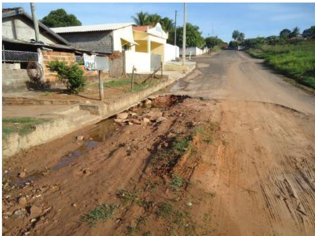
Foto 3.52 – Via atingida pela erosão
