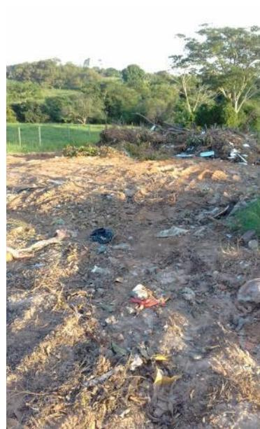
Foto 3.59 – Contenção da erosão com resíduos de construção civil
