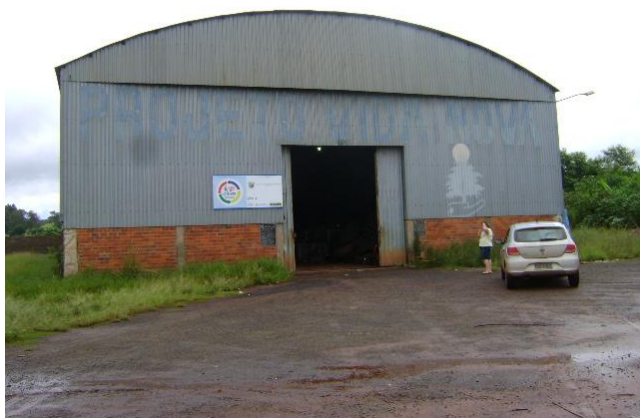
FOTO 4.18 GALPÃO DE COLETA SELETIVA.
