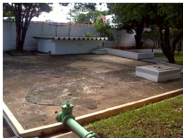
FOTO 4.8 – RESERVATÓRIO ENTERRADO DE 200 M 3 , ESCRITÓRIO SABESP ITAÍ.
