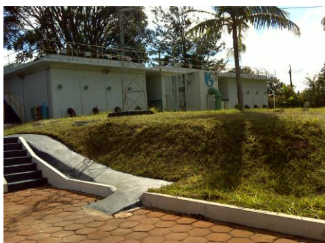
FOTO 4.3: MÓDULOS DA ETA DE ITAÍ.
