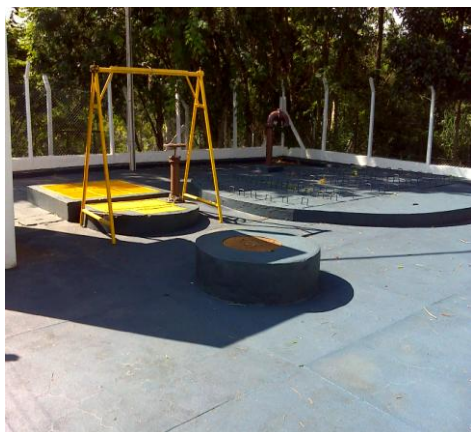
FOTO 4.14– ESTAÇÃO ELEVATÓRIA 01, JARDIM PLANALTO.
