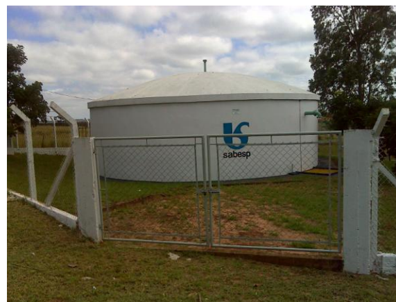
FOTO 4.10 – RESERVATÓRIO DE 500 M 3 , JARDIM MONTE ALTO, ITAÍ.
