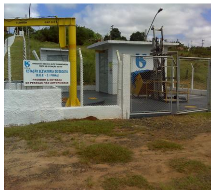
FOTO 4.15– ESTAÇÃO ELEVATÓRIA DE ESGOTO FINAL.
