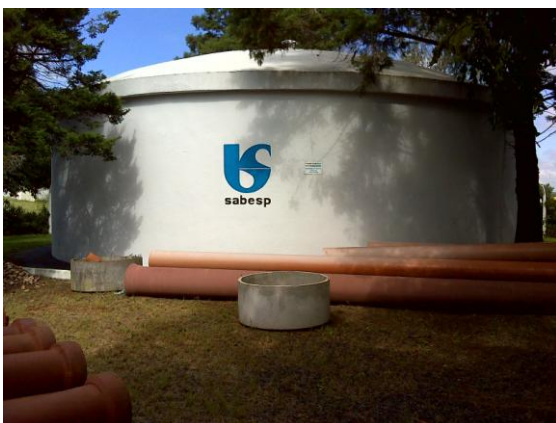
FOTO 4.9 – RESERVATÓRIO DE 500 M 3 , JARDIM NOVO HORIZONTE, ITAÍ.
