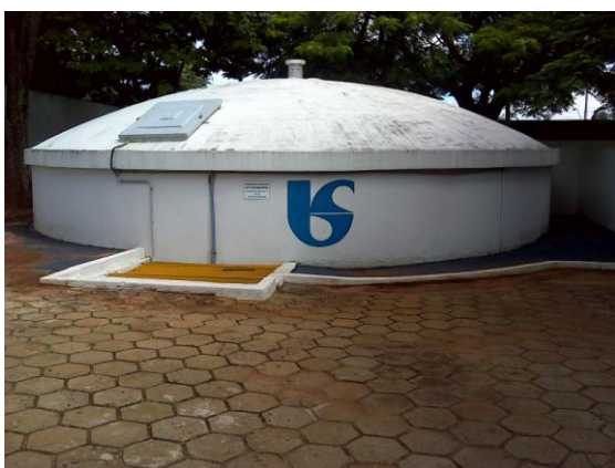
FOTO 4.7 – RESERVATÓRIO SEMI ENTERRADO DE 300M 3 , ESCRITÓRIO SABESP ITAÍ.
