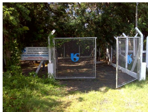
FOTO 4.1 - CAPTAÇÃO NO RIBEIRÃO CARRAPATOS.
