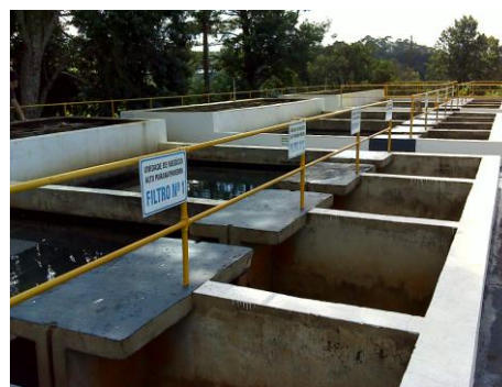
FOTO 4.4: VISTA DOS FLOCULADORES, DECANTADORES E FILTROS DOS TRÊS MÓDULOS DA ETA DE ITAÍ.
