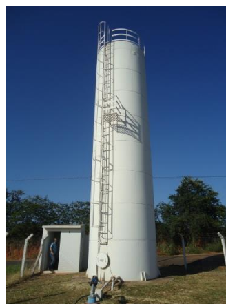
Foto 3.42 - Reservatório apoiado – R18
