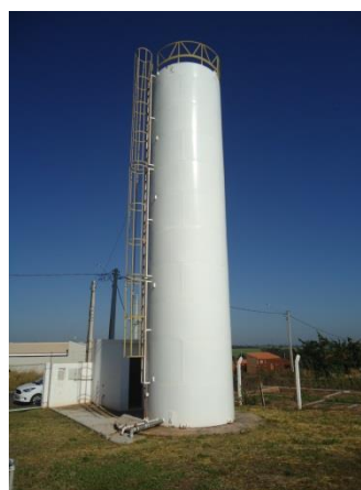
Foto 3.44 - Reservatório apoiado – R19
