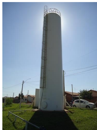
Foto 3.38 - Reservatório apoiado – R16
