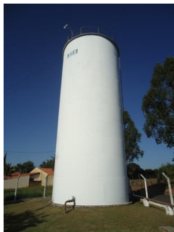
Foto 3.13 - Reservatório apoiado – R-09
