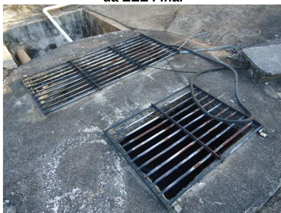
Foto 3.55 – Poço de sucção da EEE Final
