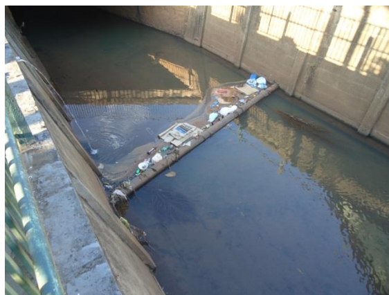
Foto 3.50 – Travessia da rede coletora para descarga no coletor Rio Monjolinho - MD
