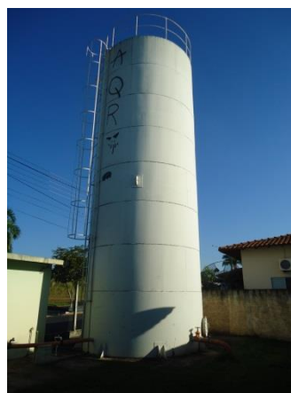
Foto 3.32 - Reservatório apoiado – R13
