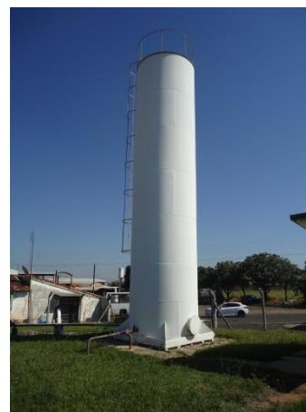
Foto 3.19 - Reservatório apoiado – R-06
