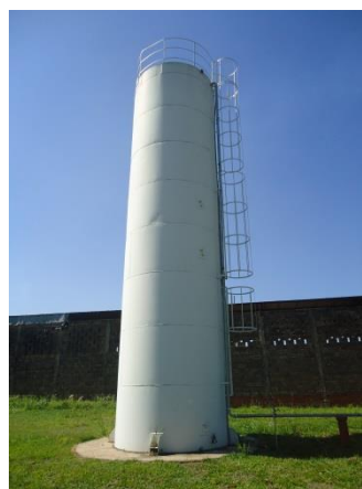
Foto 3.40 - Reservatório apoiado – R17
