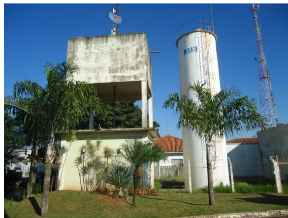
Foto 3.28 - Reservatório apoiado – R11
