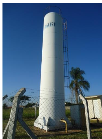
Foto 3.30 - Reservatório apoiado – R12
