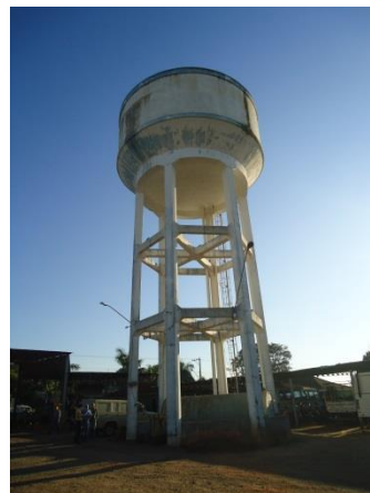
Foto 3.6 – Reservatório elevado R-01
