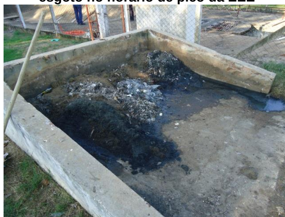
Foto 3.56 – Condicionamento dos resíduos retirados do tratamento preliminar
