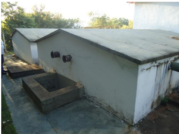
Foto 3.5 – Reservatório Semienterrado R-02
