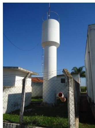
Foto 3.26 - Reservatório apoiado – R11
