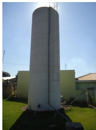
Foto 3.36 - Reservatório apoiado – R15
