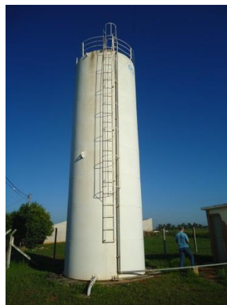
Foto 3.34 - Reservatório apoiado – R14
