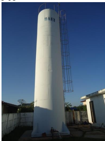
Foto 3.9 – Reservatório apoiado – R-03
