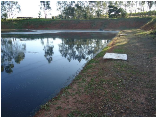
Foto 3.57 – Vista geral – Lagoa anaeróbia
