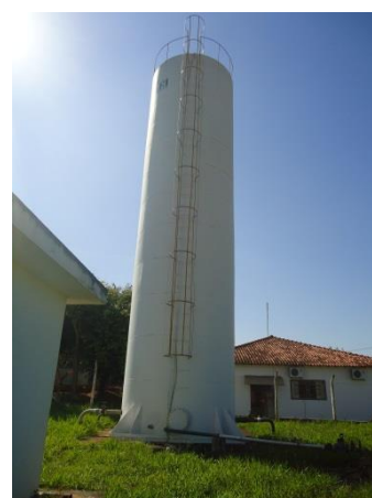
Foto 3.21 - Reservatório apoiado – R-07
