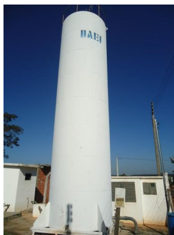
Foto 3.24 – Reservatório apoiado – R-08
