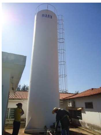
Foto 3.16 – Reservatório apoiado - R-05
