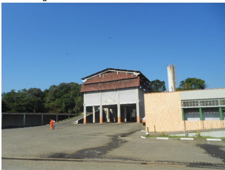
Foto 1- Estação de transbordo, vista geral Fonte: Prefeitura, 2014
