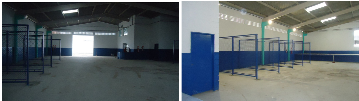
Foto 10 - Vista interna do Galpão – Foto de 2012 Fonte: Prefeitura de Itanhaém Foto 11 - Vista interna do Galpão - Foto de 2012 Fonte: Prefeitura de Itanhaém
