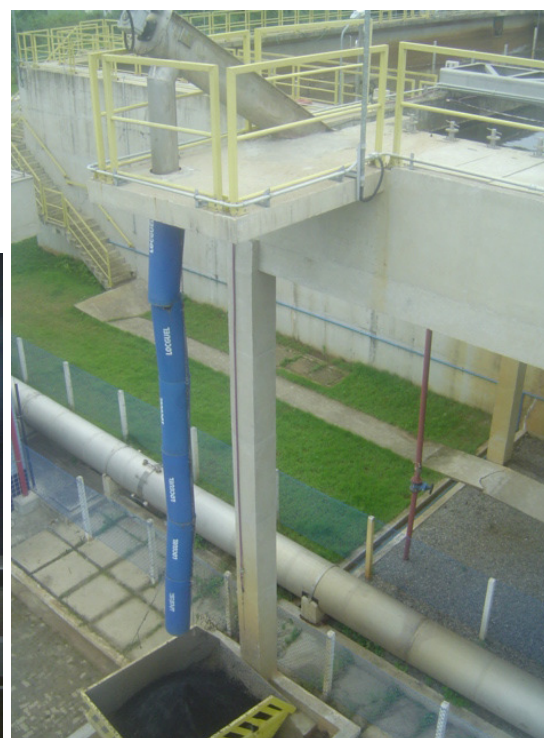
Foto 22- Detalhe da retirada de areia da ETE – Fonte: Prefeitura
