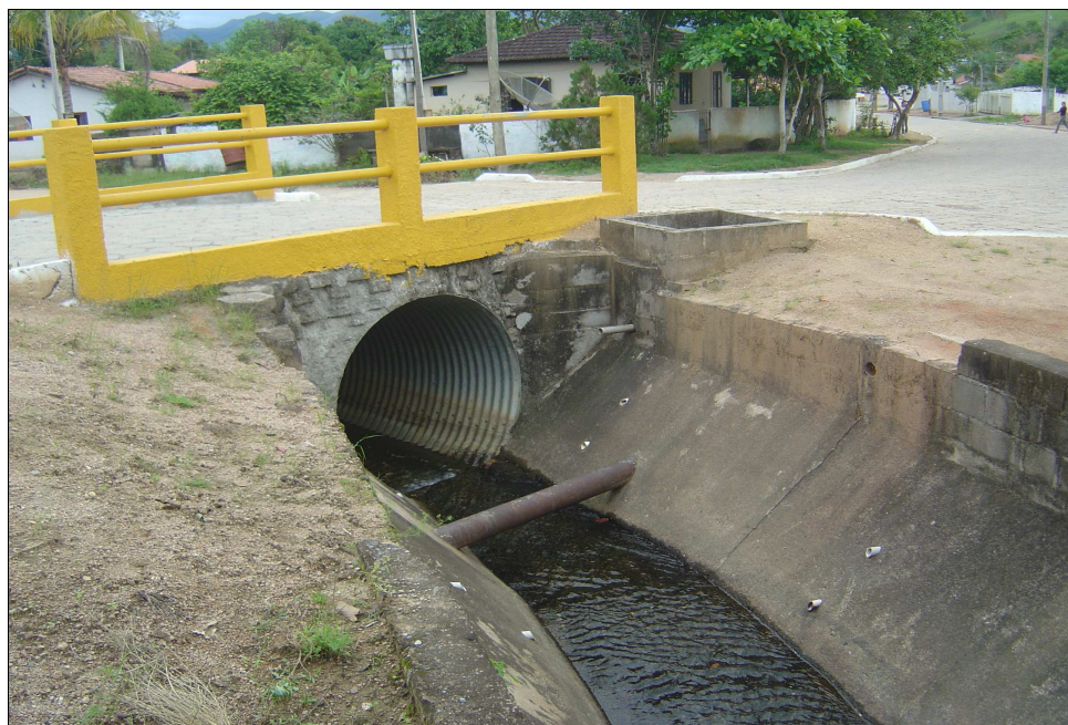
Foto 1 – Travessia do Córrego da Figueira (trecho canalizado)
