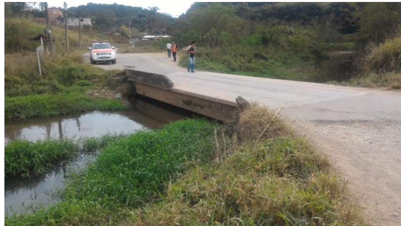
Foto 3.21 – Ponte sobre Rio Embu Mirim
