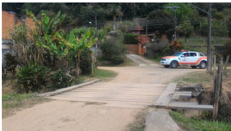
Foto 3.27 – Ponte sobre rio Embu Mirim
