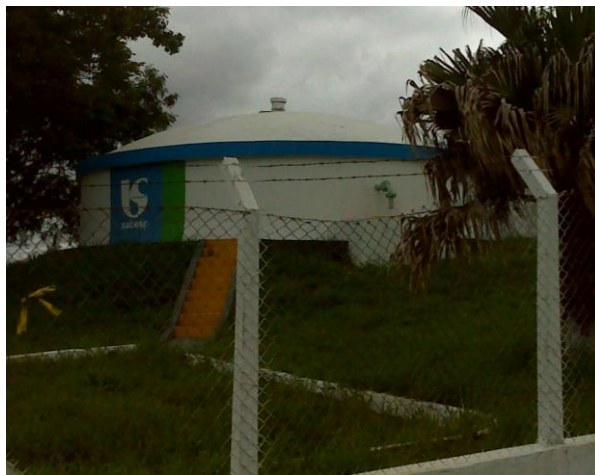
FOTO 4.44: RESERVATÓRIO – DISTRITO RECHAN
