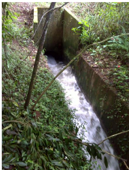
FOTO 4.76 E 4.77: LANÇAMENTO DO EFLUENTE FINAL TRATADO NO RIBEIRÃO PONTE ALTA
