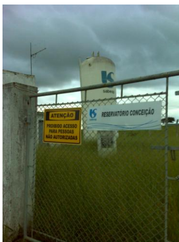
FOTO 4.52: RESERVATÓRIO – DISTRITO CONCEIÇÃO
