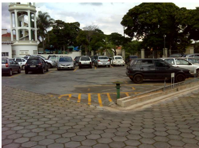
FOTO 4.24: RESERVATÓRIO – ETA – ESTACIONAMENTO
