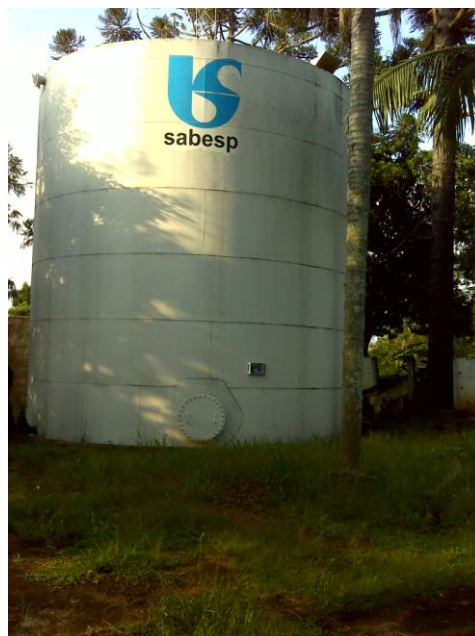
FOTO 4.23: RESERVATÓRIO - CHAPADA GRANDE
