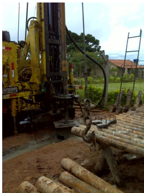
FOTO 4.35: POÇO PROFUNDO EM FASE DE PERFURAÇÃO – BAIRRO BISCOITO DURO.
