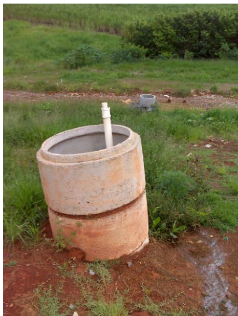
FOTOS 4.109 E 4.110: ATERRO SANITÁRIO - TUBULAÇÃO COLETORA DE GÁS
