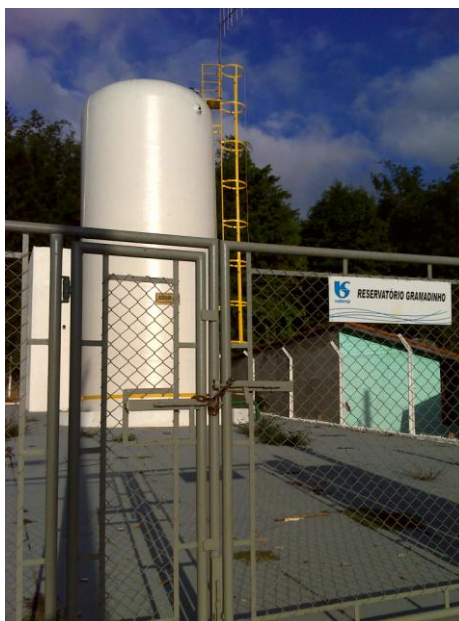
FOTO 4.40: RESERVATÓRIO – DISTRITO GRAMADINHO
