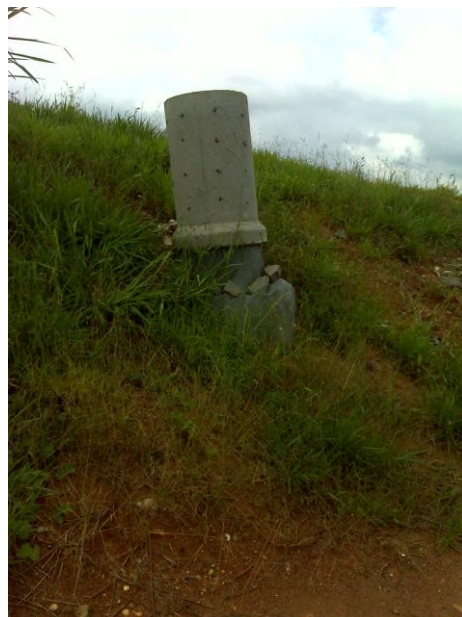
FOTOS 4.109 E 4.110: ATERRO SANITÁRIO - TUBULAÇÃO COLETORA DE GÁS
