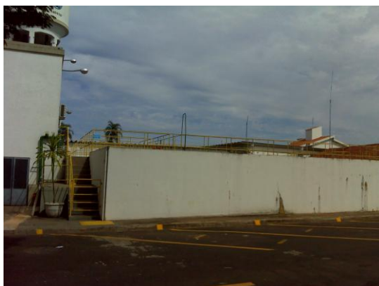
FOTO 4.4 - ESTAÇÃO DE TRATAMENTO DE ÁGUA-ETA 1
