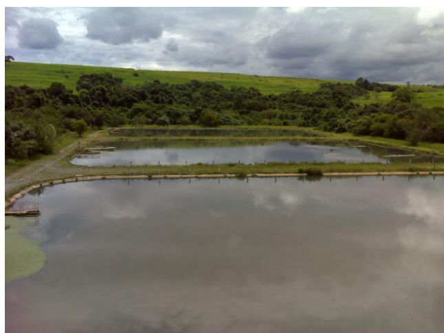
FOTOS 4.72 E 4.73: ETE – SISTEMA SEDE - LAGOAS DE SEDIMENTAÇÃO
