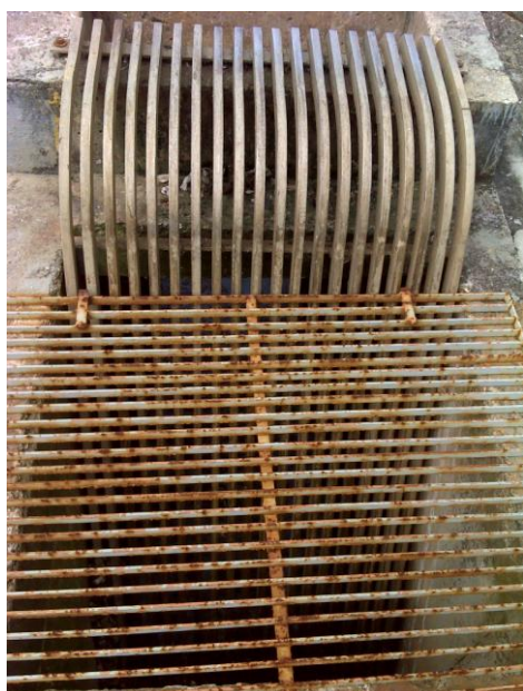
FOTO 4.65: SISTEMA SEDE - EEE FINAL – GRADEAMENTO MANUAL
