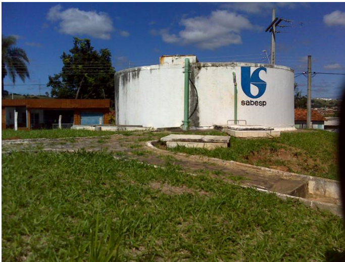
FOTO 4.33 - VISTA DO RESERVATÓRIO R13 - VILA SÃO BENEDITO
