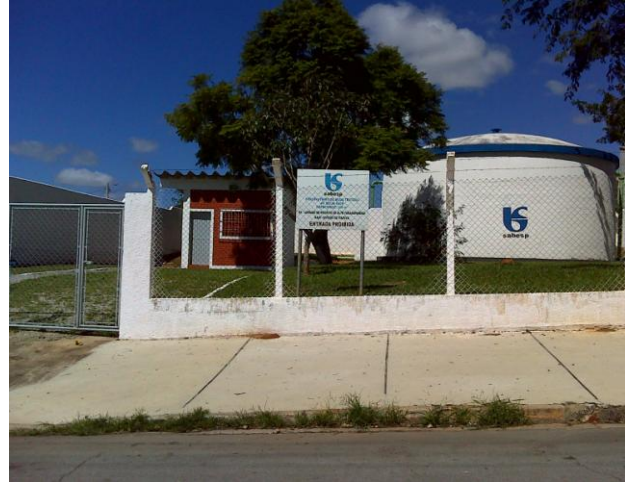
FOTO 4.32 – VISTA DO RESERVATÓRIO R10 - JARDIM BEIJA-FLOR / NOVA ITAPEVA
