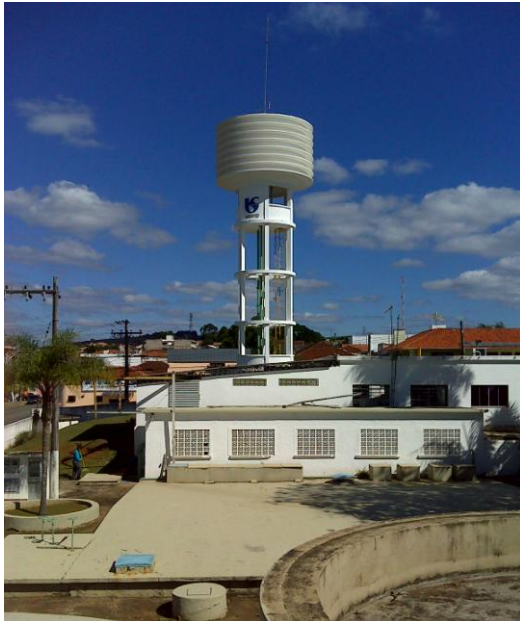
FOTO 4.23 – VISTA DO RESERVATÓRIO ELEVADO T2 DA ÁREA CENTRAL - SEDE
