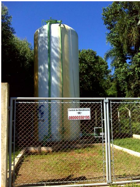
FOTO 4.41 - VISTA DO RESERVATÓRIO DE AMARELA VELHA
