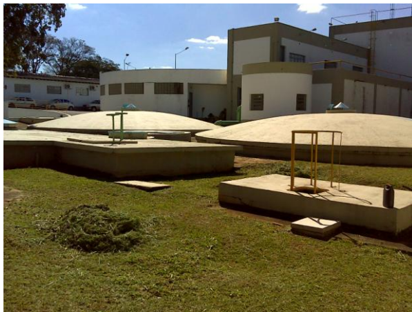
FOTO 4.21 - VISTA DOS RESERVATÓRIOS R1 E R2 DA ÁREA CENTRAL – SEDE
