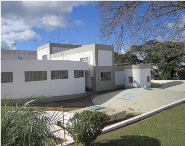
FOTO 4.5 - VISTA DA ETA SEDE
