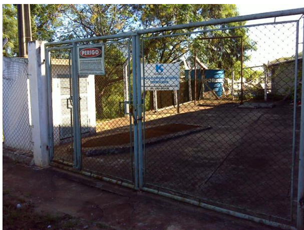
FOTO 4.51 – VISTA DA EEE 03- CIMENTOLÂNDIA
