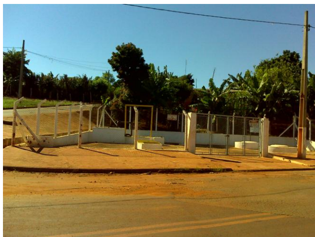
FOTO 4.49 – VISTA GERAL DA EEE 01- SANTA MARIA
