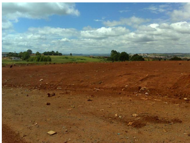
FOTO 4.59 – VISTA DO ATERRO CONTROLADO DE ITAPEVA PRONTA PARA O PLANTIO DE ÁRVORES
