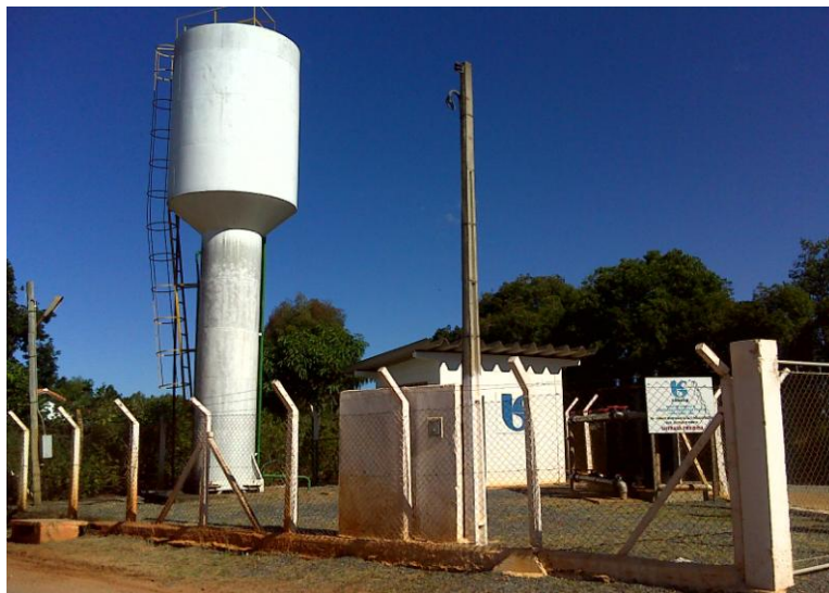
FOTO 4.44 - VISTA DO RESERVATÓRIO DO BAIRRO DAS PEDRAS E DA CASA DE QUÍMICA
