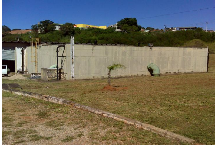
FOTO 4.20- VISTA DO RESERVATÓRIO R8 - ETA PILÃO
