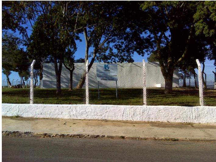
FOTO 4.25 - VISTA DO RESERVATÓRIO R6 - JARDIM MARINGÁ
