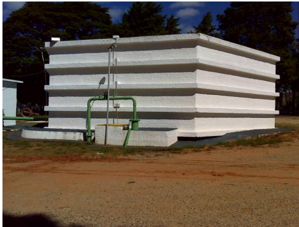
FOTO 4.29 - VISTA DO RESERVATÓRIO R4
