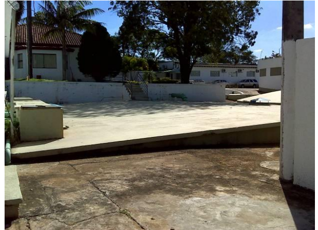
FOTO 4.22 - VISTA DO RESERVATÓRIO R3 DA ÁREA CENTRAL - SEDE
