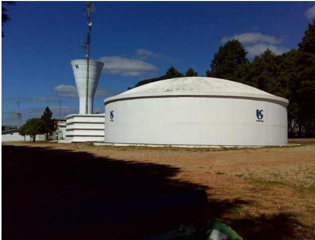
FOTO 4.27 - VISTA DO CENTRO DE RESERVAÇÃO VILA NOVA
