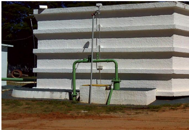
FOTO 4.14 – DETALHE DA EEAT ELEVADO VILA NOVA
