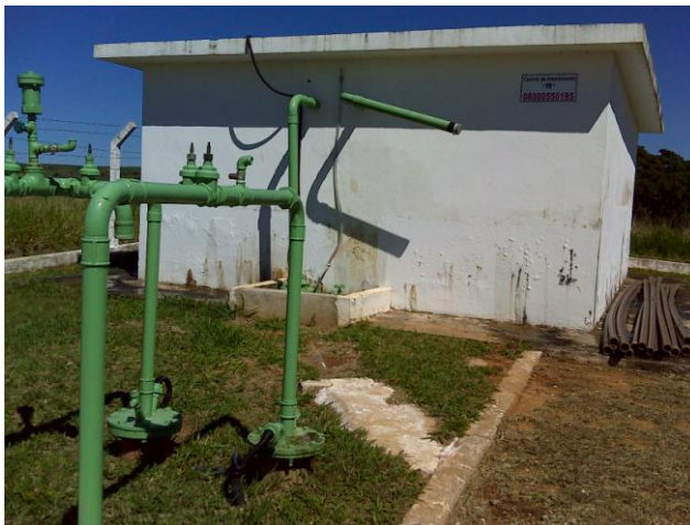
FOTO 4.36 - VISTA DO RESERVATÓRIO DE GUARIZINHO
