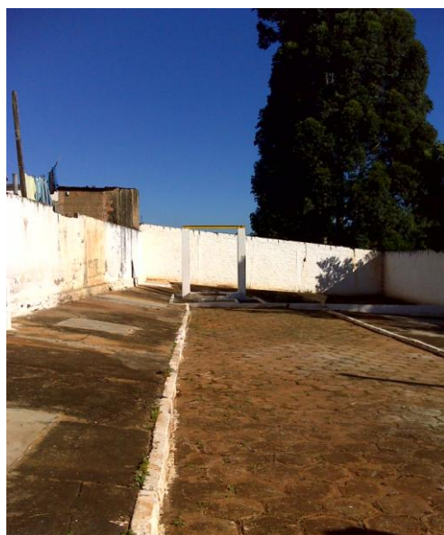
FOTO 4.52 – VISTA GERAL DA EEE 04 – SÃO FRANCISCO
