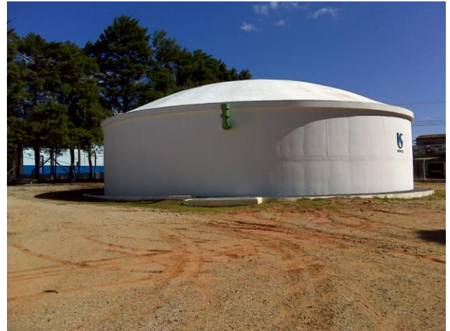
FOTO 4.28 – VISTA DO RESERVATÓRIO R9
