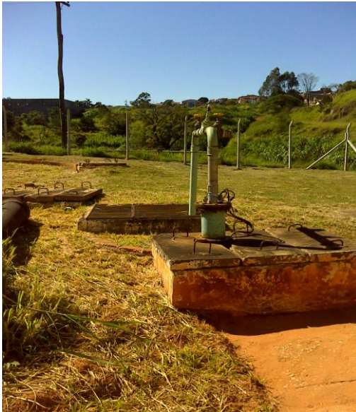
FOTO 4.10 – DETALHE DA EEAT VILA SANTA MARIA
