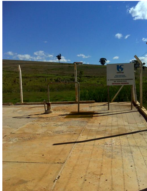
FOTO 5.43 – VISTA DO POÇO PROFUNDO DE BAIRRO DAS PEDRAS
