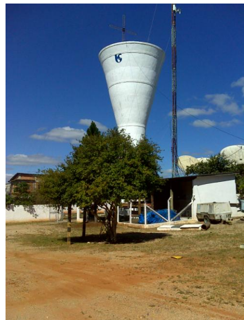
FOTO 4.30 – VISTA DO RESERVATÓRIO ELEVADO T1 DA VILA NOVA
