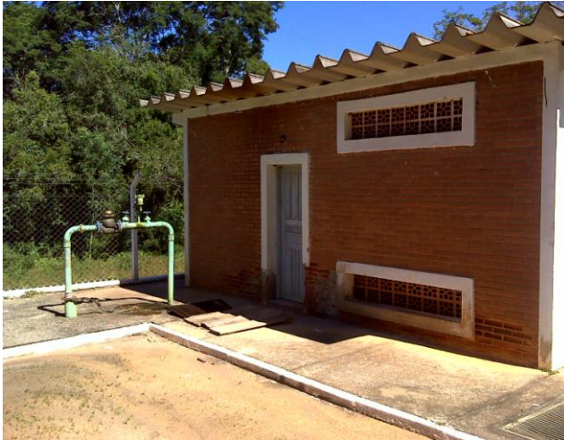
FOTO 4.47 – VISTA DO POÇO PROFUNDO DE ALTO DA BRANCAL
