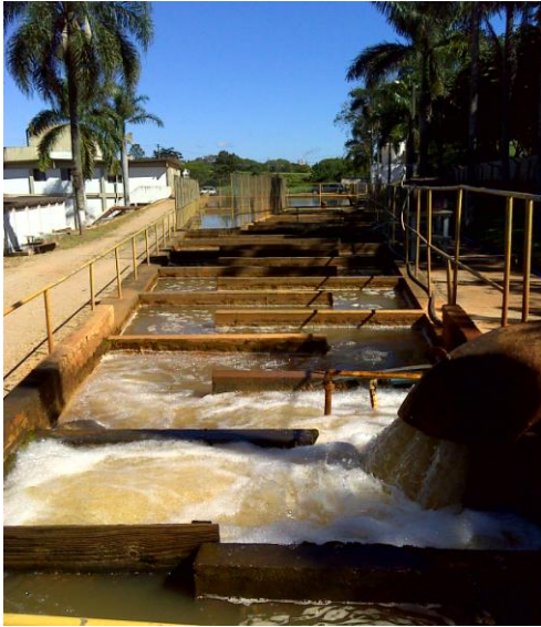
FOTO 4.1 – VISTA DA CHEGADA DA ÁGUA BRUTA NA ETA PILÃO D'ÁGUA
