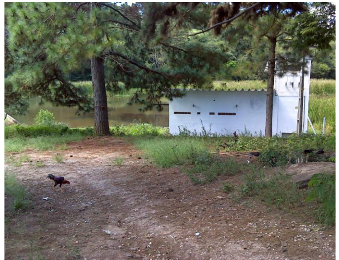
FOTO 4.2 - VISTA DA EEAB – CÓRREGO DO ARANHA
