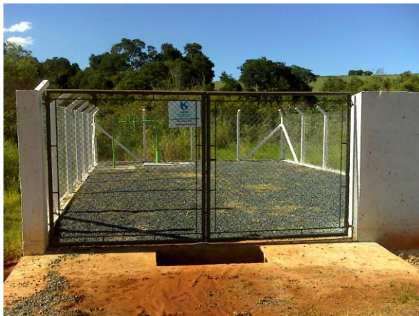
FOTO 4.45– VISTA DO POÇO PROFUNDO DE PACOVA
