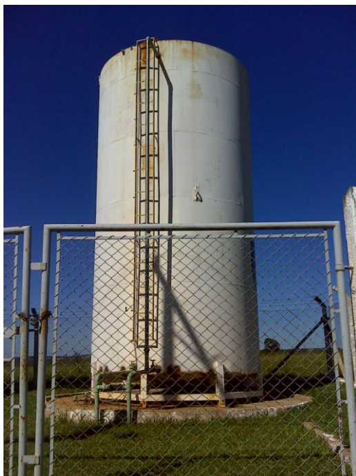
FOTO 4.24 - VISTA DO RESERVATÓRIO R15 – BAIRRO DE CIMA
