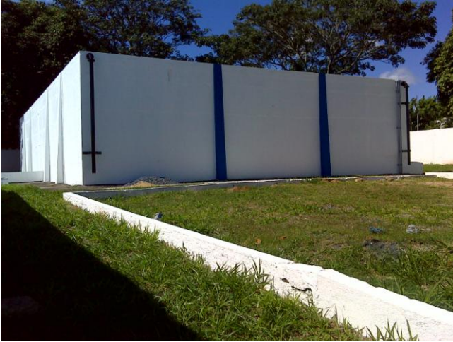
FOTO 4.31 - VISTA DO RESERVATÓRIO R7 - VILA APARECIDA
