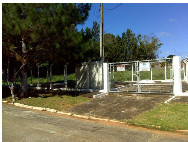
FOTO 4.54 – VISTA GERAL DA EEE 06 – VILA CAMARGO
