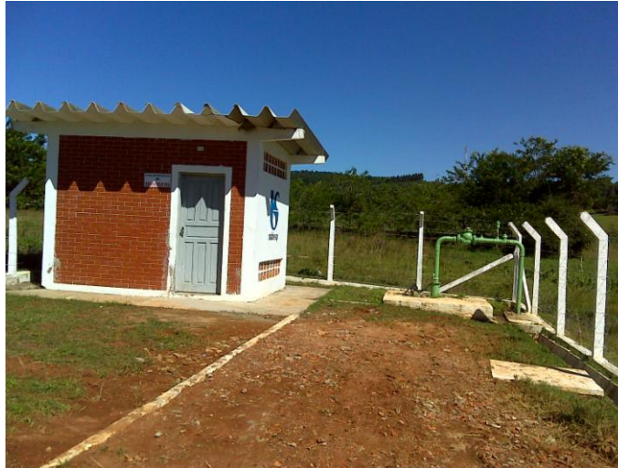
FOTO 4.34 – VISTA DO POÇO PROFUNDO PPS-01 DE GUARIZINHO
