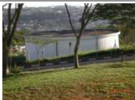
Foto nº 29 – Reservatório R9 - Setor Vila Ilze
