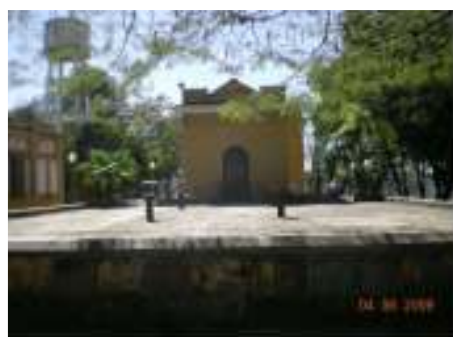
Foto nº 25 – Reservatório R3 – Parque Juca Mulato
