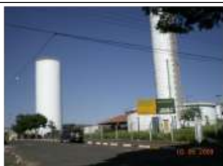
Foto nº 32– Reservatório R12 (apoiado), R13 (metálico) e R14 (anéis de concreto) – Setor Prados
