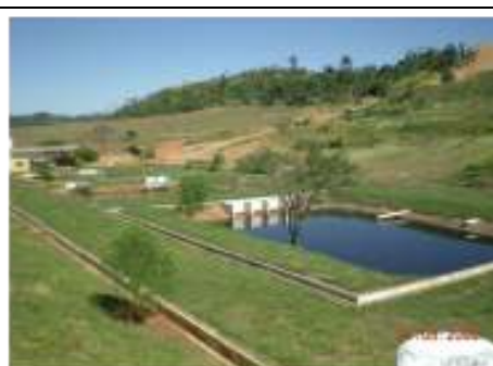
Foto nº 78 – Vista geral do aterro e de área passível de ser utilizada para expansão.
