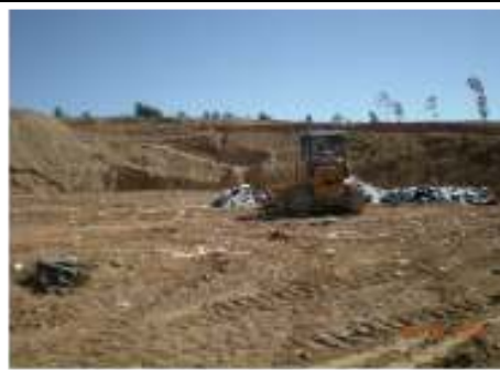
Foto nº 74 – Vista da plataforma de aterramento de lixo
