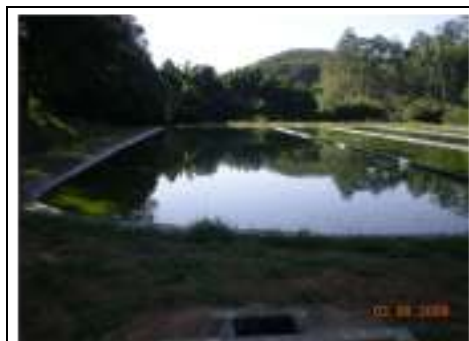
Foto nº 72 – ETE – Lagoa facultativa
