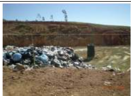
Foto nº 75 – Vista da plataforma de aterramento e do dreno de gás.
