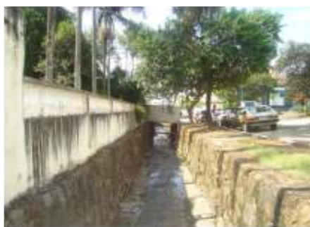
Foto nº 87 – Vista do Canal do Córrego Lavapés – Rua 7 de Setembro
