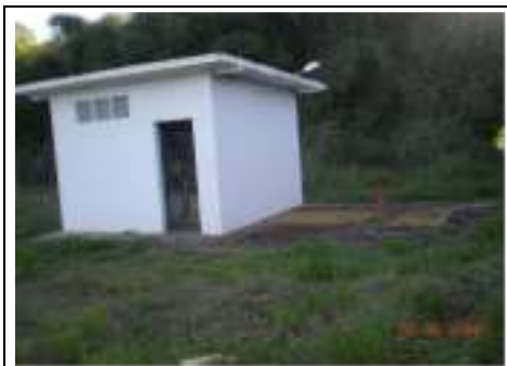
Foto nº 63 – ETE – Gradeamento e elevatória de esgoto
