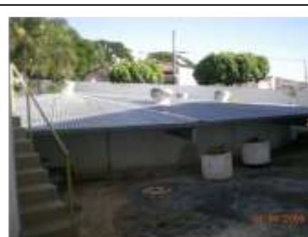
Foto nº 22 – Reservatório R1 - ETA
