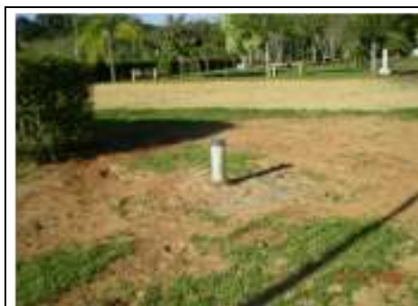
Foto nº 46 – Poço tubular profundo – PT-02 – ainda não operacionalizado - Eleutério
