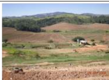
Foto nº 76 – Vista dos taludes e da lagoa de tratamento de chorume.
