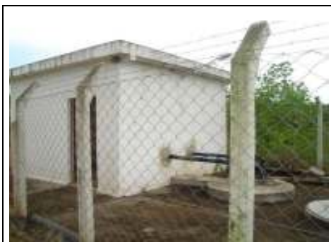
Foto nº 55 – ETE-09 – Mário Cega
