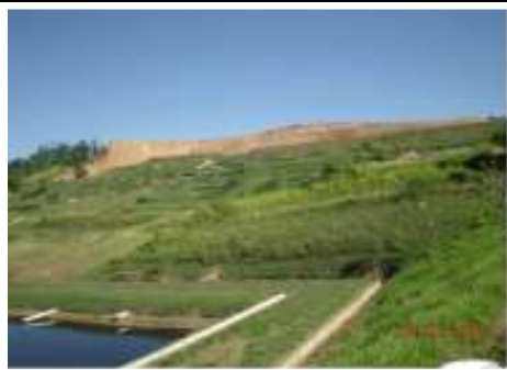
Foto nº 73 – Vista geral do aterro sanitário
