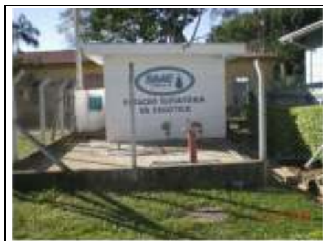
Foto nº 70 – Elevatória de esgoto EEE-02
