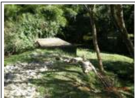
Foto nº 67 – ETE – Tanque Séptico – área central do Distrito
