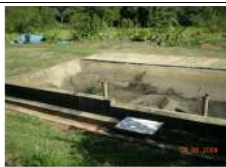
Foto nº 58 – ETE – Leitões de secagem de lodo
