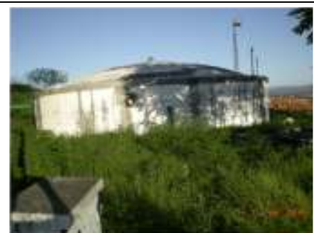
Foto nº 30– Reservatório R10 - Setor Vila Ilze
