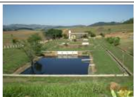
Foto nº 77 – Vista das lagoas de tratamento e do galpão de serviço.
