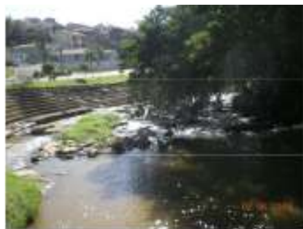
Foto nº 2 – Captação Ribeirão da Penha – enrocamento de pedra
