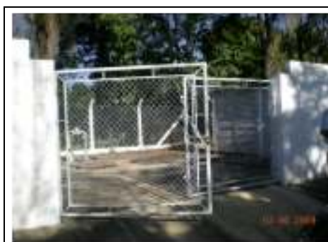
Foto nº 44 – Cabines para quadro de comando e dosagem de produtos químicos
