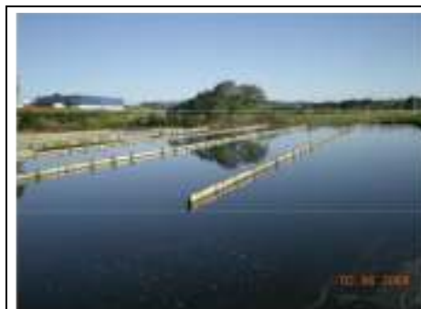
Foto nº 66 – ETE – Lagoa facultativa
