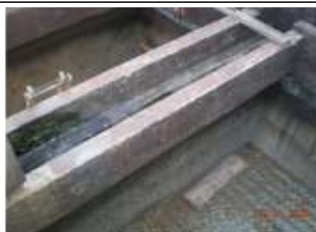
Foto nº 12 – ETA – detalhe do fundo do filtro 1 paralizado para substituição do leito
