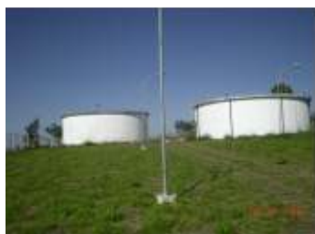
Foto nº 27 – Reservatório R5 e R6 – Setor Santa Bárbara
