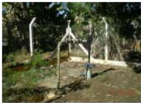
Foto nº 33 – Poço tubular profundo – PT-01 – Ataliba Nogueira
