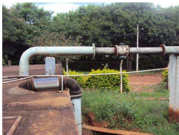
Figura 31. Tubulações de entrada do reservatório do Antigo Matadouro.
