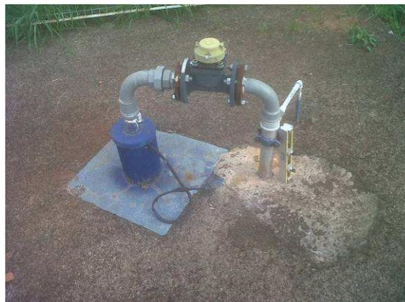
Figura 22. Poço Alvorada – Distrito de Tapinas, não foi possível medir pois o cavalete é curto.
