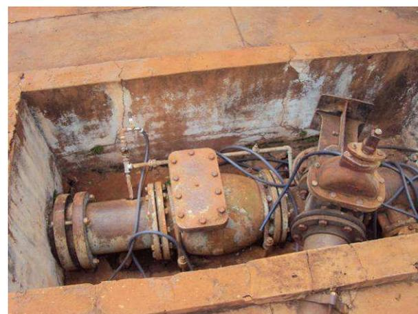
Figura 41. Tubulação de recalque dos dois conjuntos motor-bombas existentes no reservatório do Antigo Matadouro.
