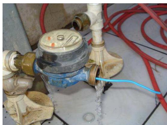
Figura 38. Hidrômetro com arame.
