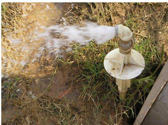
Figura 33. Cavalete sem hidrômetro.
