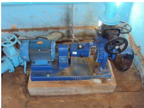
Figura 59. Vista do conjunto motor-bomba nº. 1 da casa de bombas que recalca para o reservatório elevado da Primavera.
