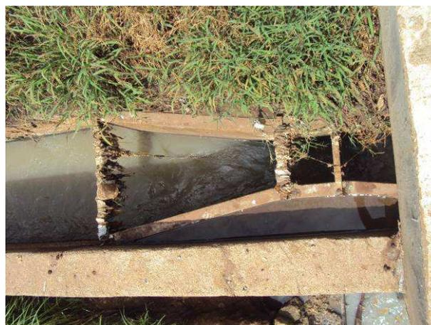
Figura 9. Calha Parshall existente na elevatória de esgoto de Itápolis.
