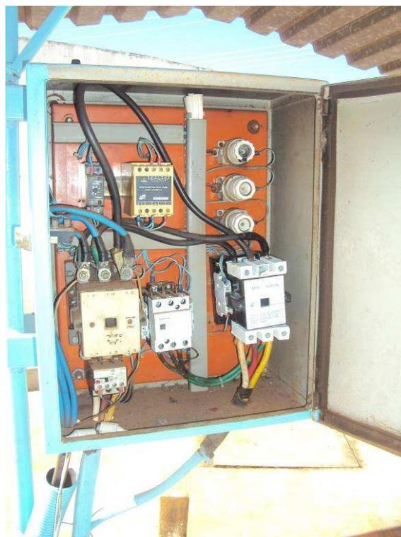
Figura 68. Vista do painel elétrico do conjunto motor-bomba que recalca do reservatório apoiado R1 para a zona alta de abastecimento.
