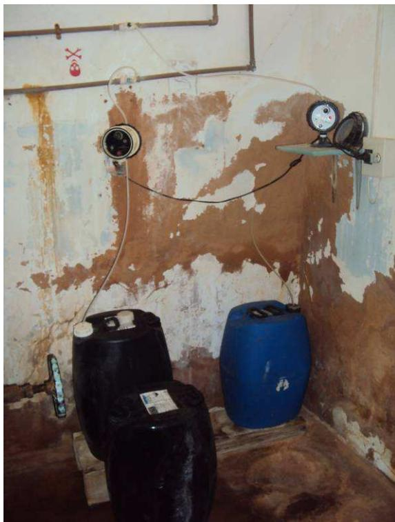
Figura 20. Vista dos dosadores de hipoclorito de sódio e ácido fluossilícico do poço FAITA.
