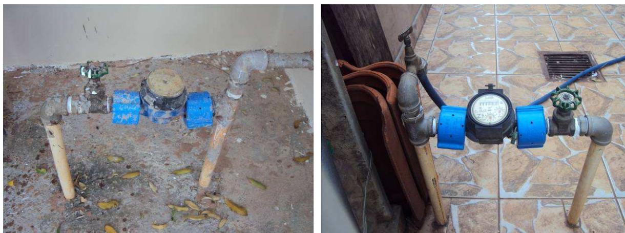
Figura 55. Hidrômetros instalados no sistema de abastecimento de água de Itápolis com lacres.
