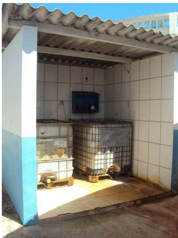
Figura 73. Abrigo dos produtos químicos (hipoclorito de sódio e ácido fluossilícico) do sistema de reservação do Primavera.
