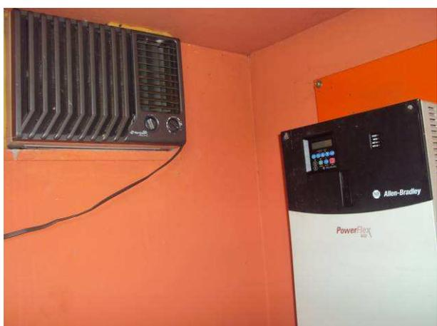
Figura 11. Abrigo climatizado onde está situado o painel elétrico da elevatória de esgoto de Itápolis.
