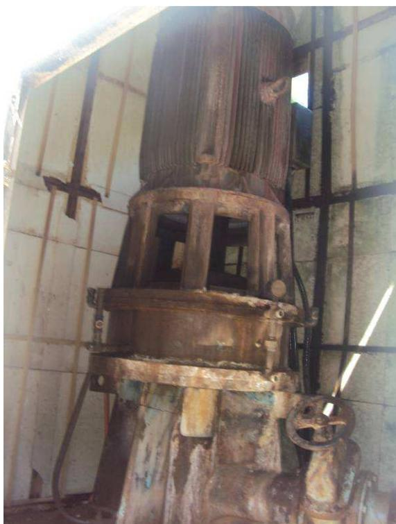
Figura 45. Conjunto motor-bomba de eixo vertical do Poço Primavera.
