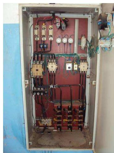
Figura 62. Vista do painel elétrico do conjunto motor-bomba nº. 1 que recalca para o reservatório elevado da Primavera.
