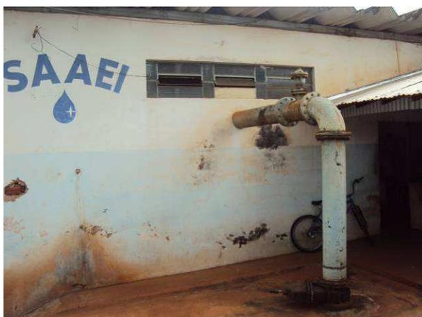
Figura 40. Tubulação de recalque dos dois conjuntos motor-bombas existentes no reservatório do Antigo Matadouro.
