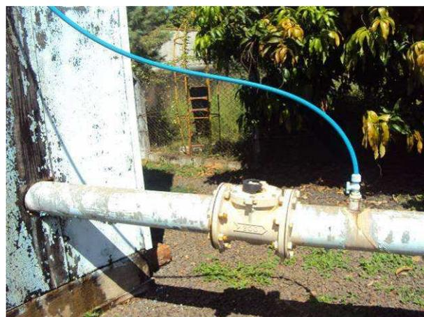
Figura 46. Macromedidor existente no recalque do Poço Primavera.
