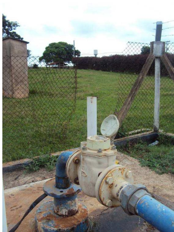
Figura 111. Vista do macromedidor do Poço Ticão.
