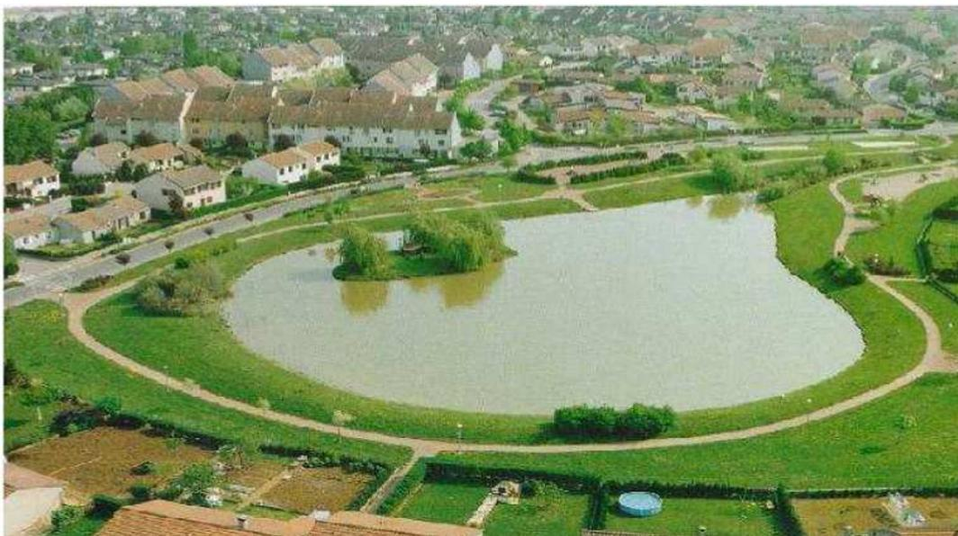
Figura 85. Bacia de detenção alagada com volume de espera para controle de enchente e áreas de recreação e lazer.
