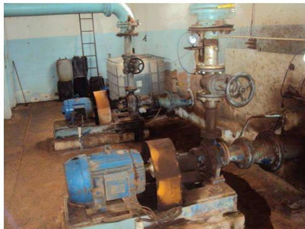
Figura 33. Vista dos dois conjuntos motor-bombas existentes no recalque do reservatório do Antigo Matadouro.
