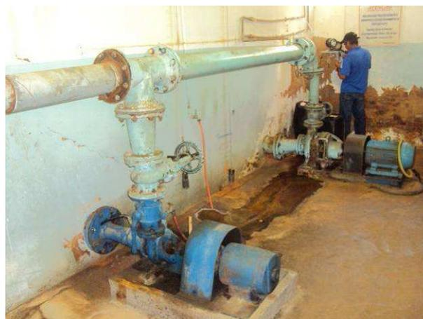
Figura 17. Vista dos dois conjuntos motor-bombas que recalcam do reservatório FAITA para a rede de distribuição.
