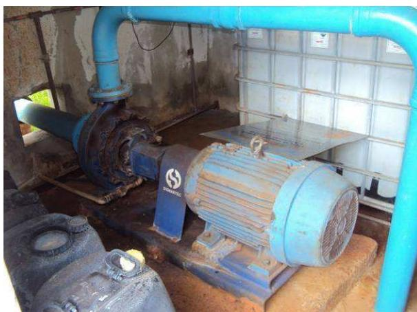
Figura 78. Vista do conjunto motor-bomba do recalque do reservatório Jardim 2000.
