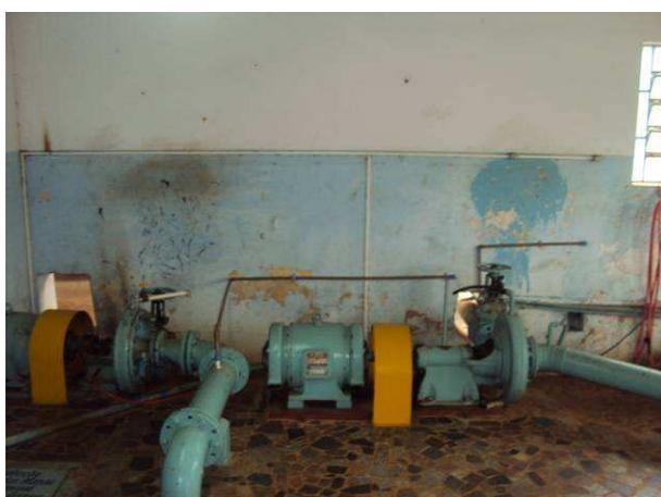
Figura 91. Conjuntos motor-bomba existentes no Recalque Central.
