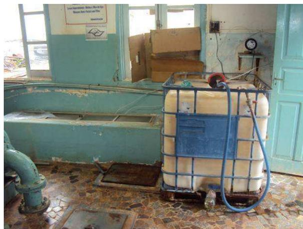
Figura 94. Reservatório de hipoclorito de sódio existente no sistema Recalque Central.
