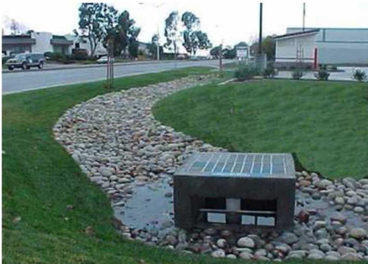
Figura 90. Trincheira de infiltração ao longo da rua.
