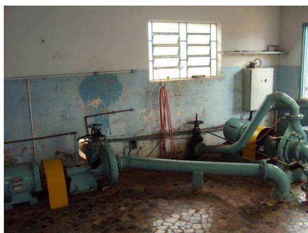
Figura 92. Conjuntos motor-bomba existentes no Recalque Central.
