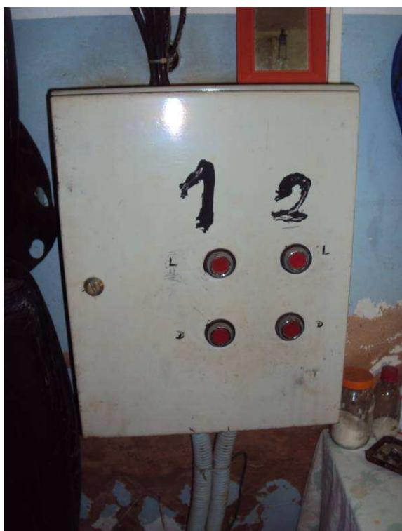
Figura 18. Vista do painel elétrico dos conjuntos motor-bombas do reservatório FAITA.
