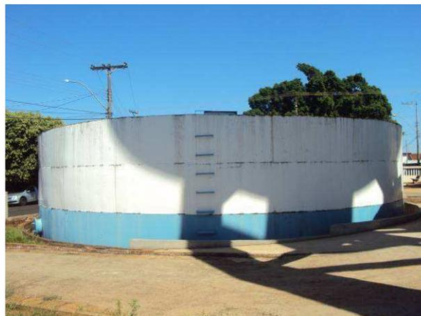
Figura 52. Vista do reservatório metálico apoiado de 500m<sup>3</sup> (R2).
