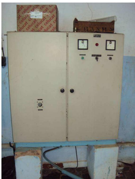
Figura 99. Vista do painel elétrico de um conjunto motor-bomba existente no sistema do Recalque Central.
