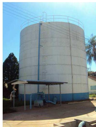
Figura 54. Vista do conjunto motor-bomba que recalca do reservatório apoiado R1 para o apoiado R6.
