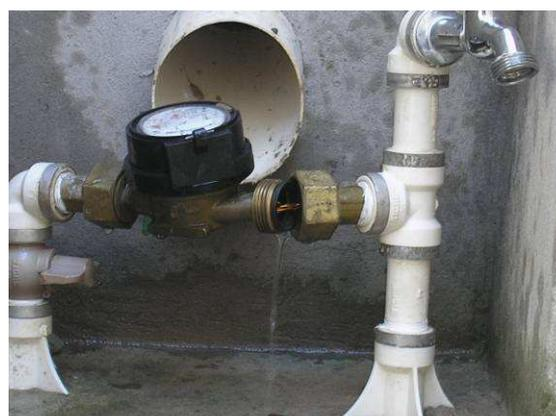
Figura 36. Hidrômetro com arame.
