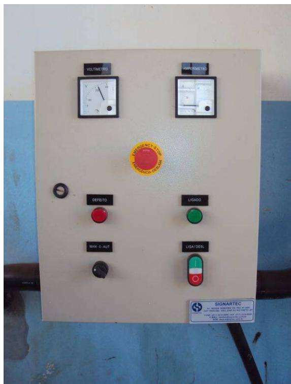
Figura 63. Vista do painel elétrico do conjunto motor-bomba n<sup>o</sup>. 2 que recalca para o reservatório elevado da Primavera.
