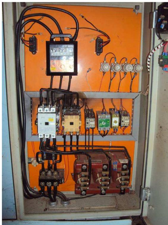
Figura 39. Vista interna do painel elétrico dos dois conjuntos motor-bombas existentes no reservatório do Antigo Matadouro.
