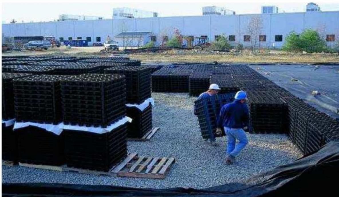
Figura 87. Reservatório de detenção enterrado.
