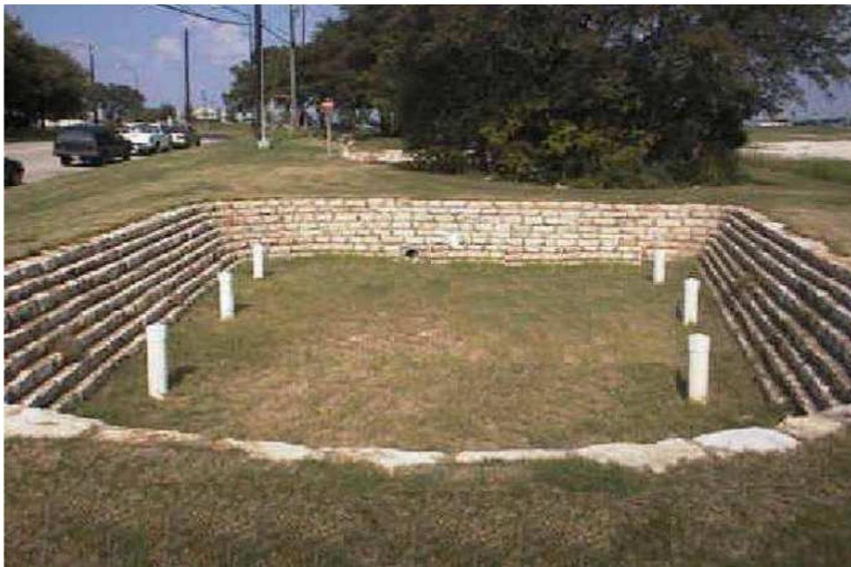
Figura 91. Reservatório de detenção para atendimento de uma pequena área.
