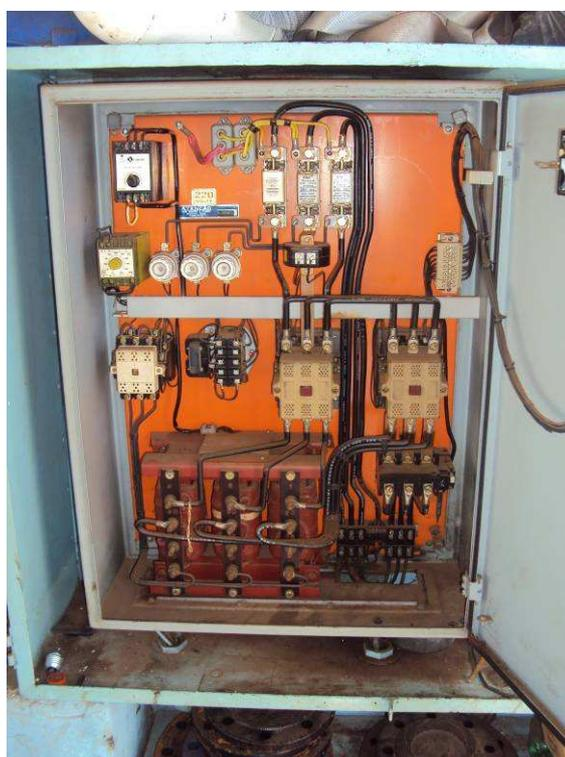
Figura 66. Vista do painel elétrico do conjunto motor-bomba que recalca do reservatório apoiado R1 para o apoiado R6.
