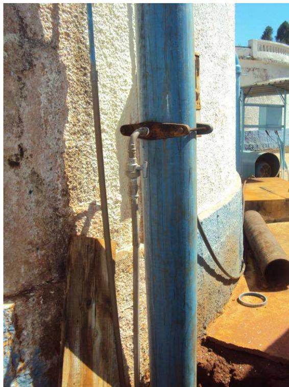
Figura 72. Ponto de dosagem de produto químico da água vindo do Poço Primavera.
