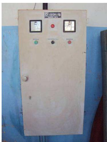
Figura 61. Vista do painel elétrico do conjunto motor-bomba nº. 1 que recalca para o reservatório elevado da Primavera.
