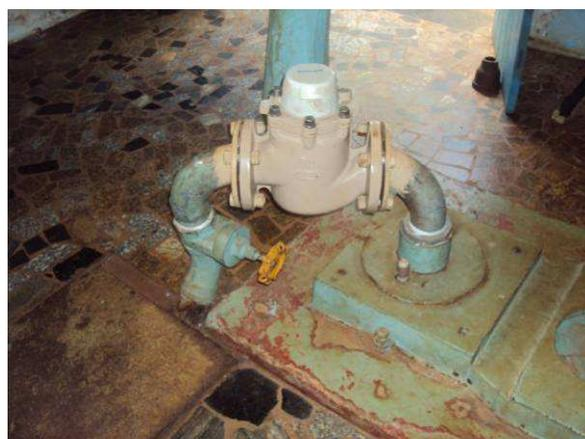
Figura 20. Poço Recalque Central, não foi possível medir pois o cavalete é curto.
