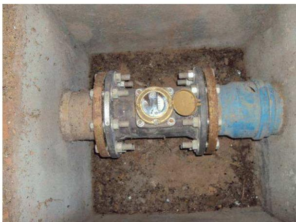
Figura 87. Vista da macromedidor existente na tubulação de chegada do recalque das águas superficiais
