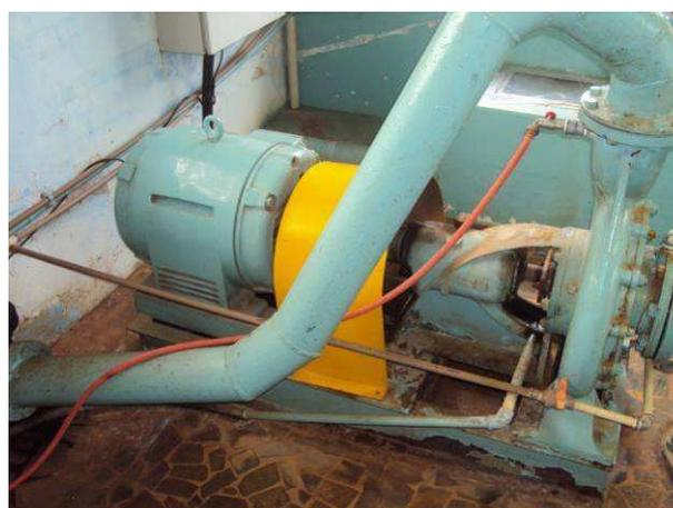
Figura 90. Conjunto motor-bomba existente no Recalque Central.
