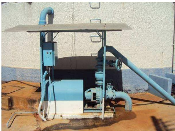
Figura 57. Vista do conjunto motor-bomba do recalque direto para a zona alta de abastecimento.
