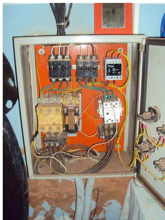
Figura 19. Vista interna do painel elétrico dos conjuntos motor-bombas do reservatório FAITA.
