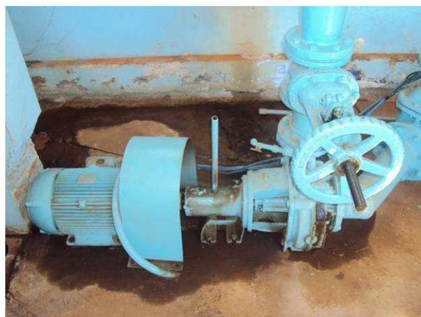
Figura 60. Vista do conjunto motor-bomba nº. 2 da casa de bombas que recalca para o reservatório elevado da Primavera.
