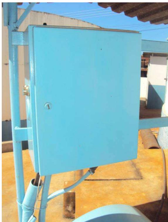
Figura 67. Vista do painel elétrico do conjunto motor-bomba que recalca do reservatório apoiado R1 para a zona alta de abastecimento.
