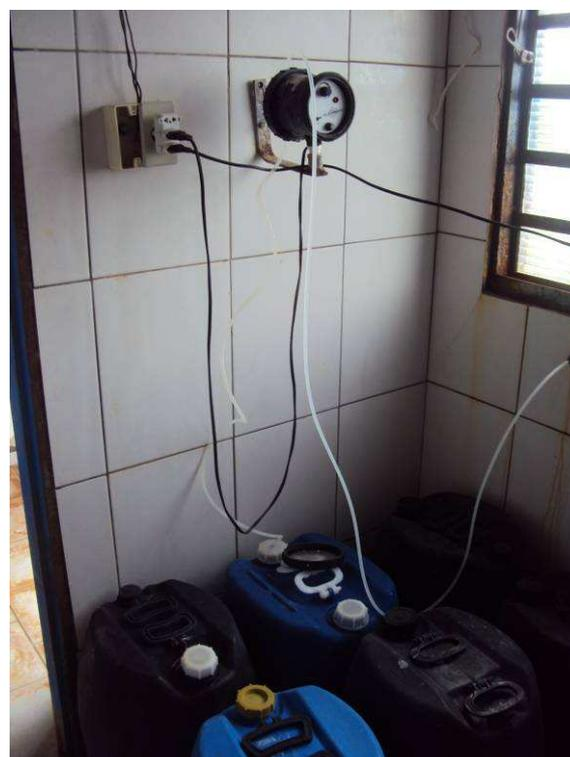
Figura 115. Dosador de ácido fluossilícico do poço Ticão.
