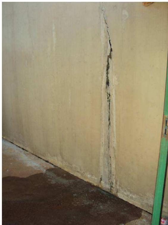
Figura 21. Vazamento existente no reservatório FAITA.
