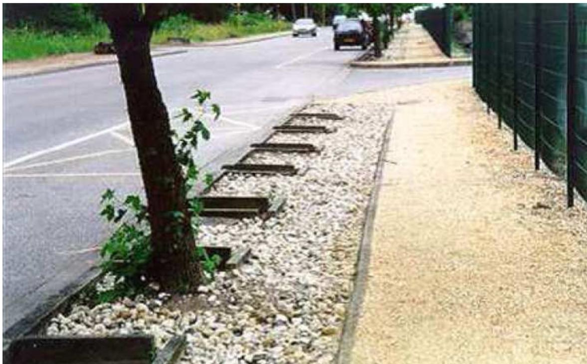
Figura 89. Trincheira de infiltração ao longo da rua.
