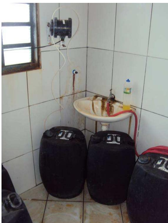
Figura 114. Dosador de hipoclorito de sódio do poço Ticão.
