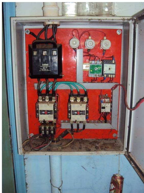
Figura 98. Vista do painel elétrico aberto de um conjunto motor-bomba existente no sistema do Recalque Central.
