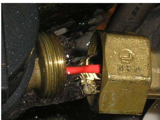
Figura 35. Hidrômetro com arame.
