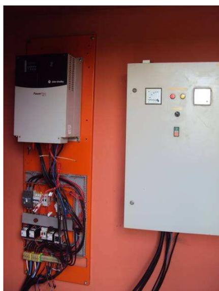
Figura 10. Painel elétrico da elevatória de esgoto existente no município de Itápolis.
