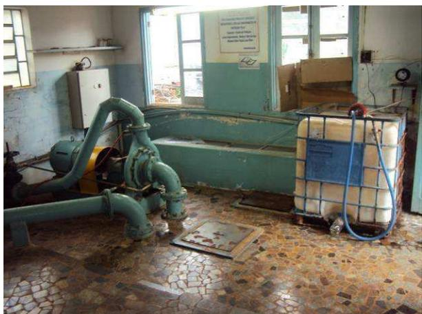
Figura 93. Conjunto motor-bomba existente no Recalque Central.
