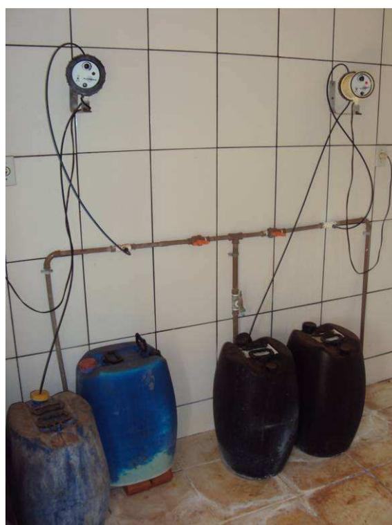
Figura 107. Vista dos dosadores de hipoclorito de sódio e ácido fluossilícico do sistema Jardim do Sol.
