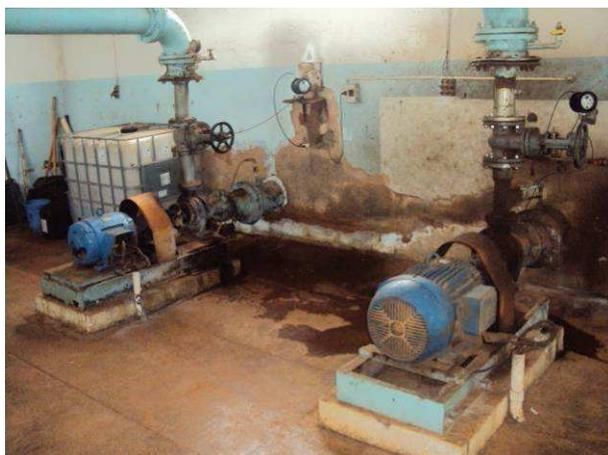
Figura 34. Vista dos dois conjuntos motor-bombas existentes no recalque do reservatório do Antigo Matadouro.
