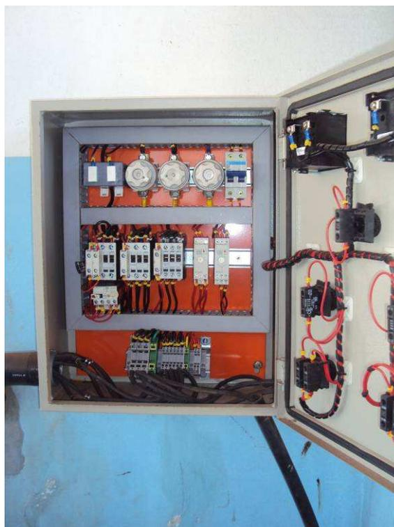
Figura 64. Vista do painel elétrico do conjunto motor-bomba n<sup>o</sup>. 2 que recalca para o reservatório elevado da Primavera.
