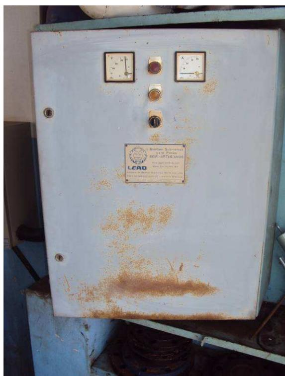
Figura 65. Vista do painel elétrico do conjunto motor-bomba que recalca do reservatório apoiado R1 para o apoiado R6.
