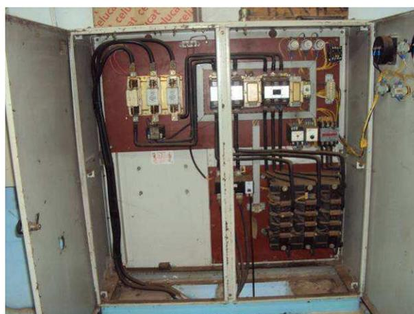
Figura 100. Vista do painel elétrico aberto de um conjunto motor-bomba existente no sistema do Recalque Central.
