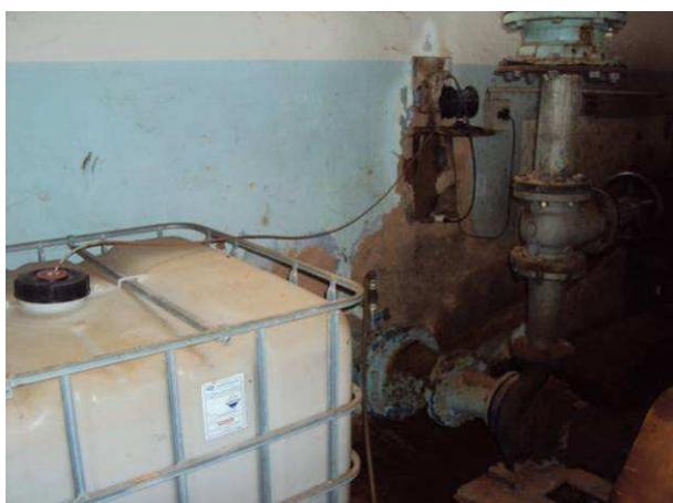
Figura 36. Dosador de hipoclorito de sódio existente no reservatório do Antigo Matadouro.
