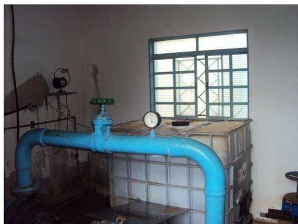
Figura 79. Manômetro instalado no recalque do reservatório Jardim 2000.
