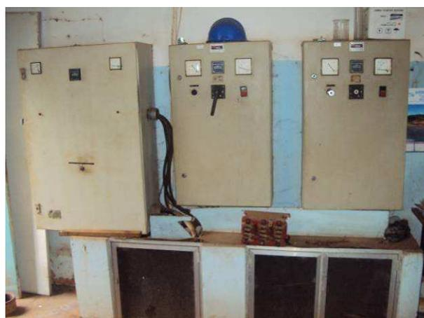
Figura 37. Painéis elétricos do poço e dos dois conjuntos motor-bombas existentes no reservatório do Antigo Matadouro.
