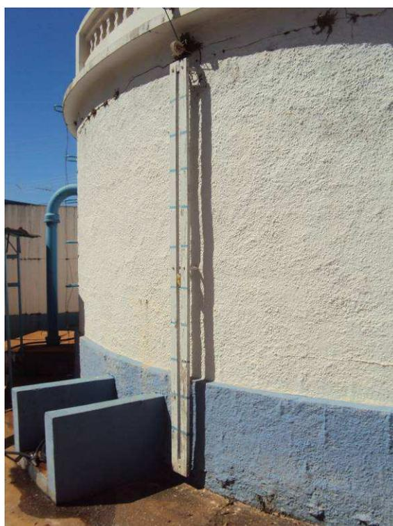
Figura 70. Vista da régua de nível existente no reservatório R2.
