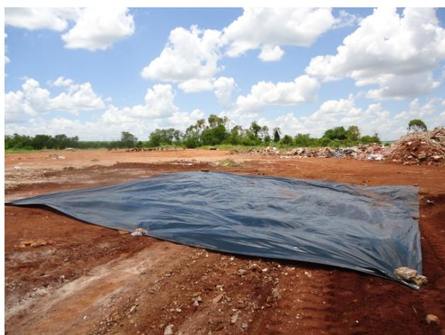
Figura 8.1.2. Instalação da lona plástica no aterro.
