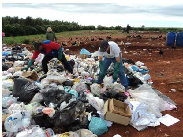
Figura 8.1.36. Sacos plásticos sendo rasgados para melhor homogeneização da massa de
