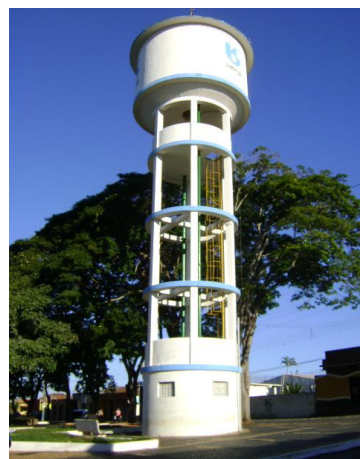
FOTO 4.6 - RESERVATÓRIO ELEVADO T1
