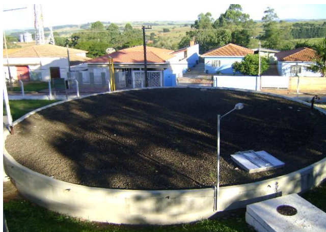
FOTO 4.5 - RESERVATÓRIO SEMI-ENTERRADO R1 - LOCALIZADO NA ETA ITAPORANGA
