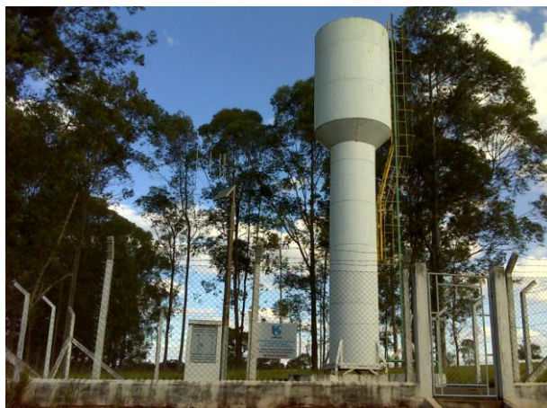
FOTO 4.17 – RESERVATÓRIO ELEVADO BAIRRO DA ONÇA
