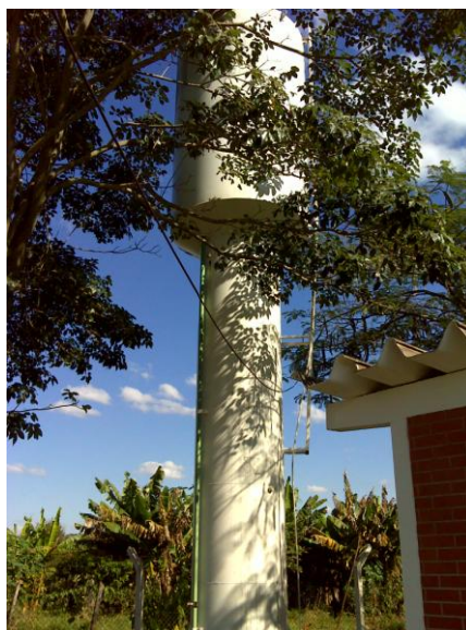
FOTO 4.12 – RESERVATÓRIO ELEVADO SÃO SEBASTIÃO
