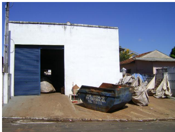
FOTO 4.27 – DEPÓSITO DO ATUAL GALPÃO DE TRIAGEM DO “PROJETO RECICLAR”
