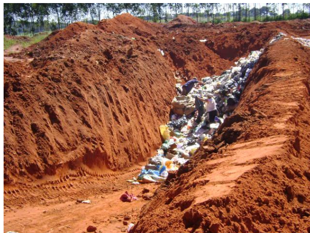
FOTO 4.25 – DETALHE DA VALA DO ATERRO SANITÁRIO DE ITAPORANGA
