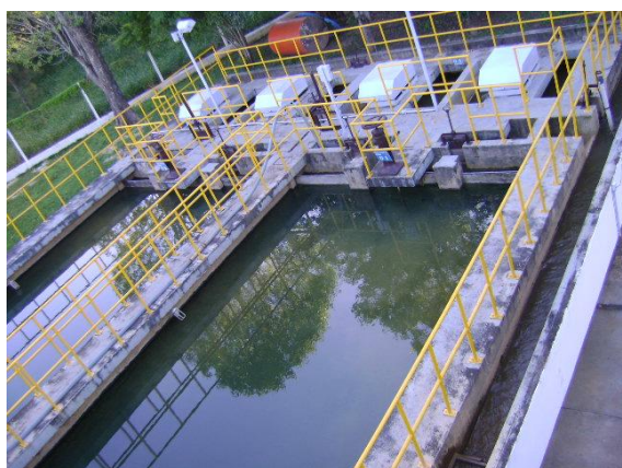
FOTO 4.3 - VISTA DA ETA ITAPORANGA
