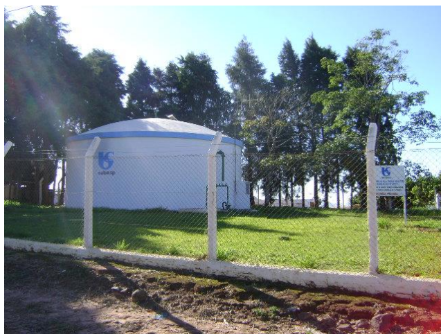
FOTO 4.7 - RESERVATÓRIO APOIADO R03
