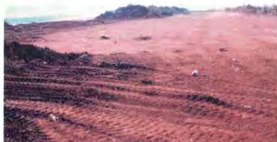
Figura 31. Vista da área do aterro.
