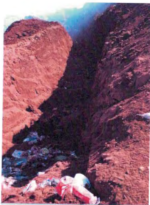
Figura 28. Vala sendo preenchida.
