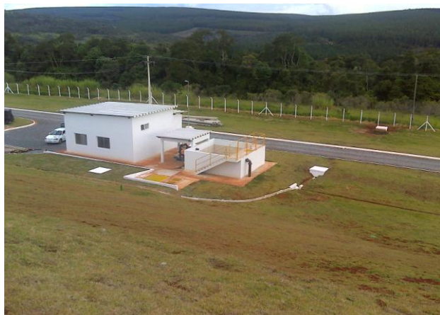
FOTO 4.34 – VISTA DO TANQUE DE LODO DA ETE DE ITARARÉ
