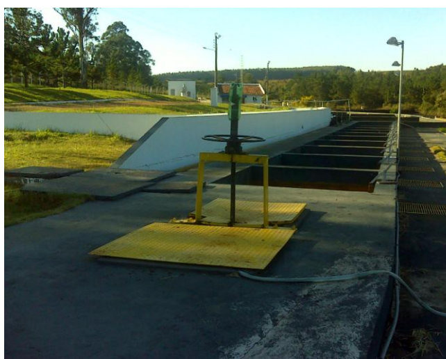
FOTO 4.6 – VISTA DOS FILTROS - ETA ITARARÉ
