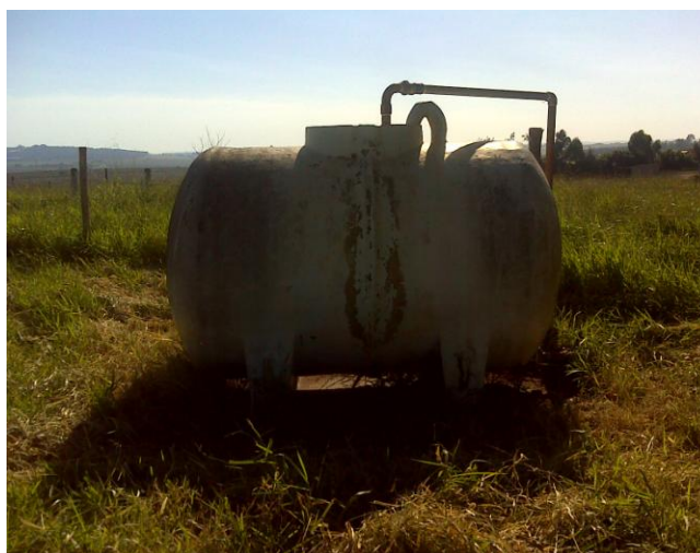
FOTO 4.17 – RESERVATÓRIO JARDIM REGINA
