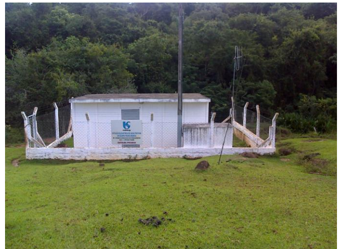
FOTO 4.26 – VISTA DA CAPTAÇÃO, TRATAMENTO E ESTAÇÃO ELEVATÓRIA
