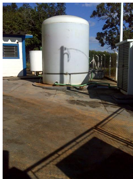
FOTO 4.31 – VISTA DO RESERVATÓRIO DE SANTA BÁRBARA
