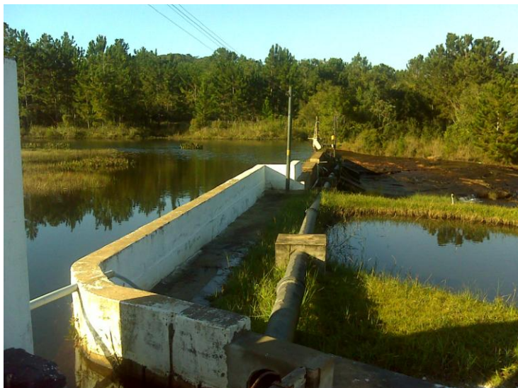
FOTO 4.1 – VISTA DA CAPTAÇÃO TRÊS BARRAS
