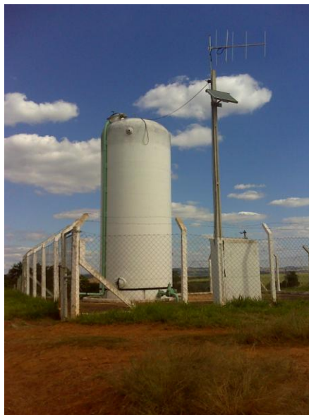
FOTO 4.27 - VISTA DO RESERVATÓRIO DE PEDRA BRANCA
