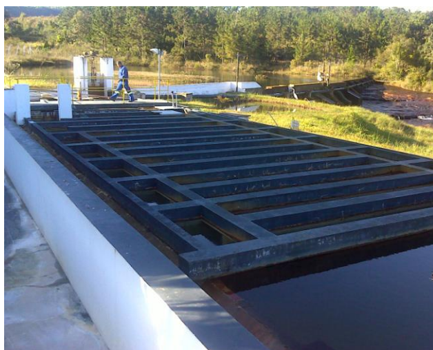
FOTO 4.4 – VISTA DO FLOCULADOR DA ETA DE ITARARÉ
