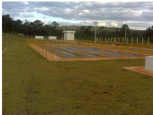
FOTO 4.35 – VISTA DO TANQUE DE CONTATO DA ETE DE ITARARÉ
