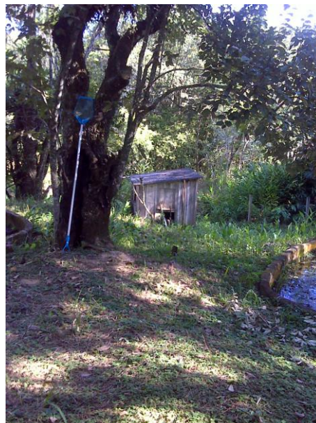
FOTO 4.29 – VISTA DA CASA DE BOMBAS DA EEAB
