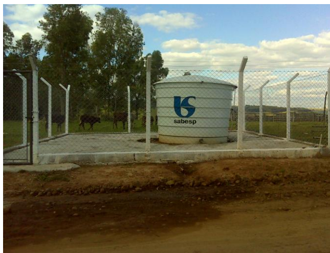
FOTO 4.30 – VISTA DO RESERVATÓRIO DE MATÃO
