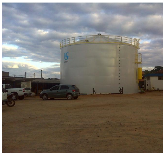
FOTO 4.15 – RESERVATÓRIO R3 NO CENTRO DE RESERVAÇÃO DE ITARARÉ
