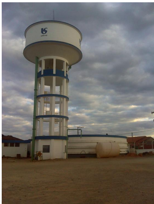
FOTO 4.13 – RESERVATÓRIO R1 E O RESERVATÓRIO. ELEVADO DO CENTRO DE RESERVAÇÃO DE ITARARÉ
