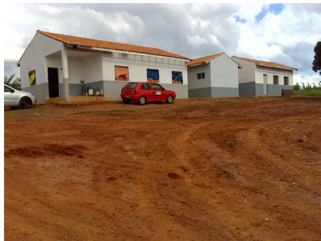
FOTO 4.42 – VISTA DAS INSTALAÇÕES DO ATERRO DE ITARARÉ
