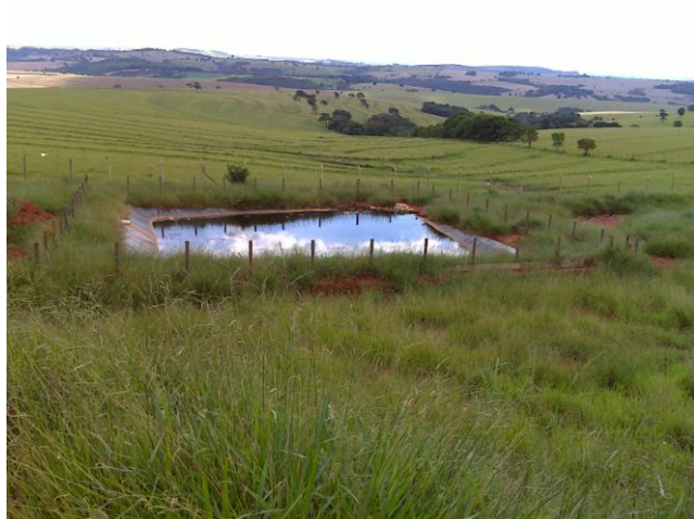
FOTO 4.41 – VISTA DA LAGOA DE CAPTAÇÃO DO CHORUME
