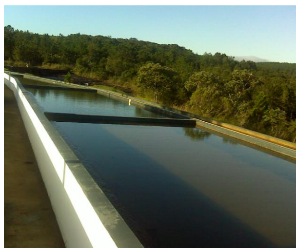
FOTO 4.7 - VISTA DOS DECANTADORES DA ETA DE ITARARÉ
