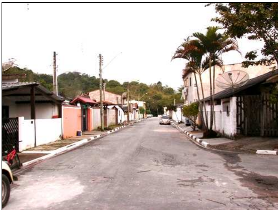
Foto 1 – Detalhe de Sarjeta e Sarjetão
