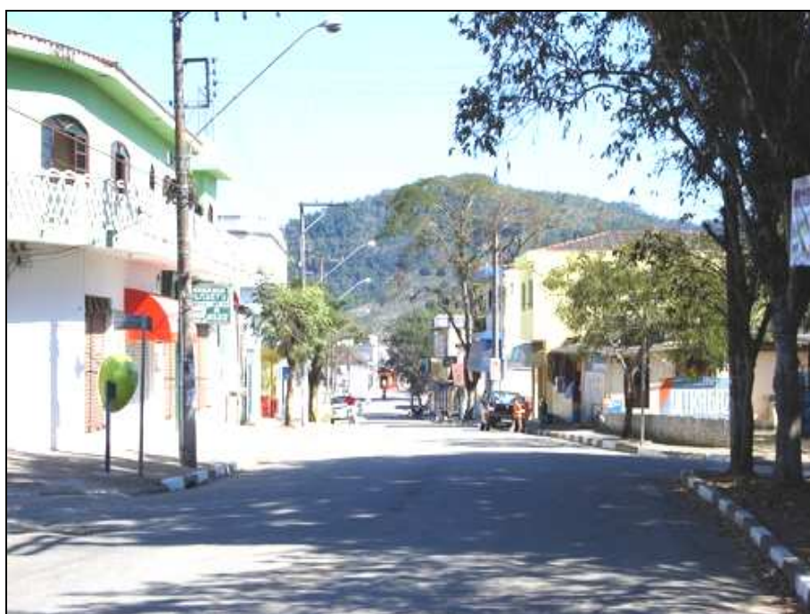
Foto 2 – Detalhe de Sarjeta, Sarjetão e Boca-de-Lobo
