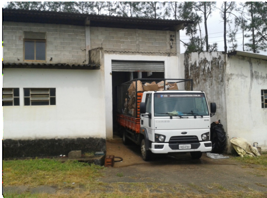
Figura 16: Área externa do espaço de triagem
