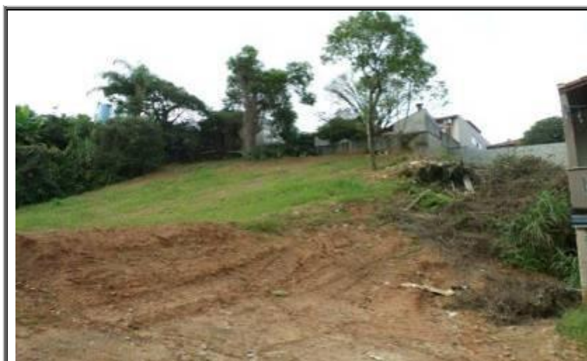
Figura 186 - Visto de um aterramento e reconstrução do talude para contenção de processos erosivos.
