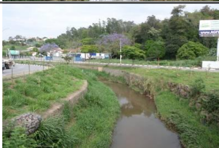
Figura 124 - Vista a Jusante da Travessia da Av. Nossa Senhora das Graças.
