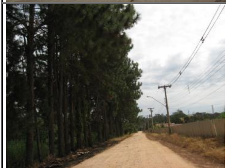
Figura 164 - Via sujeita a alagamentos
