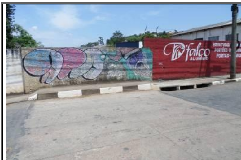
Figura 106 - Travessia na Rua José Monteiro Nunes.
