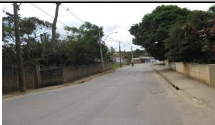
Figura 160 - Vista de um ponto baixo no Bairro da Ponte
