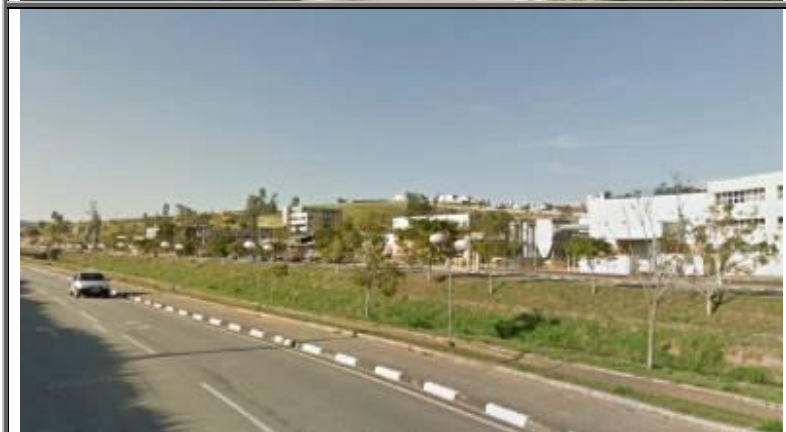
Figura 129 - Vista à jusante do Trecho T 12
