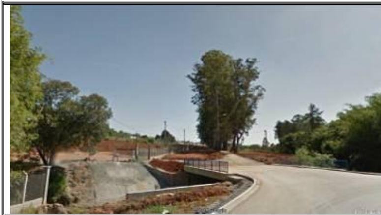
Figura 105 - T 01 – Condições da travessia no trecho T01.
