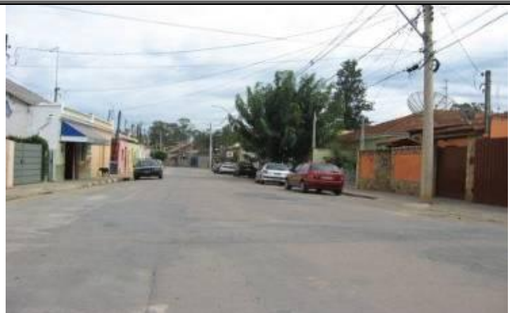
Figura 161 - Vista da rua no Bairro da Ponte. Baixa declividade longitudinal afeta o escoamento da água
