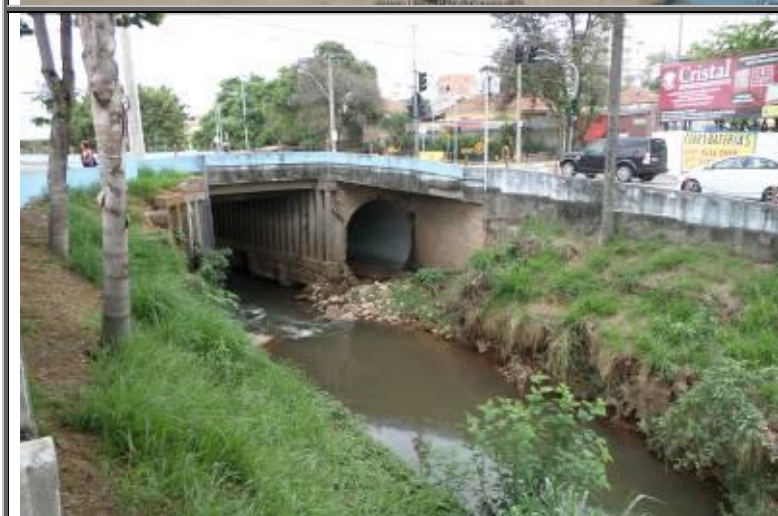
Figura 120 - Vista a Montante da Travessia T11 na Rua Joaquim B. de Campos.
