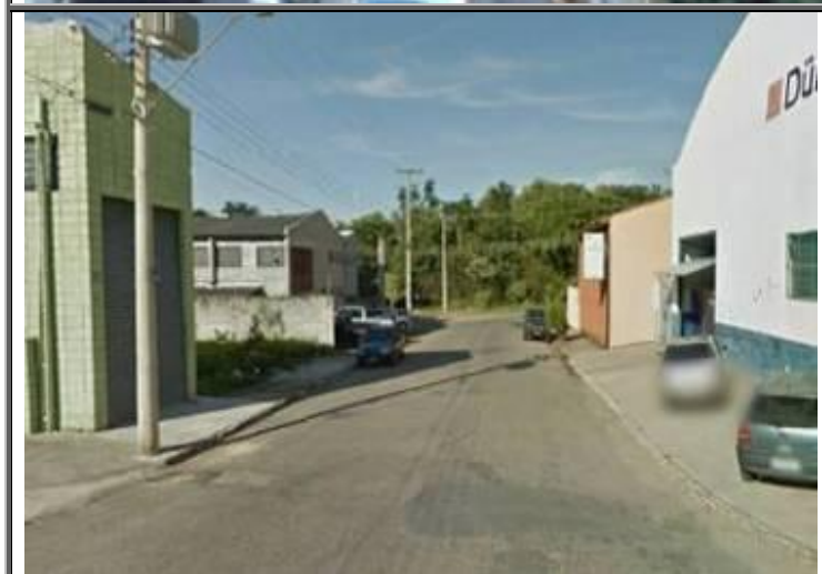
Figura 182 - Vista da Rua João Martinicci local de ocorrência de alagamentos segundo o Mapa de Riscos
