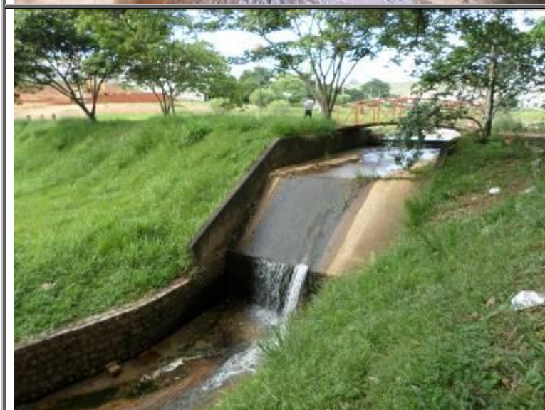
Figura 147 - Vista extravasor da lagoa do Córrego Perpétuo.
