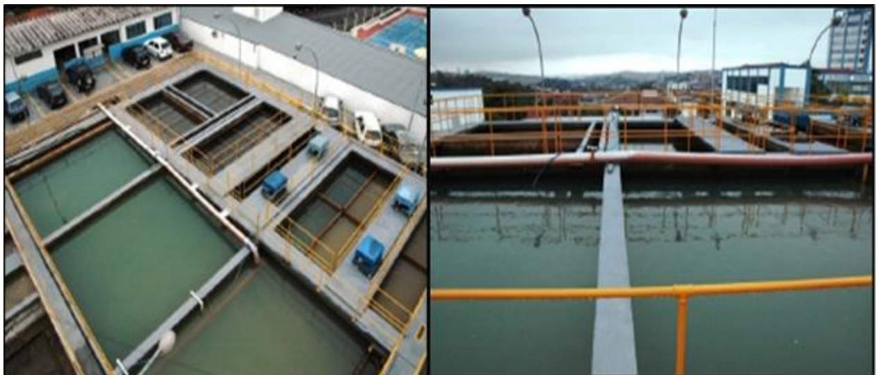
Figura 34 - Estação de Tratamento de Água – ETA
