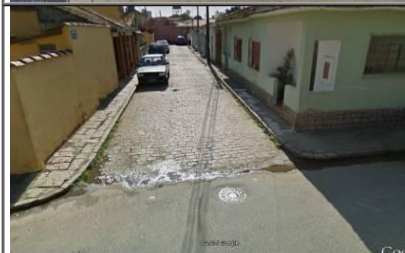
Figura 152 - Pavimento revestido com paralelepípedo
