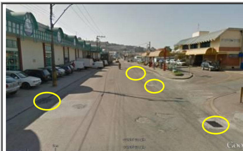
Figura 151 - Evidências de Bocas de Lobo com grelha em ponto baixo, localizadas na Rua Domingo Preti
