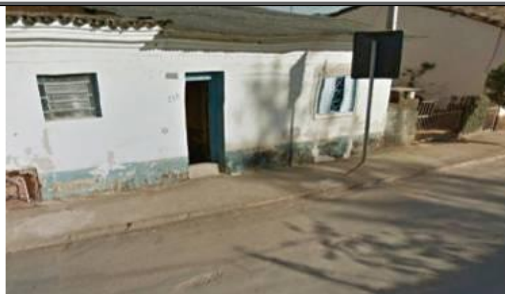
Figura 159 - Vista de uma residência com barreiras de contenção na porta para impedir entrada de água
