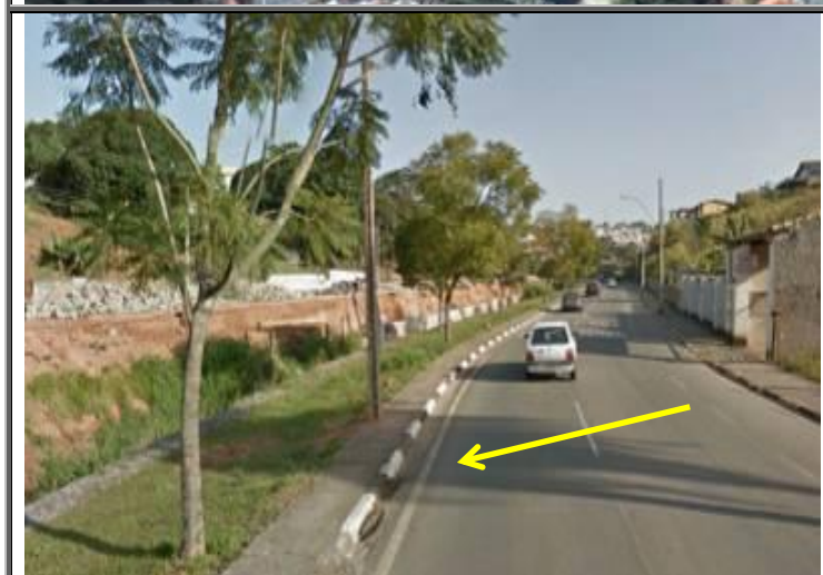
Figura 176 - Vista da Avenida Alberto Paladino
