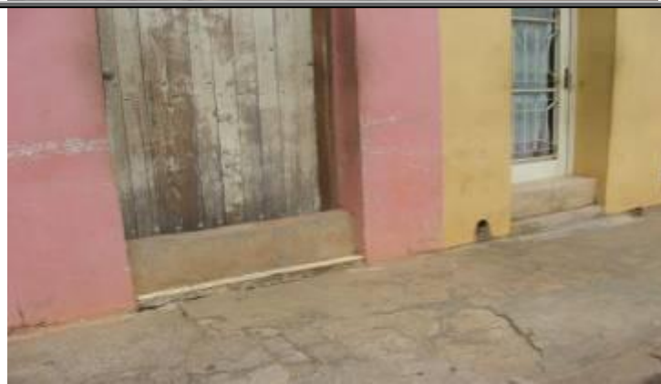
Figura 162 - Vista de uma residência com barreiras de contenção na porta para impedir entrada de água
