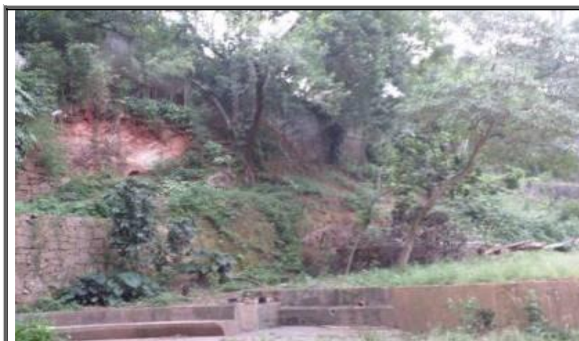
Figura 185 - Evidências de deslizamentos ocorridos devido à falta de conservação da encosta
