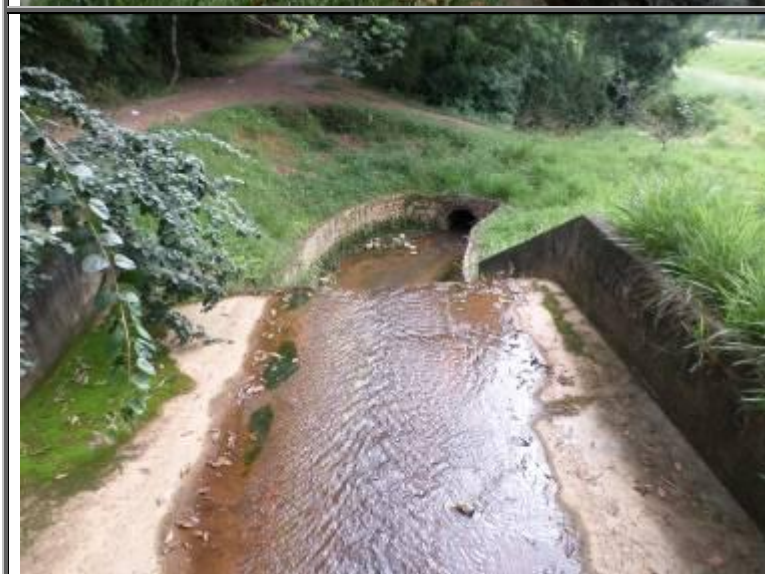
Figura 146 - Vista dos dispositivos hidráulicos da lagoa do Córrego Perpétuo.
