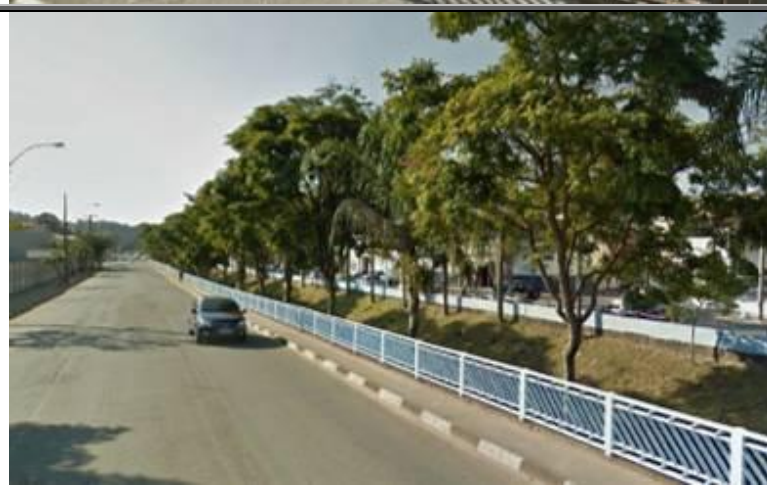
Figura 118 - Trecho à jusante da T 09.
