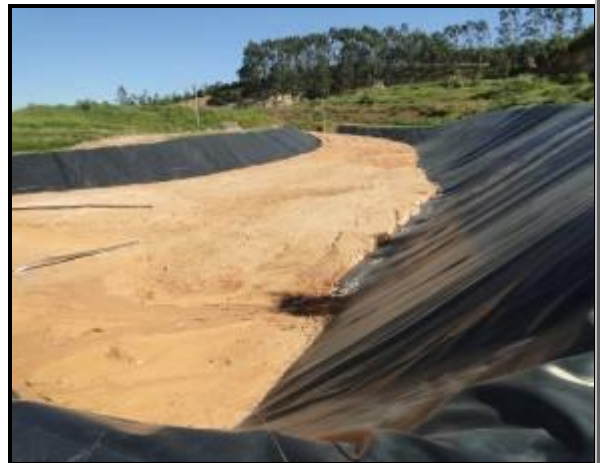
Figura 65 - Célula impermeabilizada com manta de PEAD
