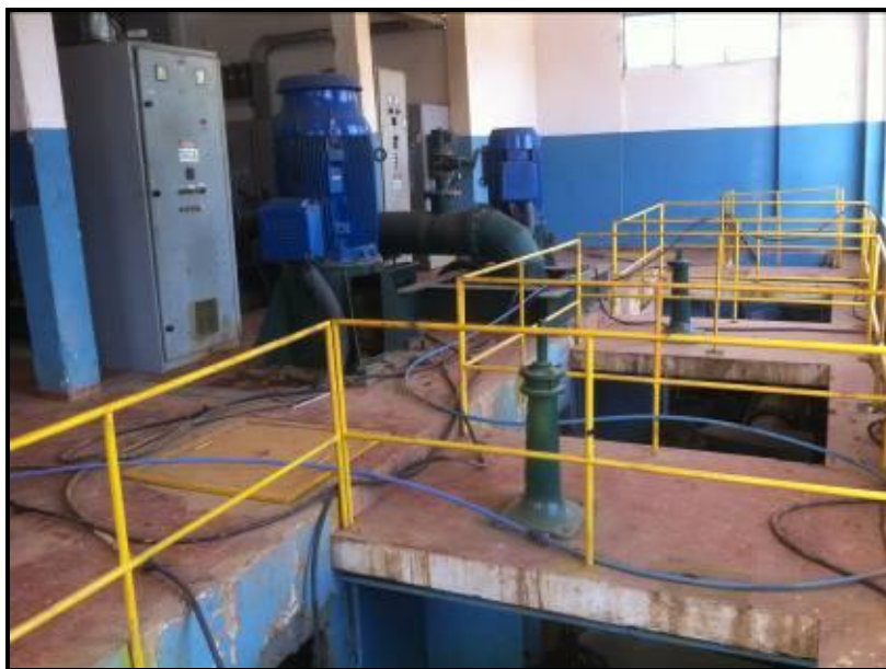
Figura 32 - Conjuntos motor-bomba
