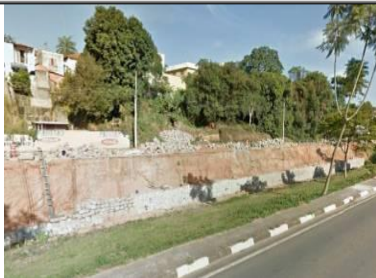
Figura 122 - Vista à jusante do Trecho T 11.
