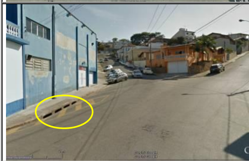
Figura 153 - Nota-se na imagem a existência de 4 bocas de lobo
