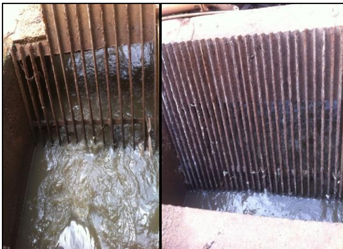
Figura 51 - Gradeamento primário e secundário
