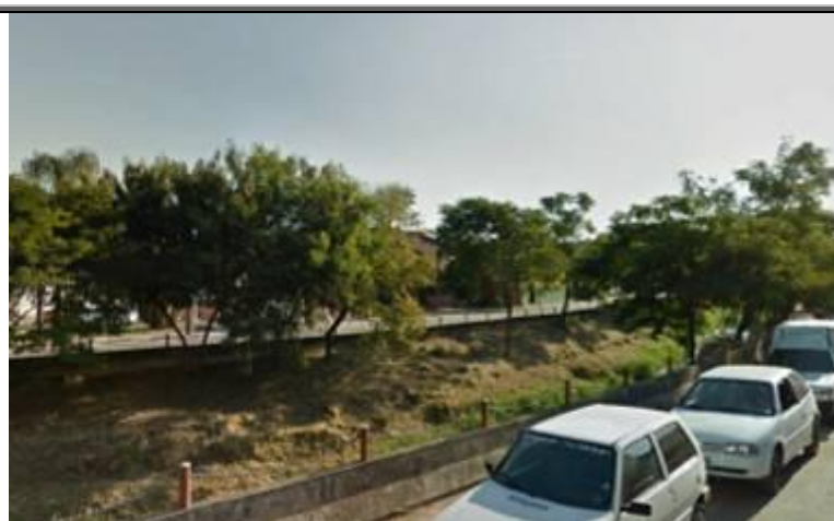
Figura 109 - Trecho à jusante do ponto T 04.
