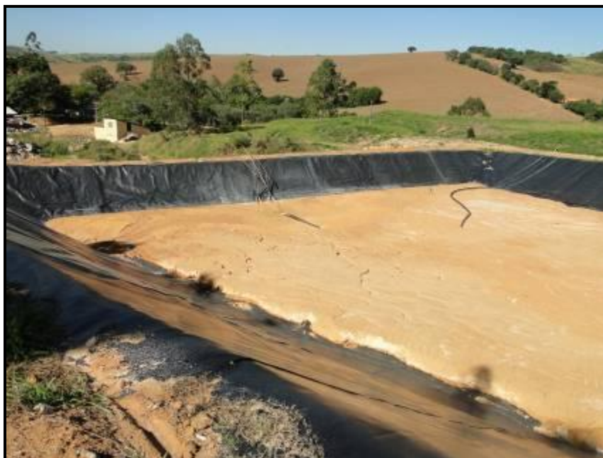
Figura 66 - Célula impermeabilizada com manta de PEAD
