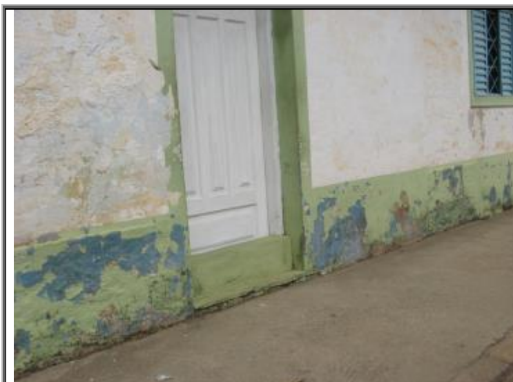
Figura 163 - Vista de uma residência com barreiras de contenção na porta para impedir entrada de água
