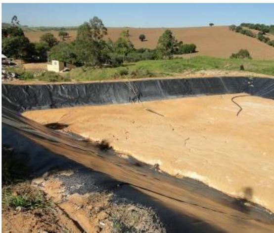
**Figura 03 - Tanque de acumulação do chorume drenado**
