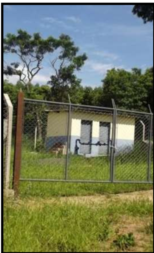
Figura 9 - Poço 08 - Rua 3, Estância Ubá
