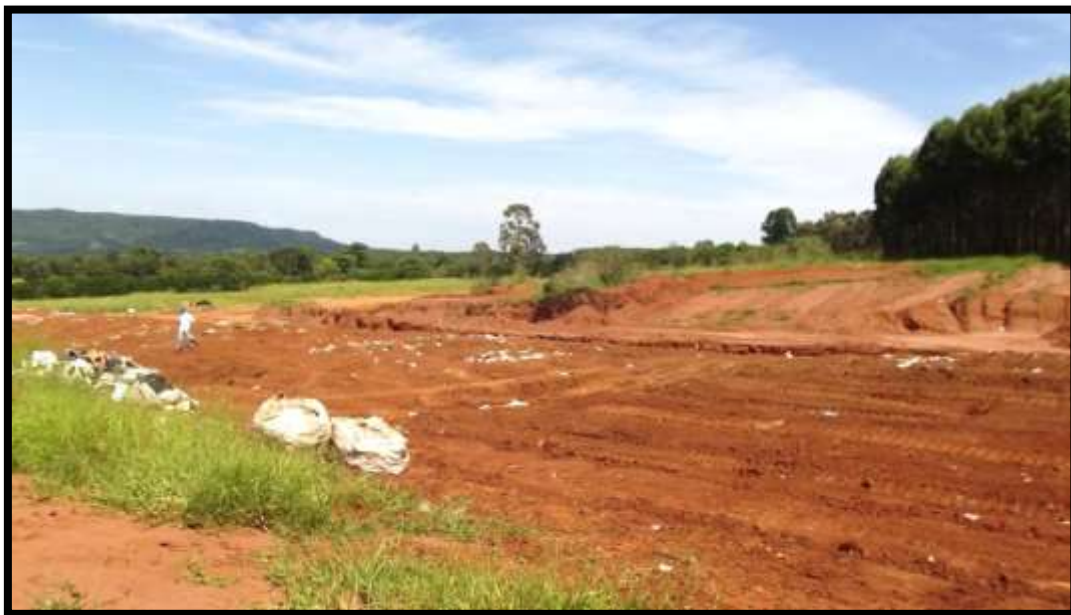
Figura 52 - Vista do Aterro em Valas – Itirapina-SP
