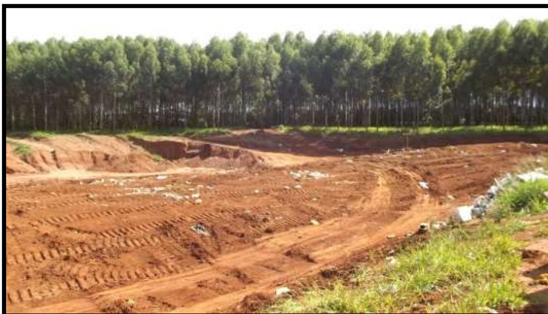
Figura 54 - Vista do Aterro em Valas - Itirapina-SP
