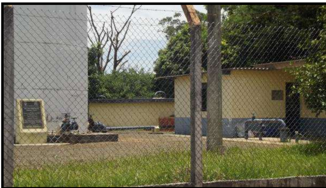
Figura 3 - Reservatório 1 e Poço 01– Rua 5- Vila Garbi
