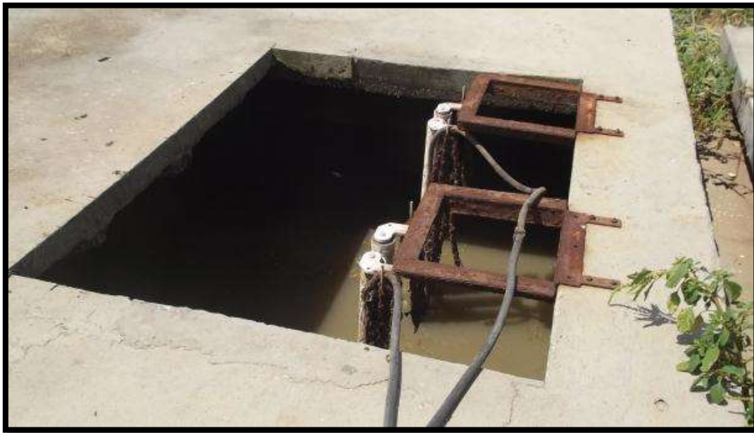
Figura 30 - Estação Elevatória da ETE
