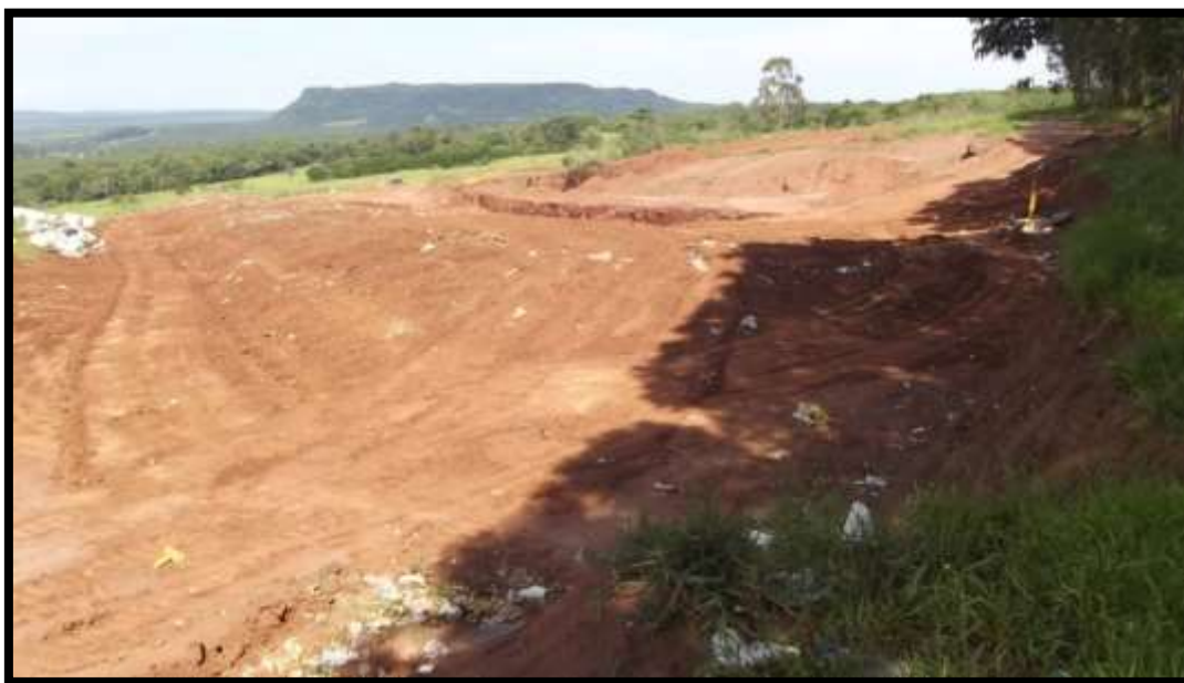
Figura 55 - Vista do Aterro em Valas - Itirapina-SP
