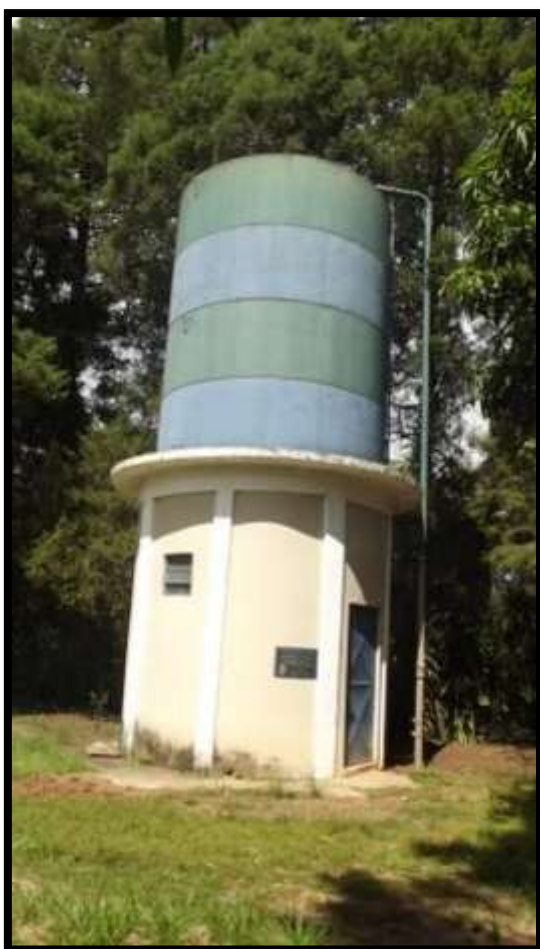
Figura 17 - Reservatório 7 Jardim Ubá - Itirapina-SP
