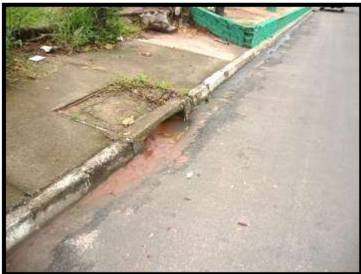
Figura 77 - Boca de lobo presente no local
