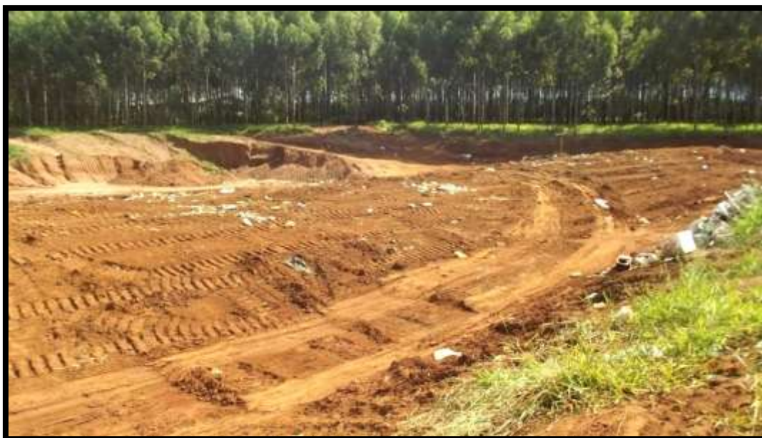
Figura 53 - Vista do Aterro em Valas - Itirapina-SP
