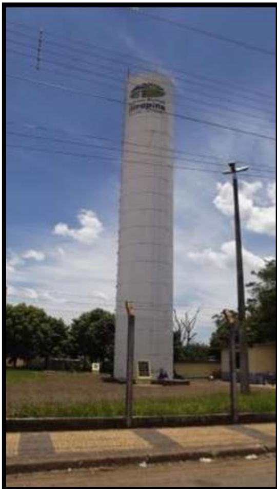
Figura 13 - Reservatório 04 - Rua 5 – Vila Garbi
