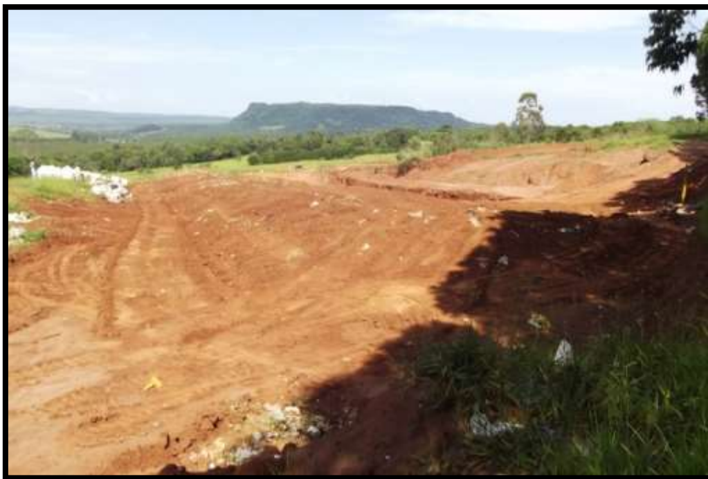
Figura 50 - Vista do Aterro em Valas – Itirapina-SP
