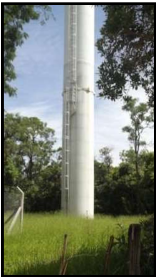
Figura 18 - Reservatório 09 - Rua 3, Estância Ubá
