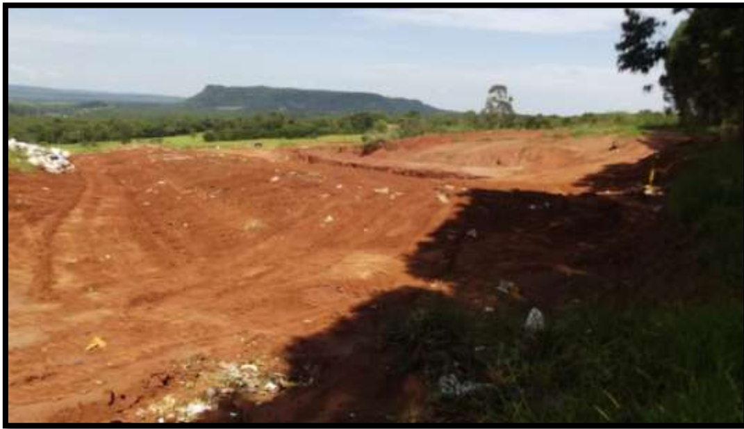
Figura 51 - Vista do Aterro em Valas – Itirapina-SP
