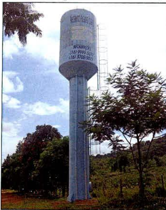
Foto 15 - Bairro Águas Claras - Reservatório elevado
