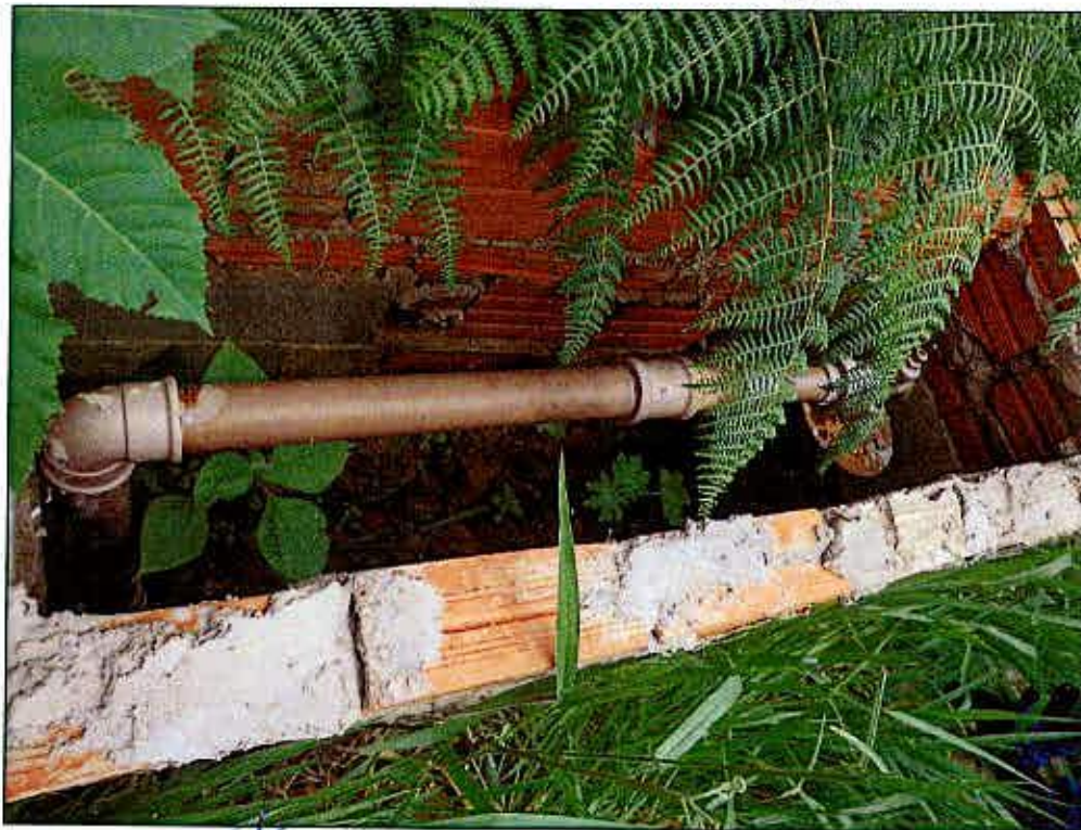
Foto 13 - Bairro Águas Claras - Cavalete do poço
