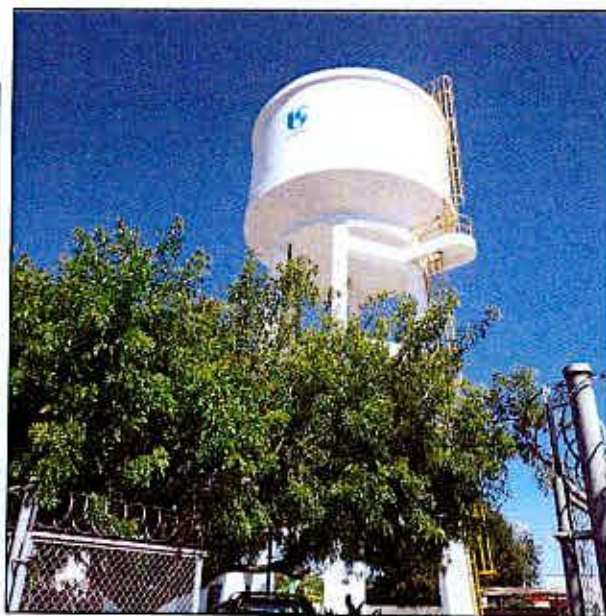
Foto 6 - Reservatório Elevado 01 (T01)
