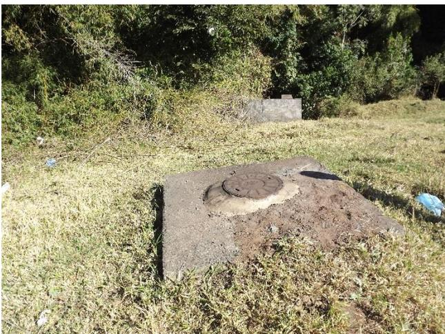
**Foto 3.12 – Vista geral do último poço de visita antes do lançamento de águas pluviais no corpo hídrico.**
