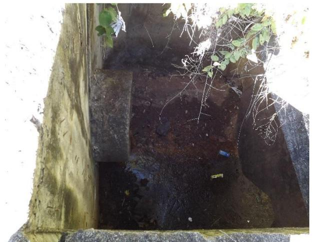
**Foto 3.13 – Vista geral do final da galeria de águas pluviais (à esq.) e do dissipador de energia (à dir).**
