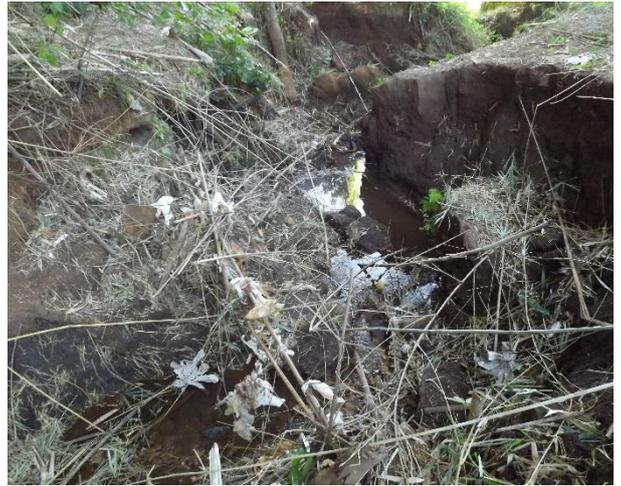
**Foto 3.15 – Detalhe de ponto com erosão na saída da galeria de águas pluviais.**
