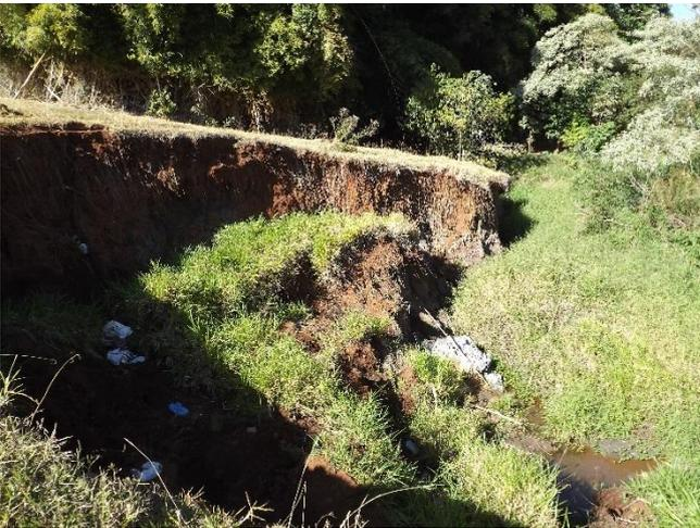
**Foto 3.16 – Detalhe de ponto com perda de solo (erosão), com instabilidade no talude e corpo hídrico nas proximidades (à dir.).**
