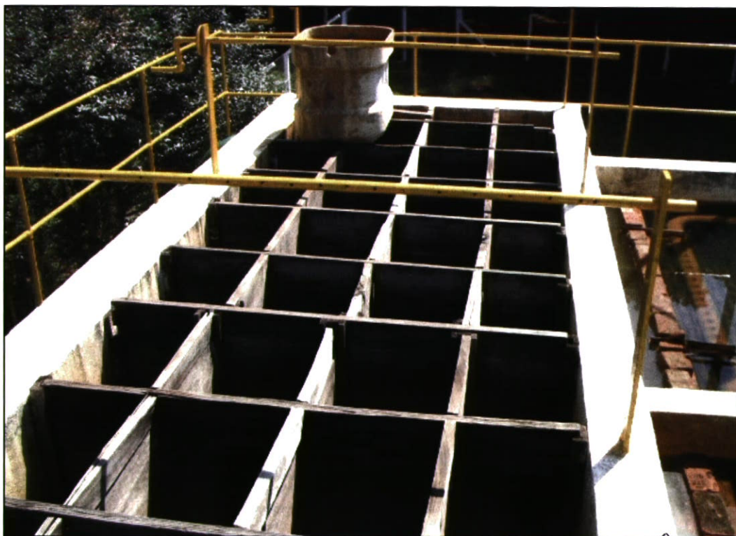
Foto 6 - Vista das chicanas do floculador de câmaras da ETA de Itobi, executadas em madeira
