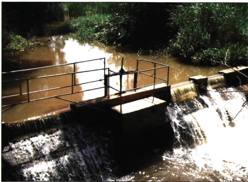
Foto 2 - Vista da barragem de elevação de nível no Rio Doce para captação de água bruta
