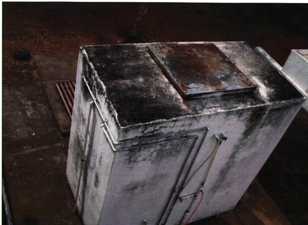
Foto 9 - Vista do tanque de contato onde são realizadas a correção de pH, a fluoretação e desinfecção com adição de cloro (pós-cloração)
