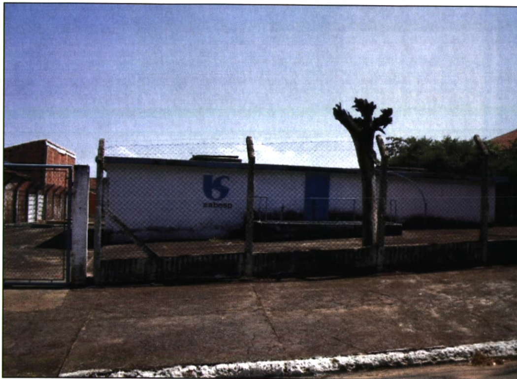
Foto 13 - Vista do reservatório apoiado RA-02 com capacidade de 50 m 3 , executado em fibra de vidro. Recebe água do reservatório RS-01 através da EEAT Booster - B-01
