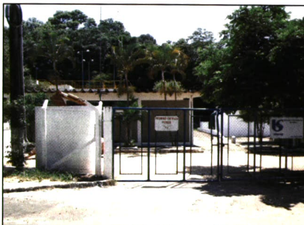
Foto 4 - Vista parcial da Estação de Tratamento de Água de Itobi. A ETA é totalmente automatizada
