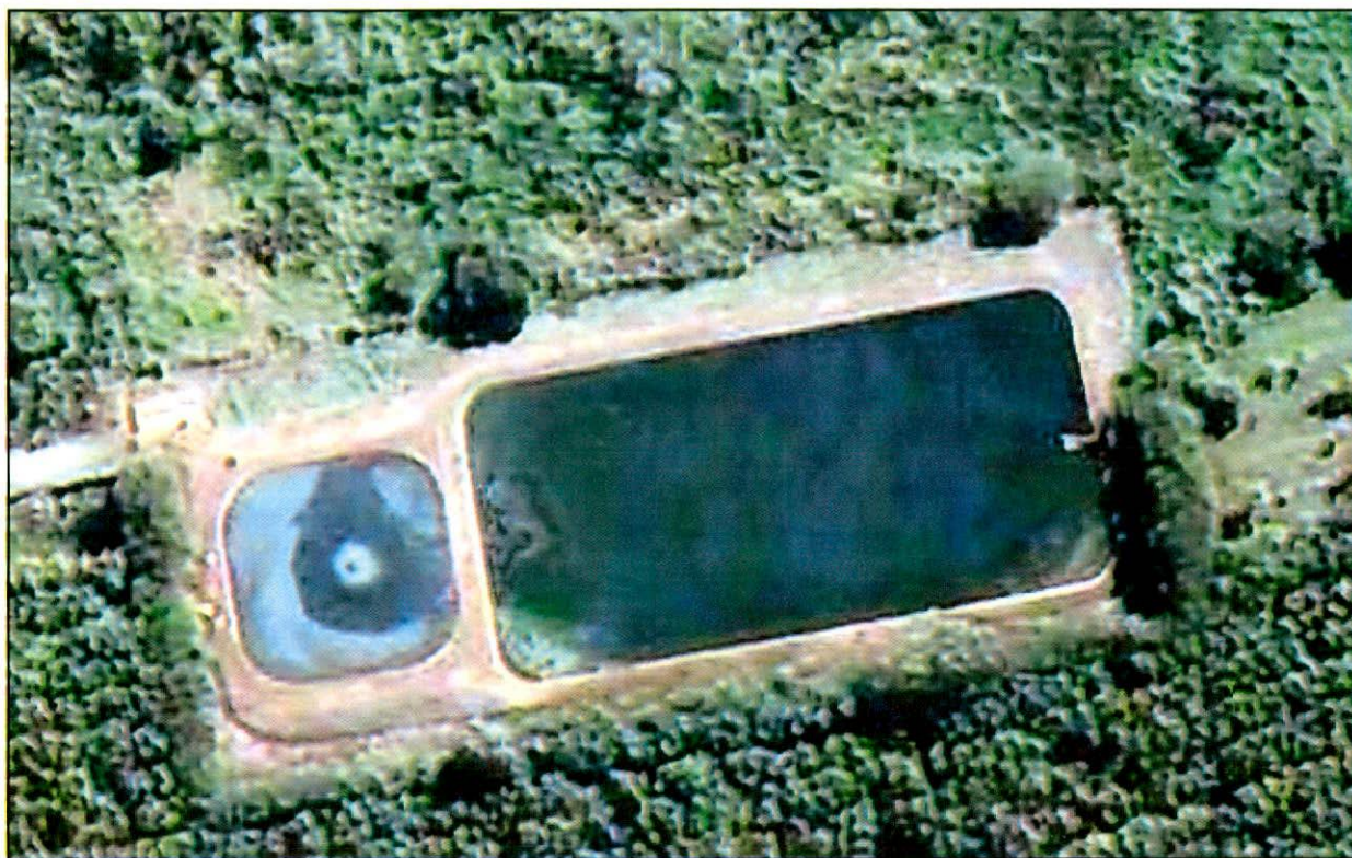
Foto 13 - Vista aérea da estação de tratamento de esgoto ETE01
