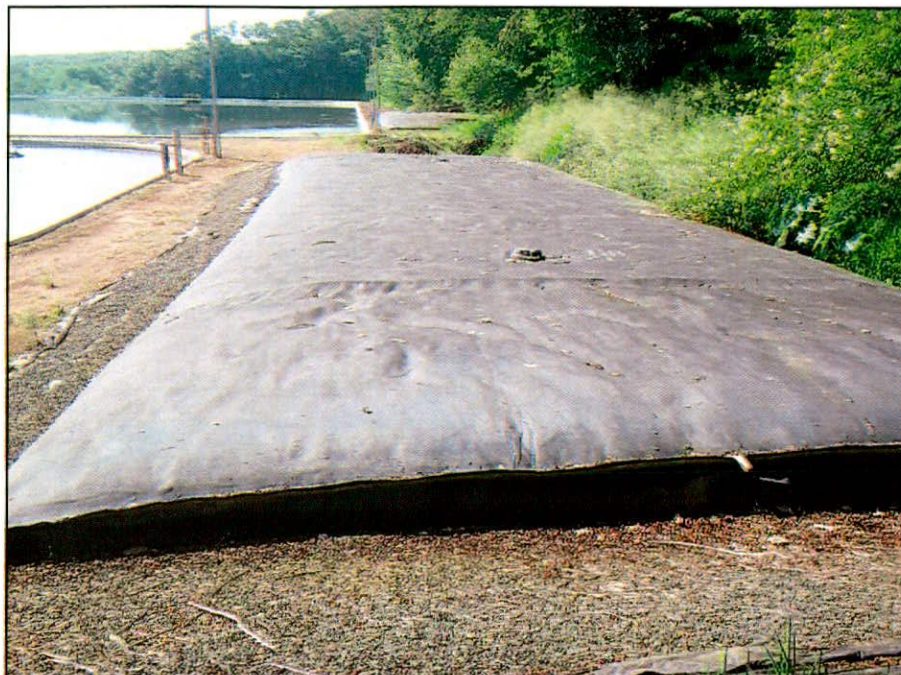
Foto 16 - Limpeza da lagoa - “Bag” para armazenamento do lodo
