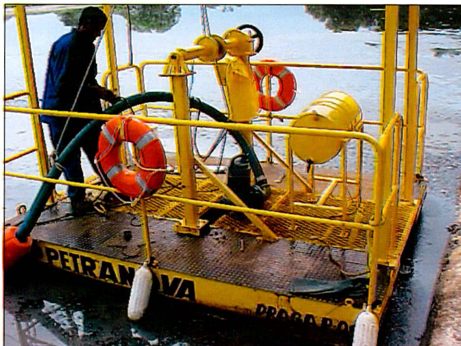
Foto 15 - Limpeza da lagoa - Bombeamento do lodo e areia
