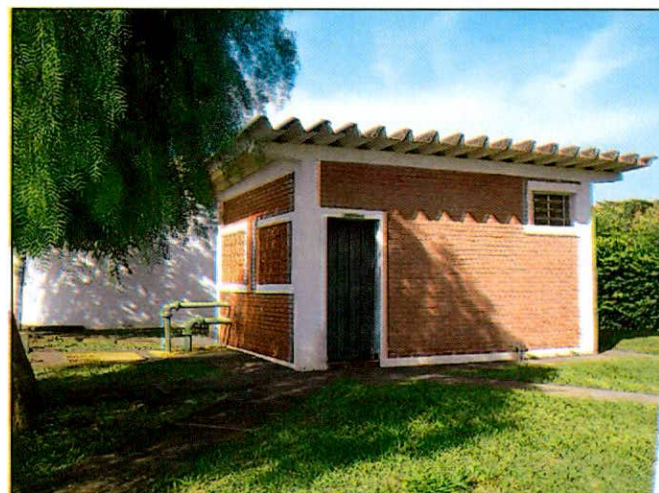
Foto 9 - Vista externa - Estação elevatória de água tratada (EEAT01 e B01)
