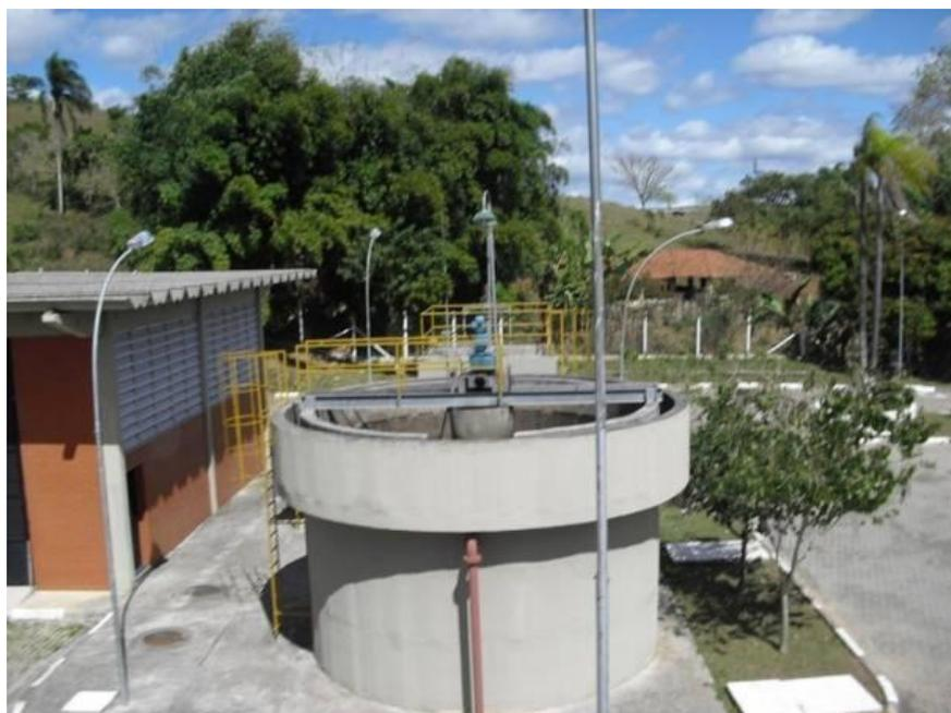
**Foto 30 – Tanque de adensamento de lodo da ETE Bandeira Branca.**
