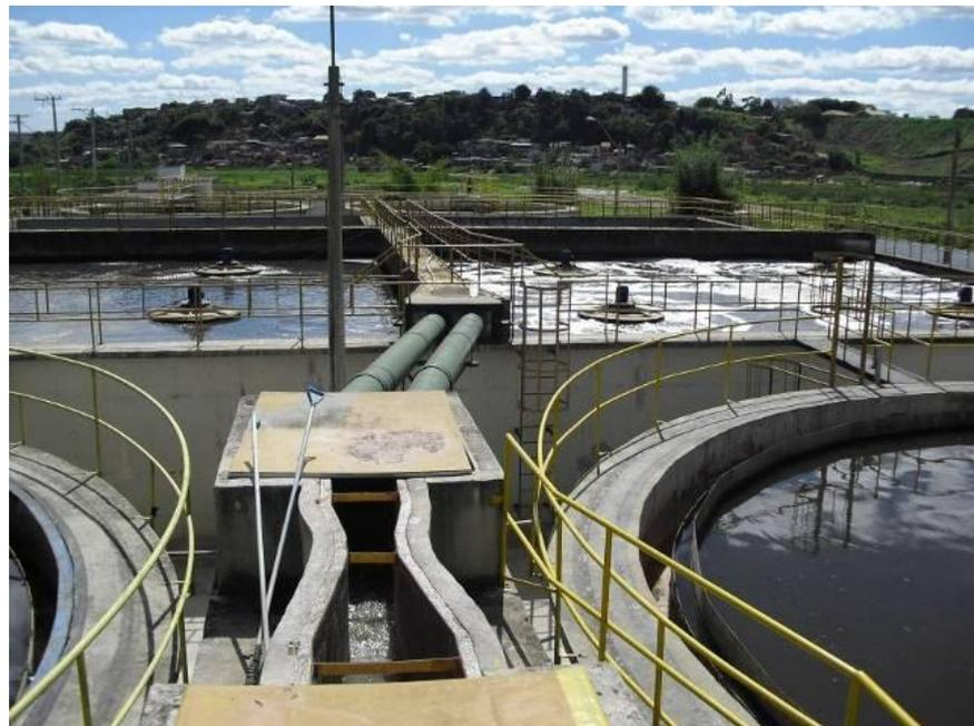
**Foto 36 – Decantador e tanque de aerção da ETE Vila Branca.**
