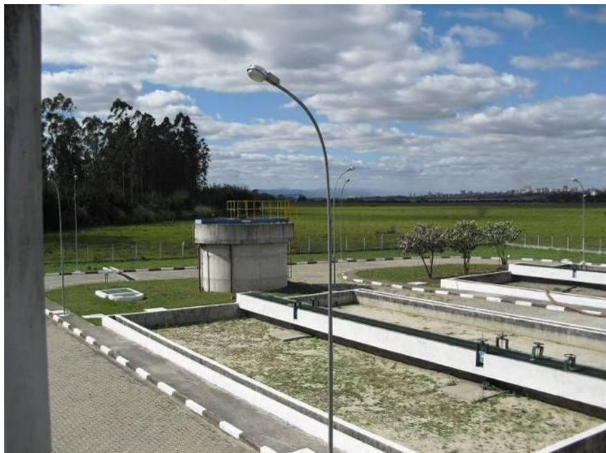
Foto 34 – Tanque de adensamento de lodo e leito de secagem da ETE Meia Lua.
