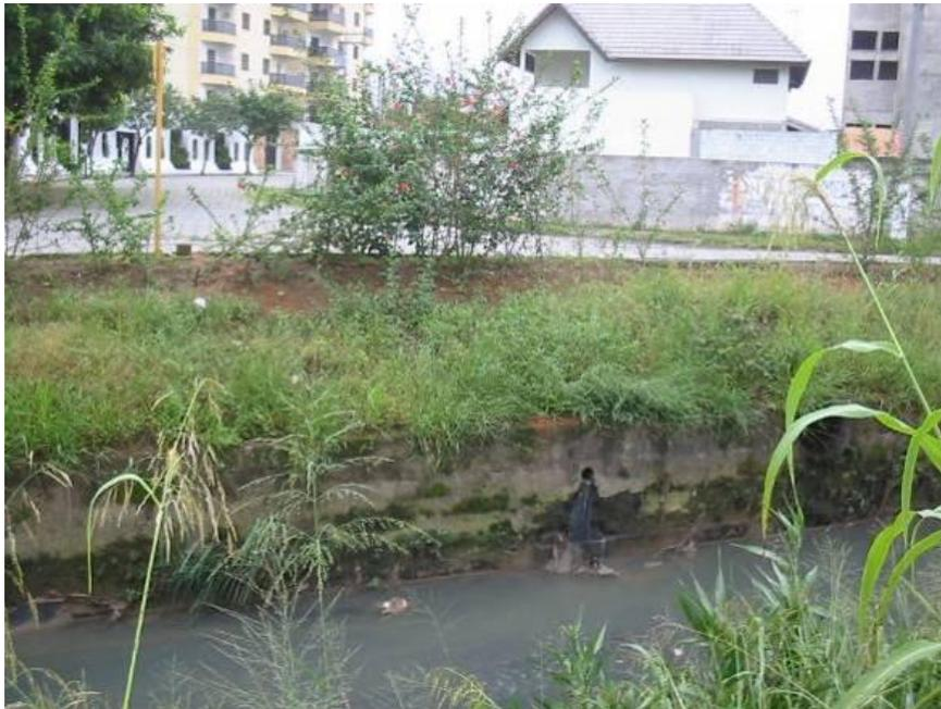
**Foto 10 – Lançamento na margem direita, da rede coletora – Rua Enéas de Mesquita.
