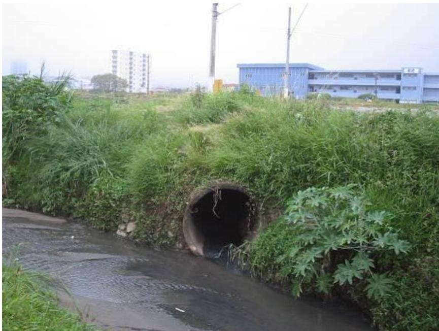
**Foto 11 – Lançamento da rede coletora da Avenida Prefeito José C. Arouca no Rio Turi, margem esquerda (Fonte: Cobrape-Gerentec)**
