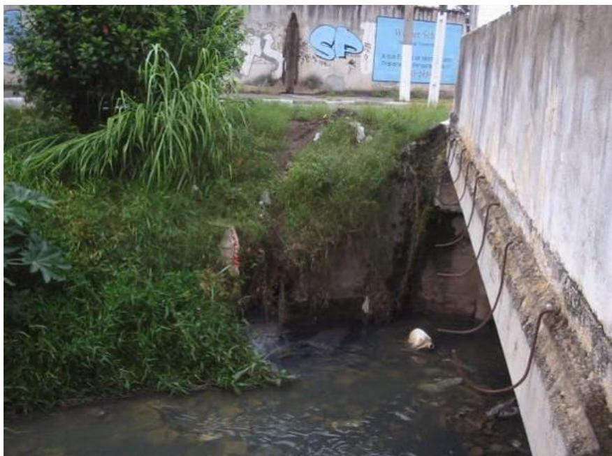
Foto 09 – Lançamento, na margem esquerda, da rede coletora – Avenida 9 de Julho.
