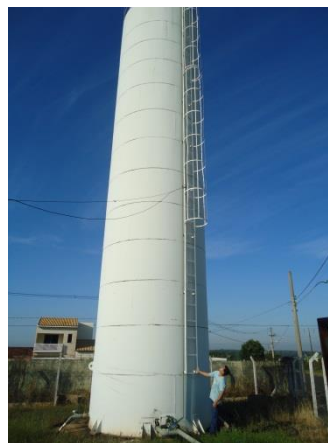
Foto 3.13 – Reservatório apoiado metálico
