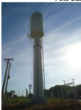
Foto 3.14 – Reservatório elevado metálico
