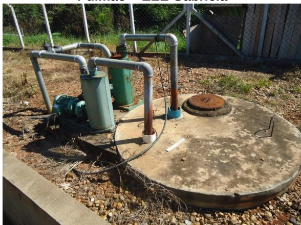
Foto 3.35 – Vista Geral –Poço de Sucção e Poço Pulmão – EEE Gabriela
