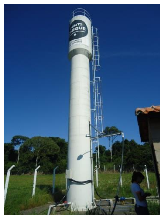
Foto 3.20 – Reservatório apoiado metálico
