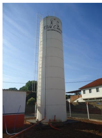
Foto 3.16 – Reservatório apoiado metálico
