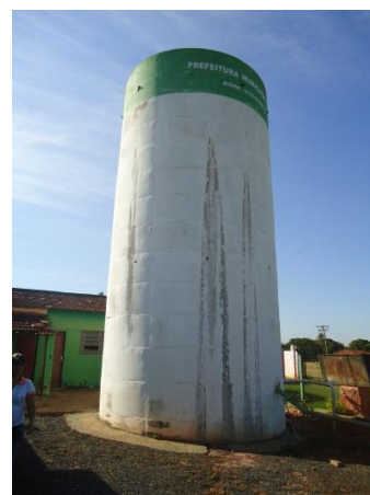
Foto 3.5 – Reservatório elevado concreto
