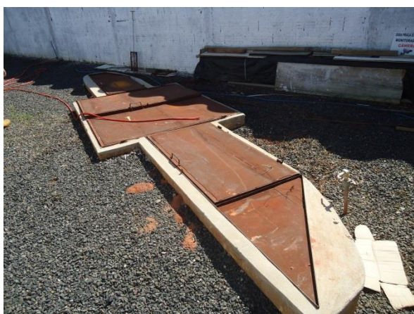
Foto 3.27 – Vista Geral – Tratamento Preliminar – EEE Praça
