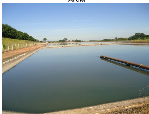
Foto 3.40 – Vista geral – Lagoas Anaeróbia, Facultativa e de Polimentos
