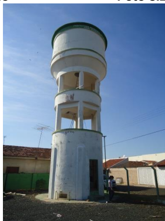
Foto 3.3 – Reservatório elevado de concreto
