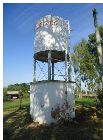
Foto 3.11 – Reservatório elevado de concreto
