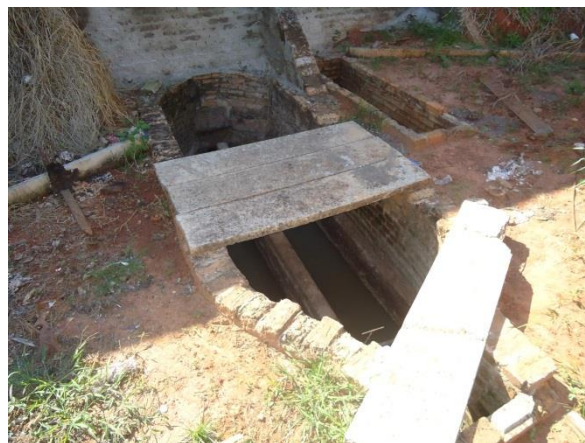
Foto 3.32 – Tratamento preliminar – Zé Barbosa
