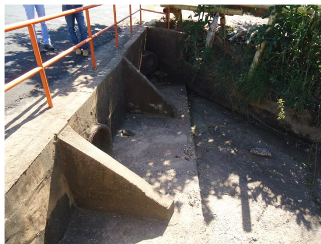
Foto 3.55 – Ilustração da obra instalada do canal
