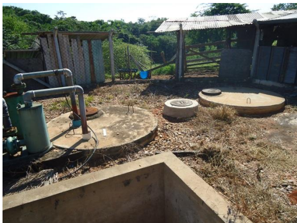
Foto 3.33 – Vista Geral –Poço de Sucção e Poço Pulmão – EEE Gabriela
