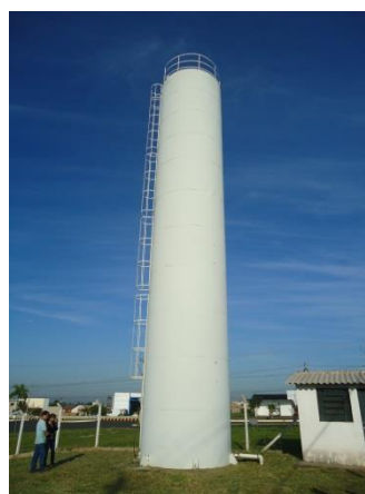
Foto 3.18 – Reservatório apoiado metálico
