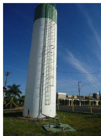
Foto 3.9 – Reservatório apoiado metálico
