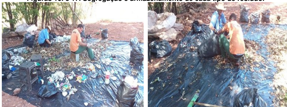
Figuras 16. e 17. Segregação e armazenamento de cada tipo de resíduo.
