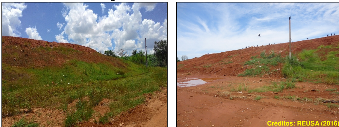
Figura 7. Aterro Sanitário de Jales
