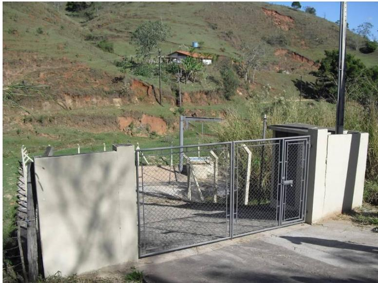
**Foto 05 - EEE Final - recalca o esgoto gerado na sede do município para a ETE.**
