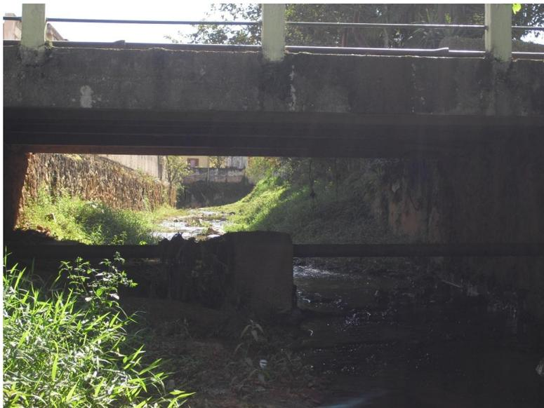
**Foto 12 - Ponte da Rua Coronel Batista sobre o Rio Jambéiro – detalhe para o bloco de ancoragem da tubulação de esgoto sob a ponte.**
