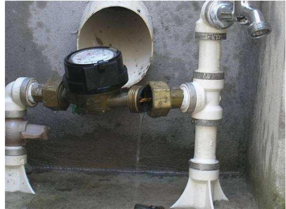
Figura 29. Hidrômetro com arame.
