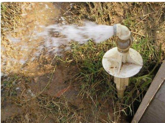
Figura 26. Cavalete sem hidrômetro.
