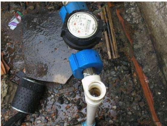
Figura 30. Hidrômetro com arame.
