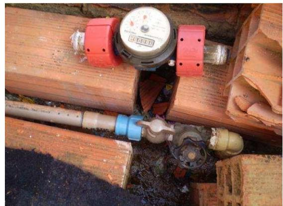
Figura 27. Cavalete sem Hidrômetro.
