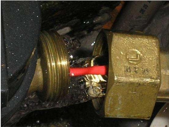
Figura 28. Hidrômetro com arame.
