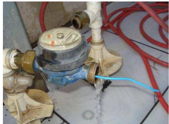
Figura 31. Hidrômetro com arame.
