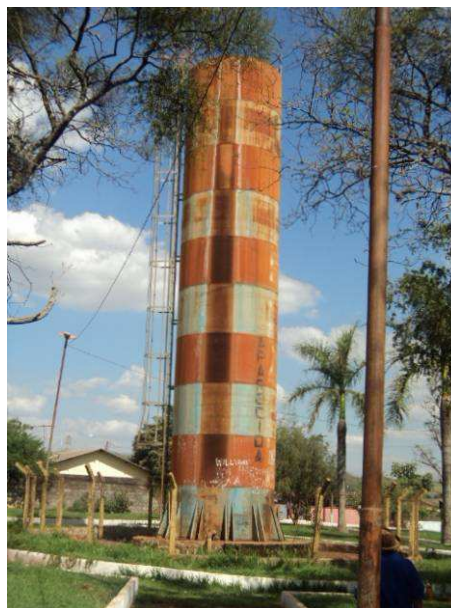
Figura 36. Vista do reservatório R3.
