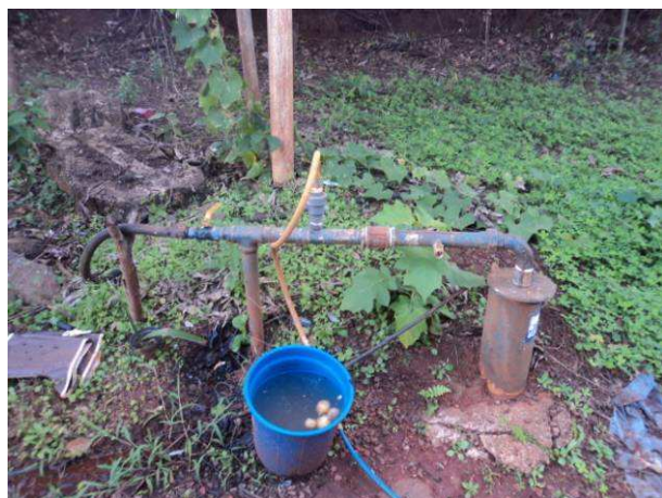
Figura 72. Vista do Poço P15.
