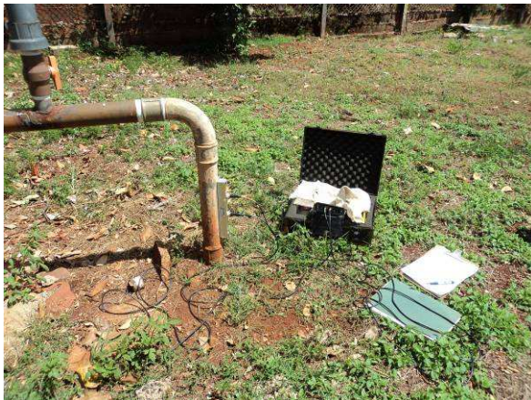
Figura 21. Medição no Poço Jurucê (Distrito) - P14.
