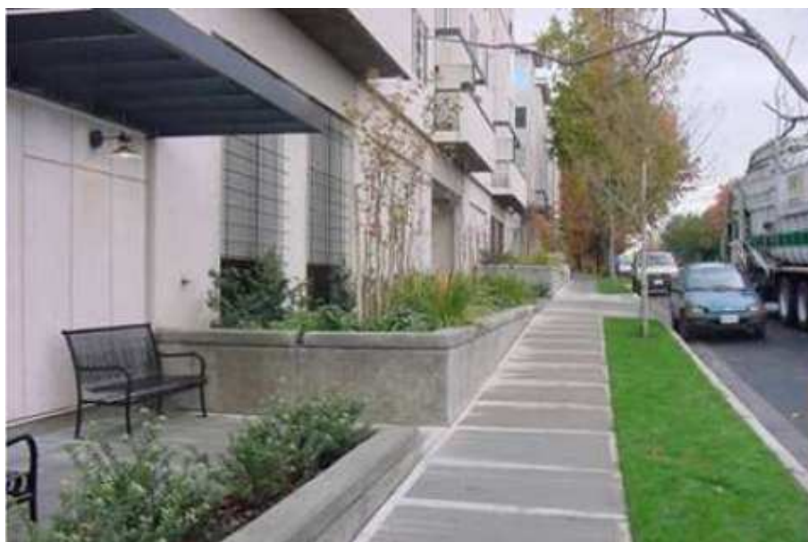
Figura 96. Plano de infiltração constituído por uma faixa de grama na Calçada.
