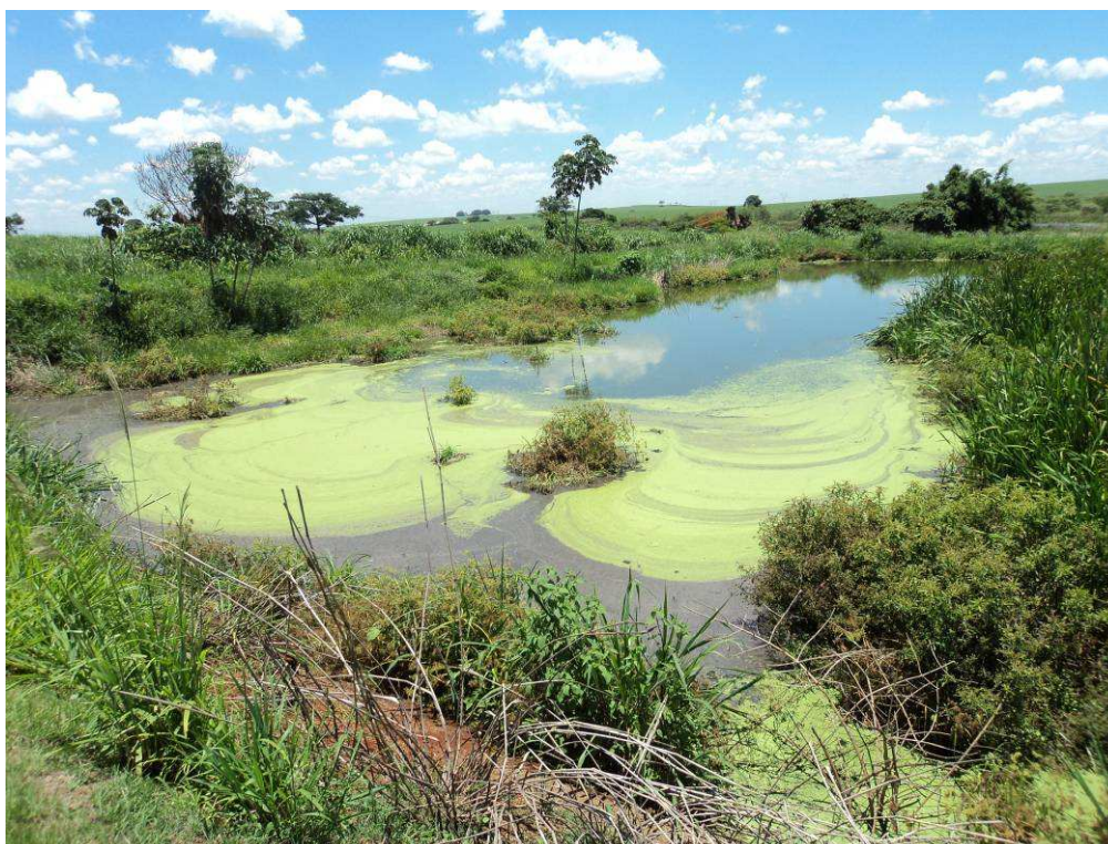
Figura 108. Vista da lagoa de tratamento existente no distrito industrial.
