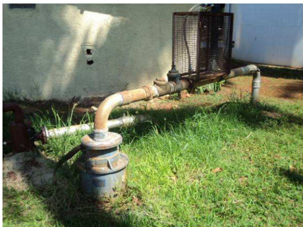
Figura 39. Vista do Poço P6.
