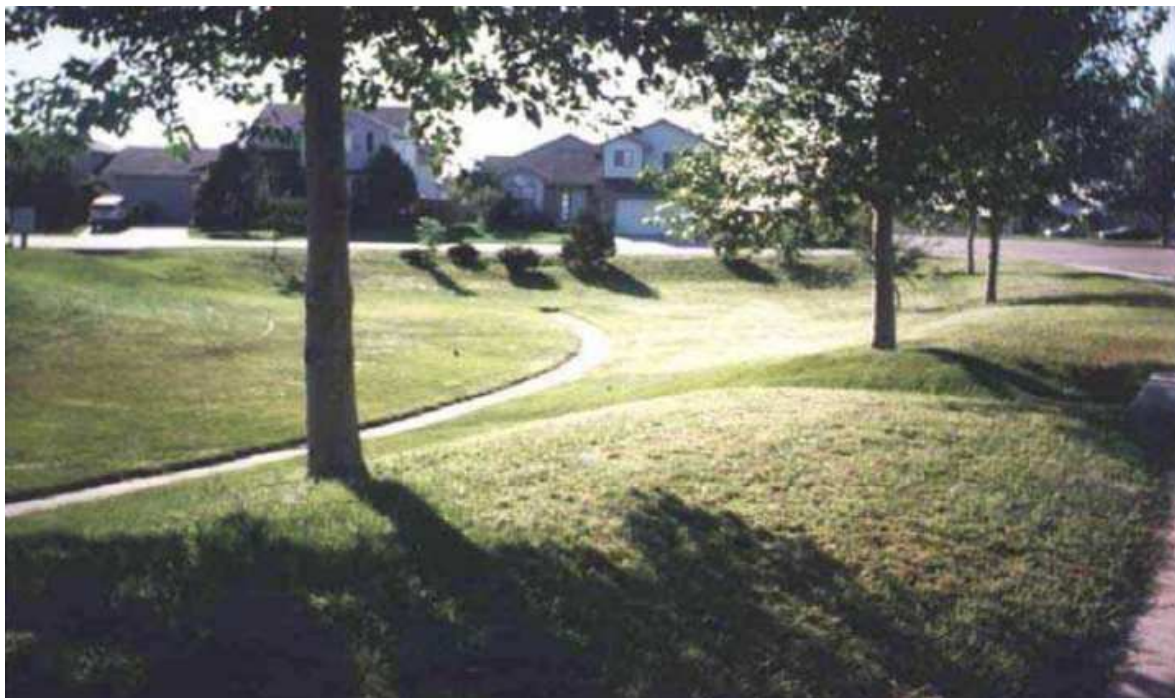
Figura 92a. Reservatório de detenção gramado numa pequena área, durante a seca.
