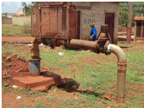
Figura 78. Vista do Poço P15.
