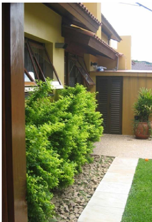
Figura 94. Trincheira de infiltração num lote residencial.
