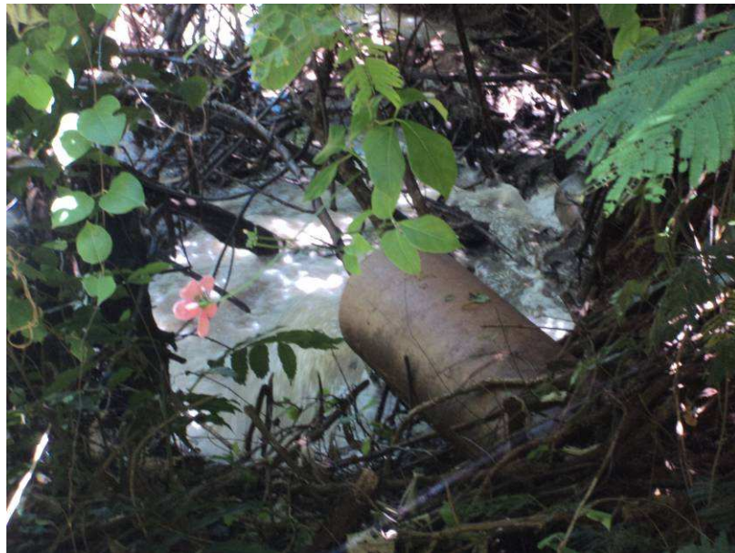
Figura 116. Lançamento de esgoto bruto no Córrego do Matadouro.
