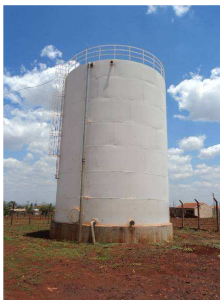
Figura 79. Vista do reservatório R11.
