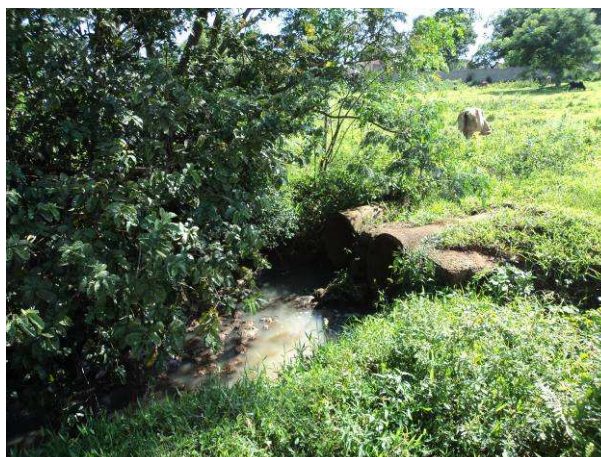
Figura 119. Lançamento de água pluvial próximo ao bairro Vila Boldrini.
