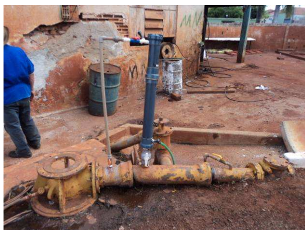
Figura 29. Vista do Poço P2.
