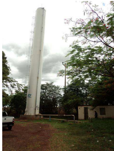
Figura 32. Vista do reservatório R12.
