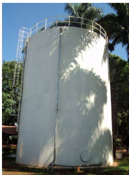
Figura 40. Vista do reservatório R10.
