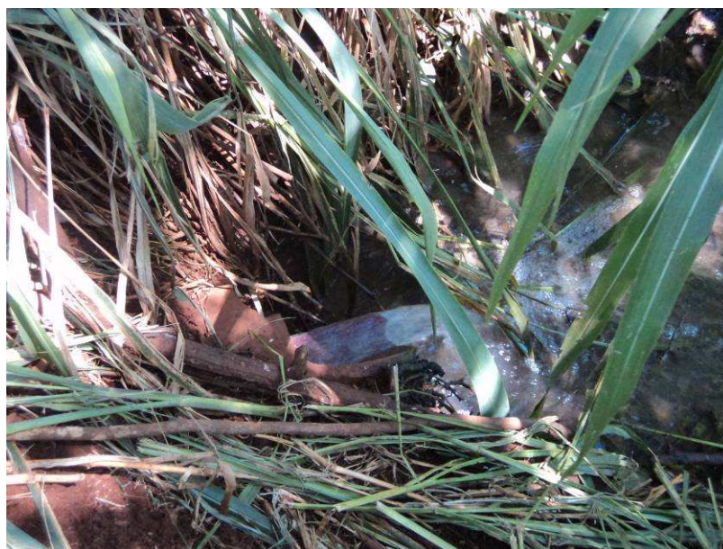
Figura 117. Lançamento de esgoto bruto no Córrego Água Branca do distrito de Jurucê.
