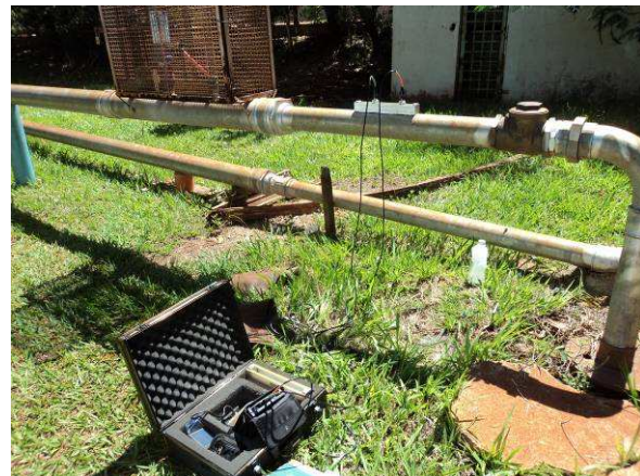
Figura 12. Medição no Poço Toscano (P3).
