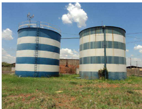
Figura 64. Vista do reservatório R7.
