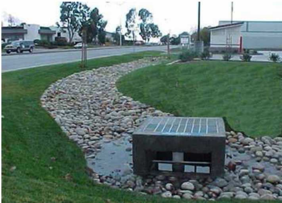
Figura 90. Trincheira de infiltração ao longo da rua.
