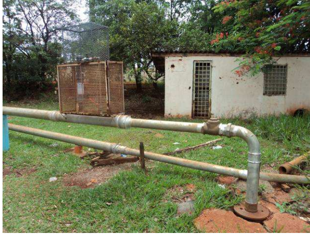
Figura 31. Vista do Poço P3.
