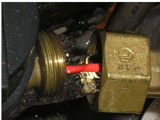
Figura 35. Hidrômetro com arame.
