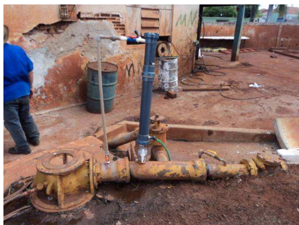
Figura 04. Vista do Poço P2.
