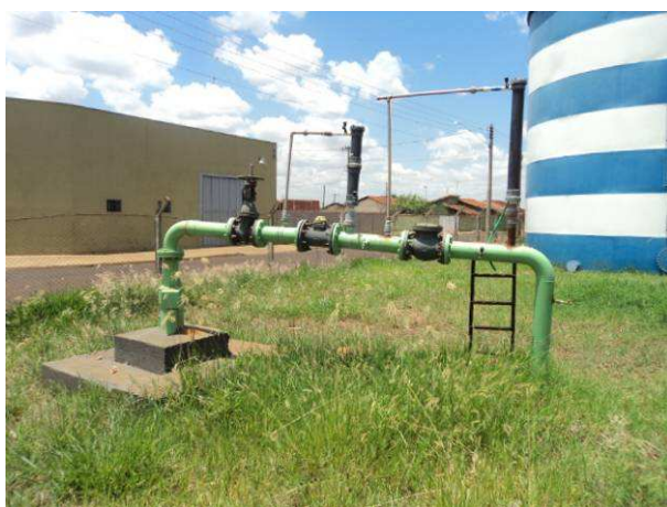
Figura 63. Vista do Poço P13.
