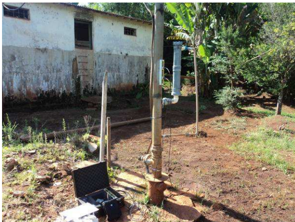
Figura 11. Medição no Poço Bandeirantes (P1).
