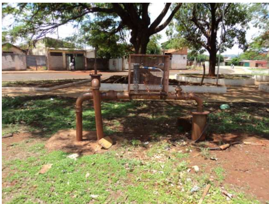
Figura 48. Vista do Poço 08.
