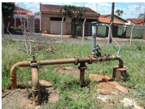
Figura 52. Vista do Poço P10.
