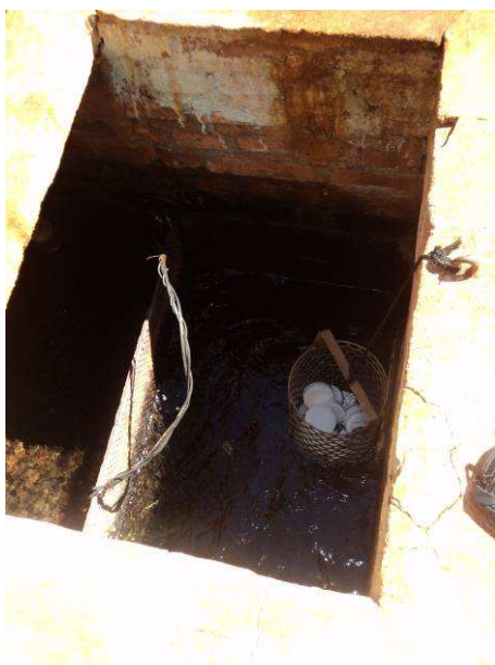
Figura 46. Vista do cesto com pastilhas de cloro para realizar a cloração
