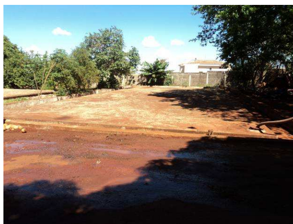
Figura 44. Vista do reservatório R4.
