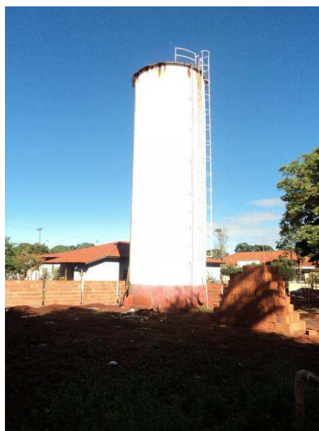
Figura 68. Vista do reservatório R8.
