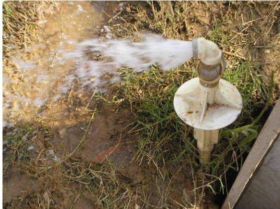
Figura 33. Cavalete sem hidrômetro.
