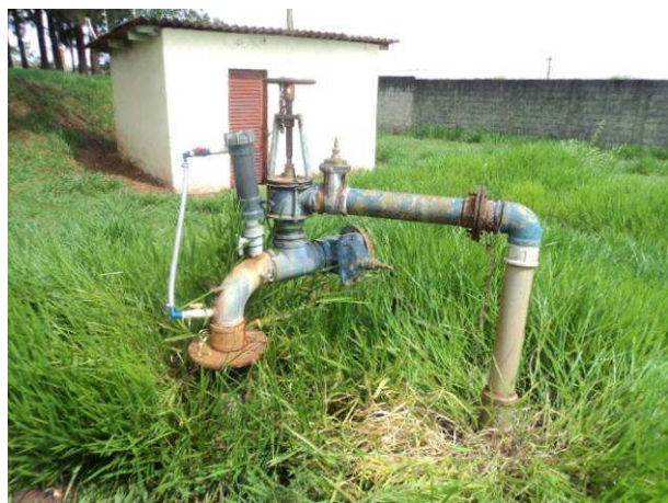
Figura 35. Vista do Poço P5.
