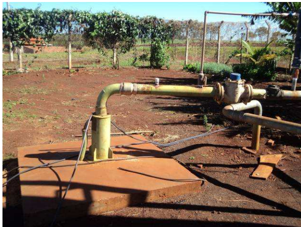
Figura 82. Vista do Poço P19.
