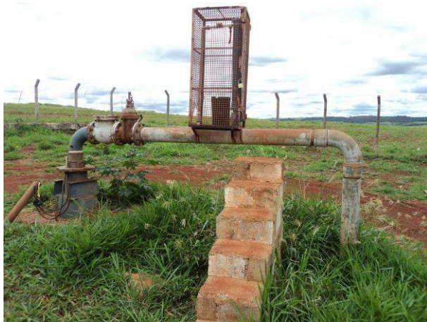
Figura 49. Vista do Poço P9.
