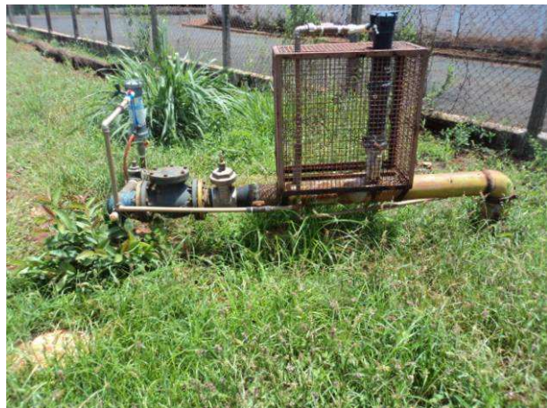
Figura 35. Vista do Poço P4.
