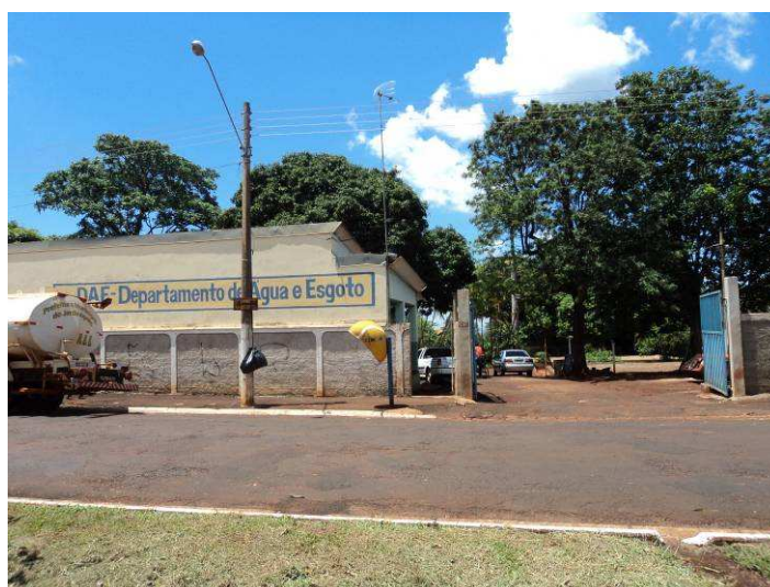
Figura 14. Vista da fachada do departamento de água e esgoto do município de Jardimópolis.
