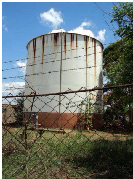
Figura 53. Vista do reservatório R6.
