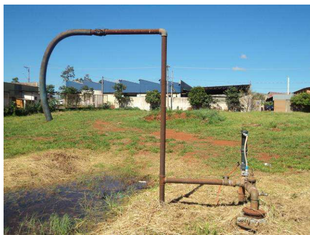
Figura 80. Vista do Poço P18.
