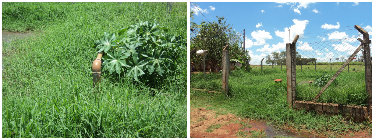
Figura 107. Vista da elevatória de esgoto Santa Emília.
