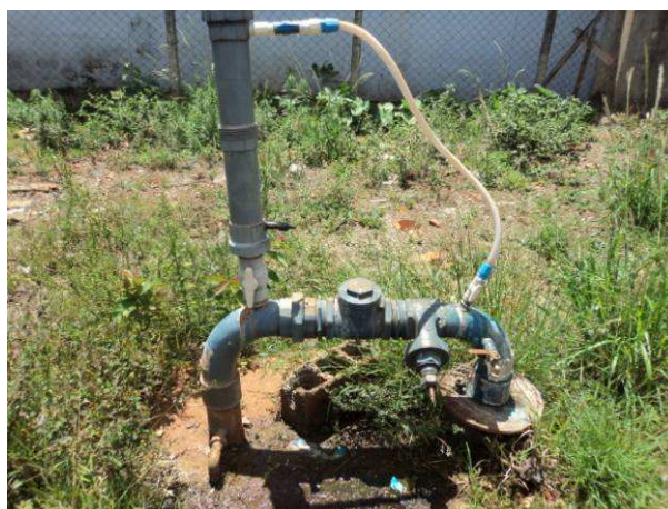
Figura 05. Vista do Poço P11.
