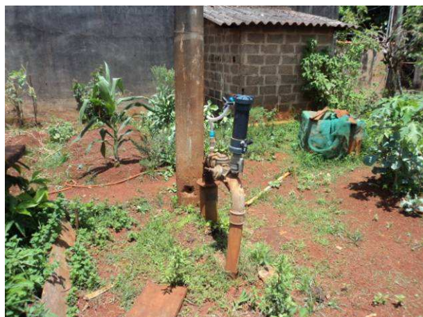
Figura 61. Vista do Poço P12.
