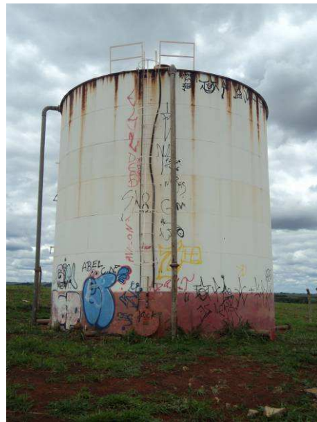
Figura 50. Vista do reservatório R5.
