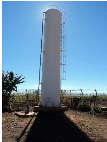
Figura 83. Vista do reservatório R13.
