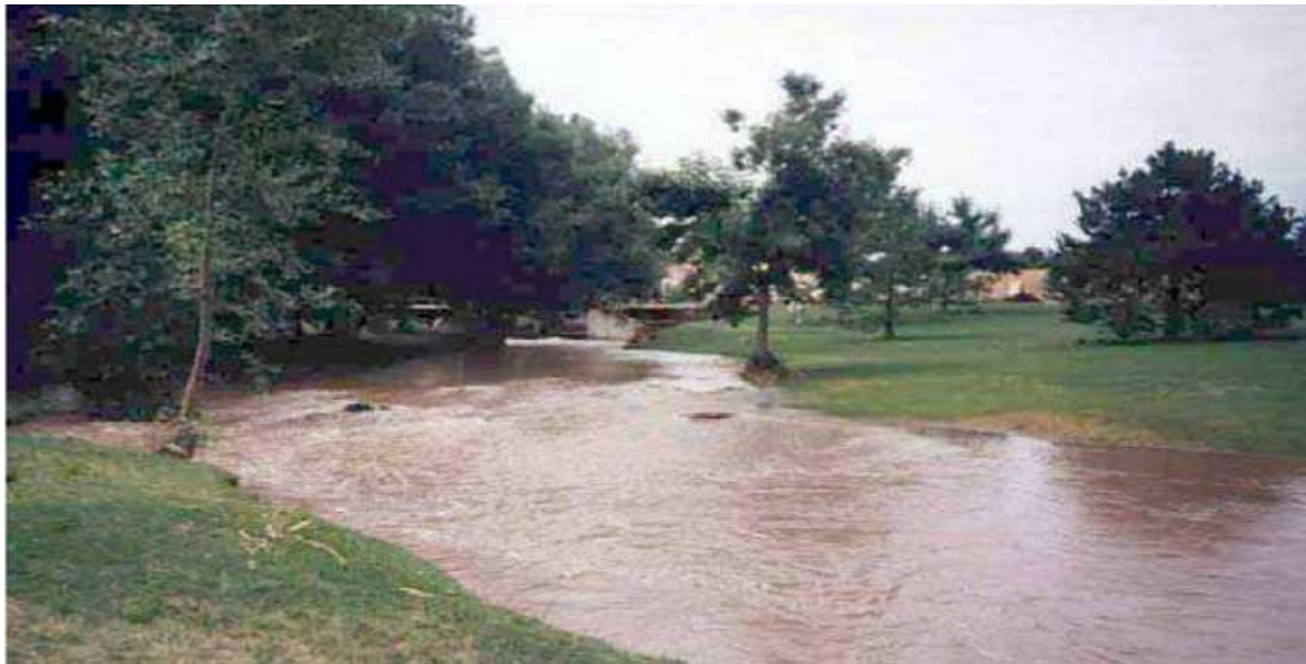
Figura 92b. Reservatório de detenção gramado numa pequena área, durante a cheia.
