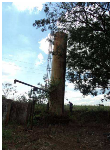
Figura 73. Vista do reservatório R9.
