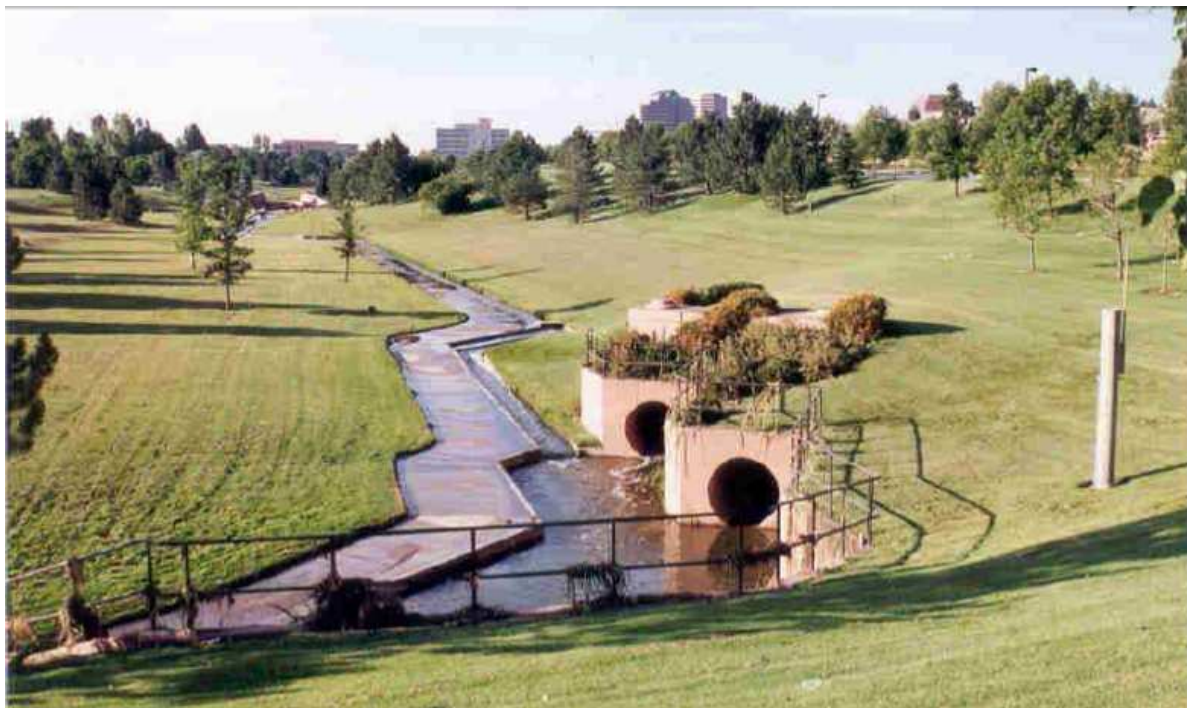
Figura 86. Reservatório de detenção seca construída no Wallace Park, Denver-USA, utilizado para controle de enchentes, e recreação no período seco.
