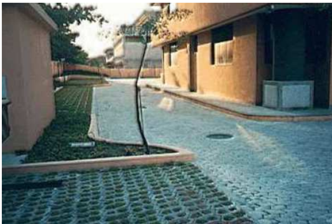
Figura 97. Pavimentação com blocos vazados para favorecer a infiltração.
