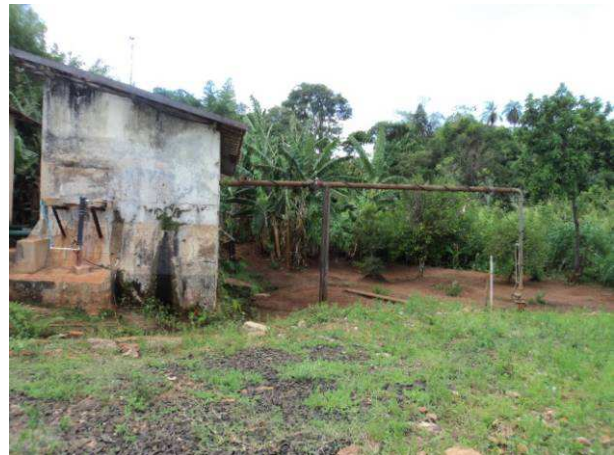
Figura 20. Vista do Poço P1 e do reservatório R1.
