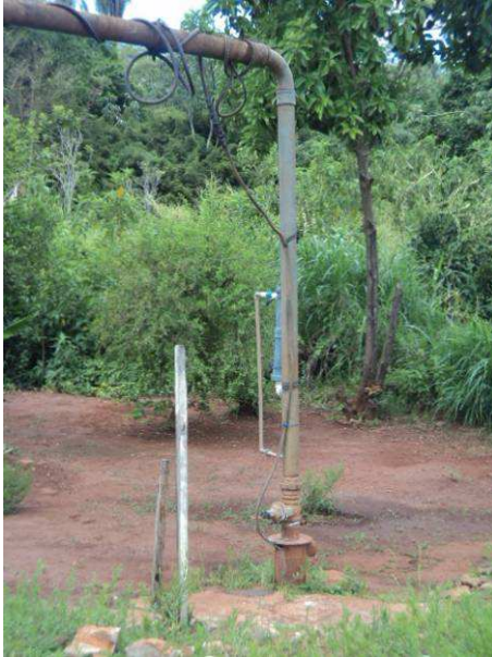
Figura 19. Vista do Poço P1.
