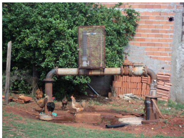
Figura 76. Vista do Poço P16.
