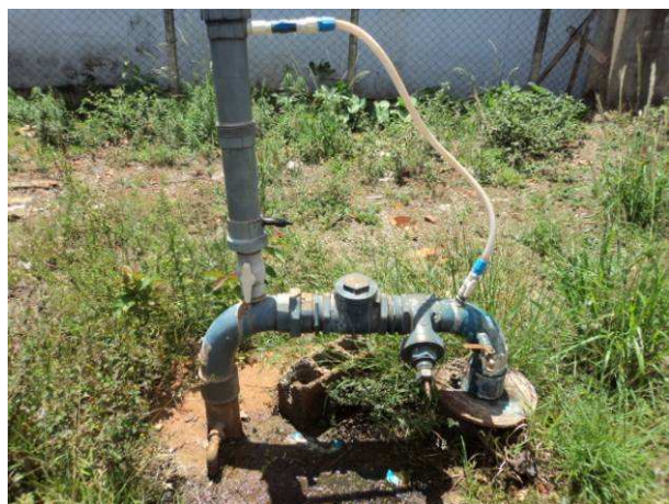
Figura 58. Vista do Poço P11.
