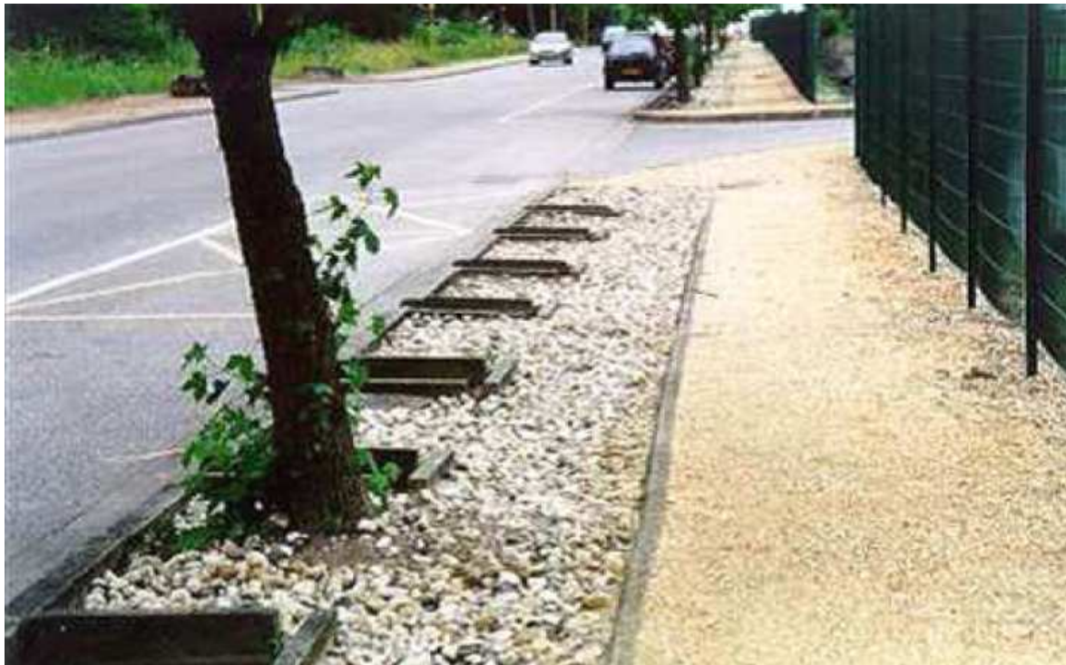
Figura 89. Trincheira de infiltração ao longo da rua.
