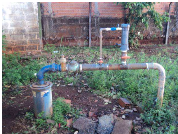
Figura 67. Vista do Poço P14.
