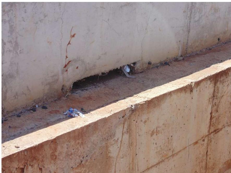
Foto 7.1 – Detalhe da captação das bocas de lobo e envio para o Canal
