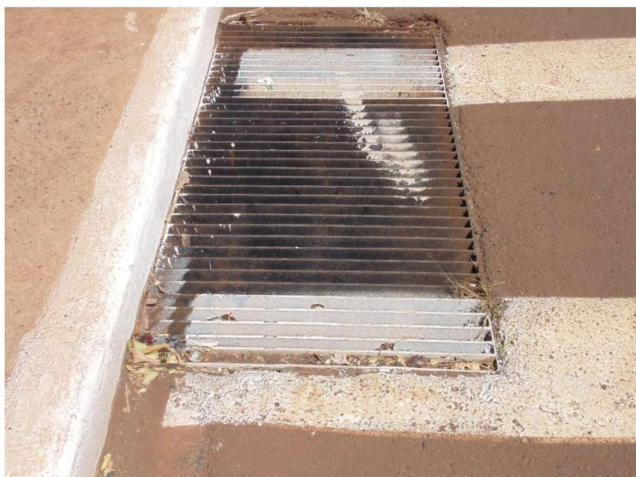
Foto 7.2 – Detalhe da captação na rotatória a montante do canal
