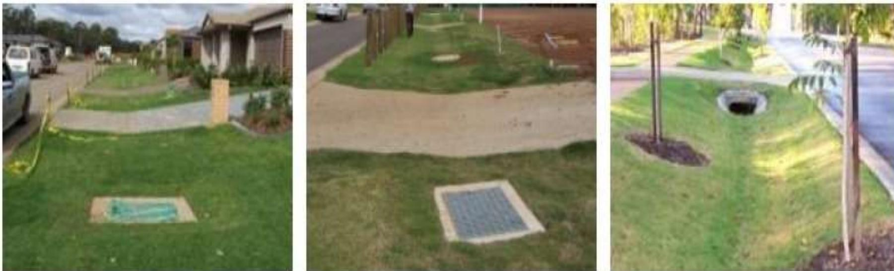
Ilustração 7.3 - Exemplos de aplicação dos canteiros de infiltração
