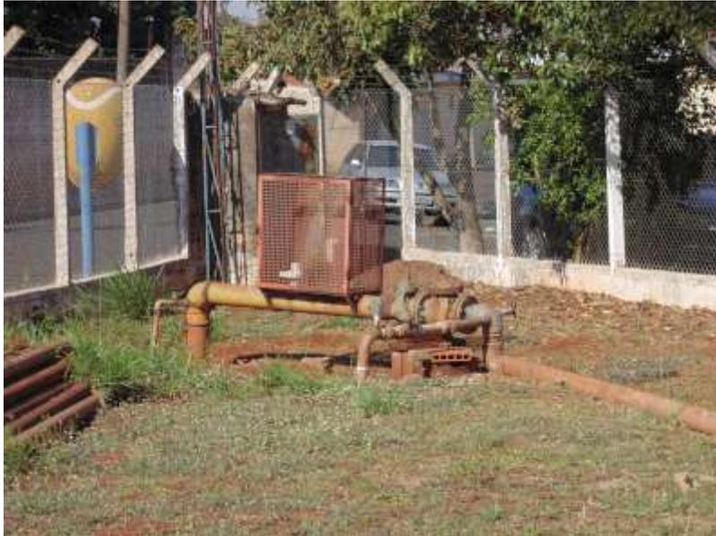
**Foto 5.9 - Vista do antigo poço desativado e da conexão do barrilete do novo poço**
