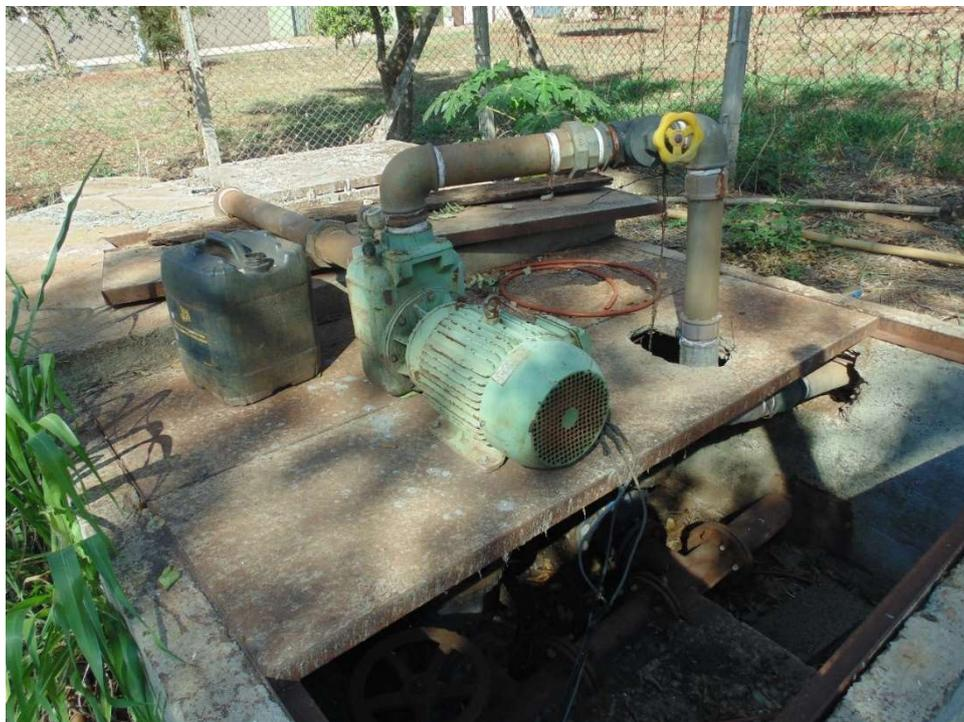
Foto 6.1 – EEE Cesar Carpato – Detalhe do conjunto motobomba e de barrilete de recalque
