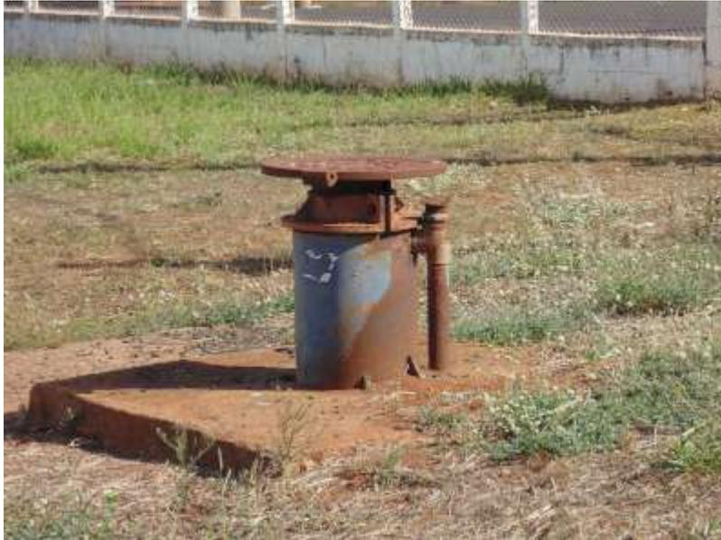
Foto 5.29 - Antigo poço desativado sem o devido tamponamento com risco de exposição do aquífero. O tampão de ferro fundido está apenas apoiado sobre a boca do poço
