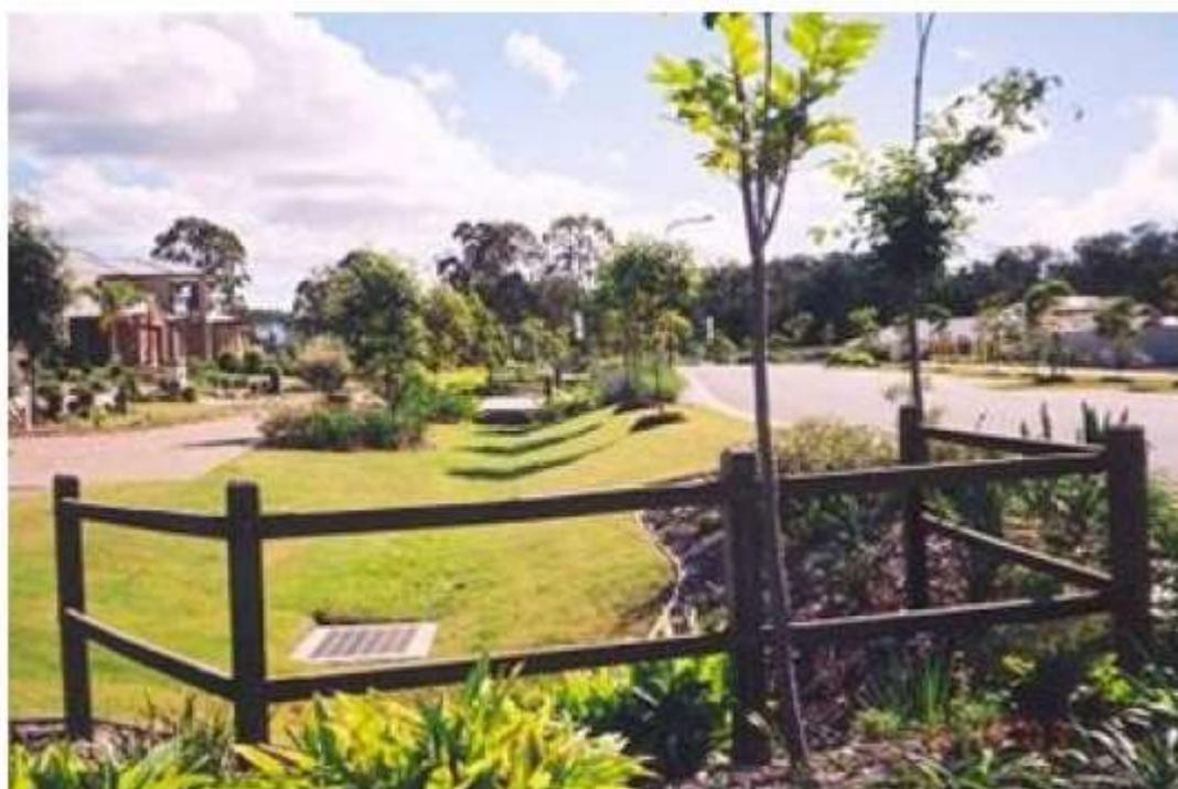
**Ilustração 7.7 - Exemplos de aplicação de dispositivos de biorretenção**
