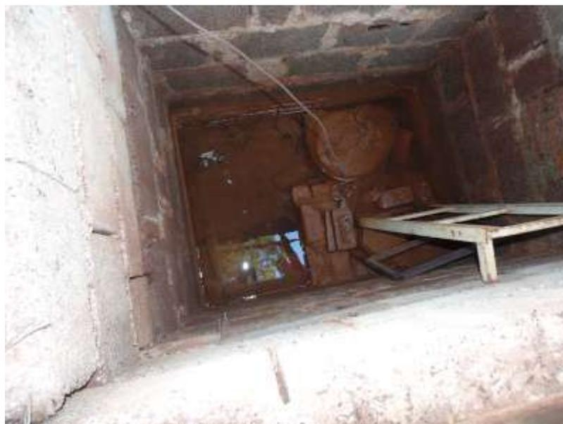
Foto 5.15 - Caixa de chegada das águas captadas pelo dreno Niágara
