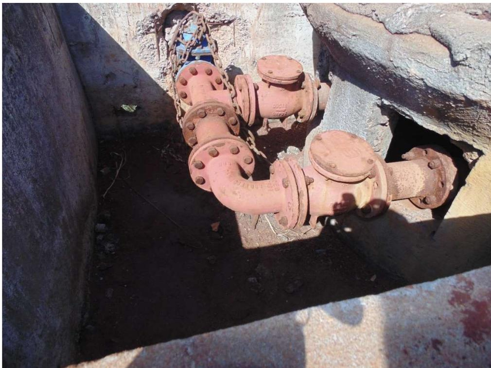
Foto 6.3 – EEE Aroeira – Detalhe do barrilete de recalque
