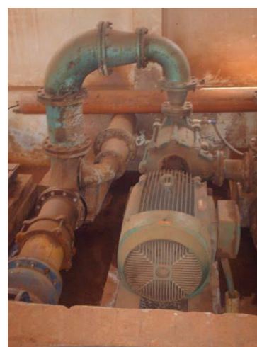
Figura 5.97: Detalhe de um dos conjuntos de bombas da estação elevatória ETA III.
