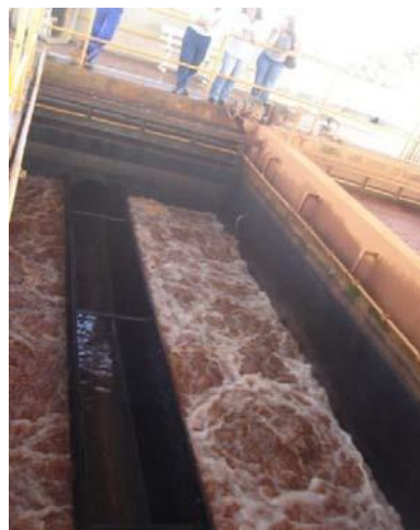
Figura 5.44: ETA II - Sala de preparo e dosagem de suspensão de cal.
