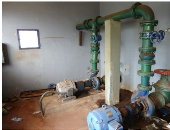
Figura 5.91: Bomba (sem reserva) do sistema de recalque Jd. Pedro Ometto.
