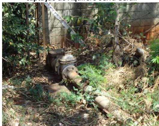
Figura 5.51: RP1 – Detalhe da bomba do poço de captação do Aquífero Serra Geral.
