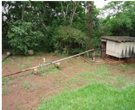
Figura 10.13 - Poço mais antigo.
