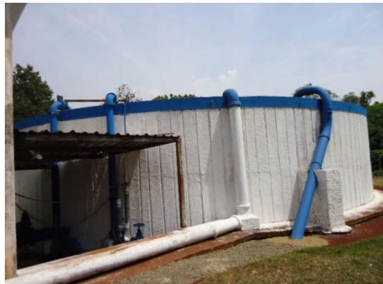
Figura 5.77: Centro de reservação ETA III – Reservatório RP2.
