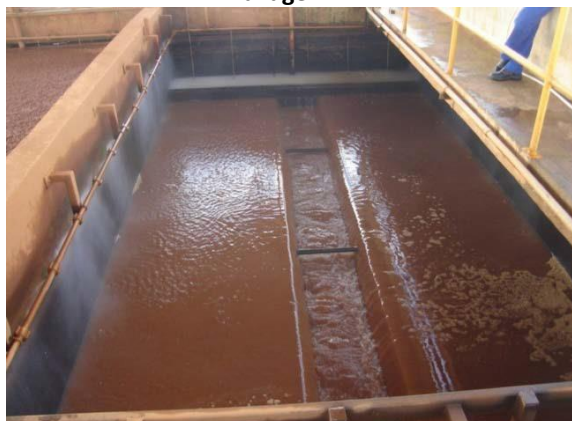
Figura 5.43: ETA II - Lavagem do filtro com água, destaque para calha de coleta de efluente da lavagem.
