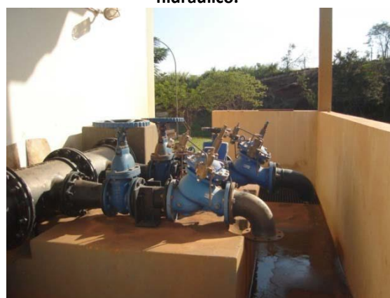
Figura 5.38:Captação - Início da linha de recalque e válvulas de alívio para o controle de transiente hidráulico.
