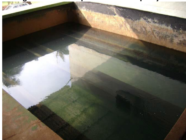
Figura 5.17: Destaque de filtro em operação.
