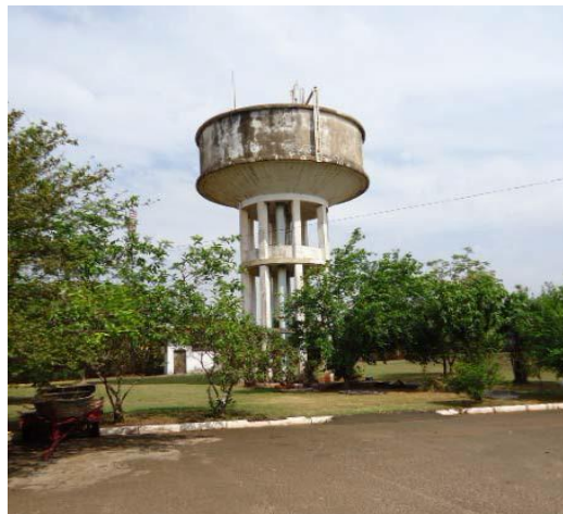
Figura 5.61: Centro de reservação ETA I - Reservatório T1.
