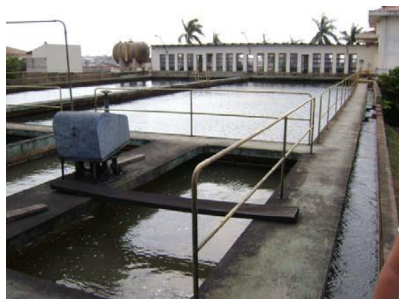
Figura 5.15: Calhas de coleta de água decantada.
