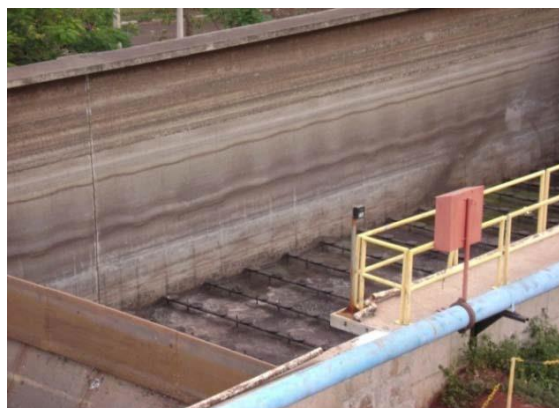
Figura 6.7: Vista dos Digestores de lodo descartado. No fundo do tanque, vista dos difusores do sistema de aeração.
