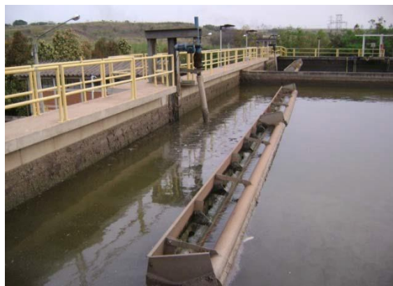
Figura 6.6: Vista dos tanques de aeração/decação, com destaque para os vertedores flutuantes de coleta do sobrenadante (efluente tratado).
