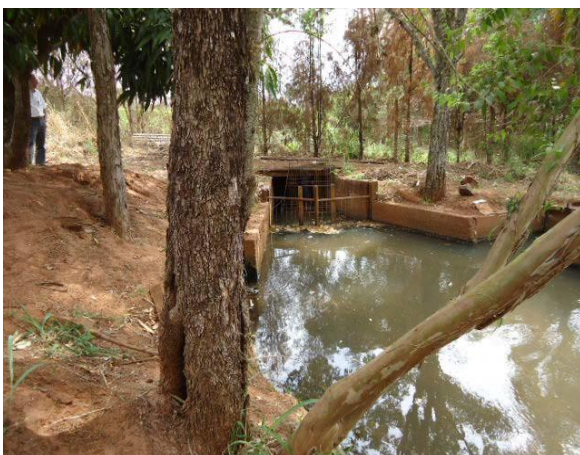
Figura 5.6: Captação Paineiras. Vista da caixa de reunião de fluxo e captação provisória no Rio JAHU.
