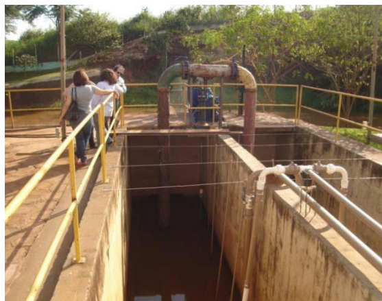
Figura 5.38:Captação - Início da linha de recalque e válvulas de alívio para o controle de transiente hidráulico.
