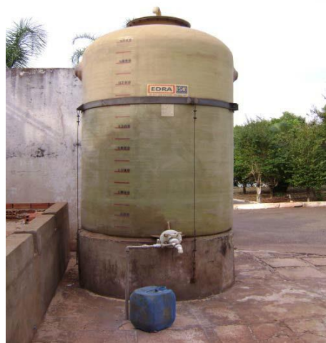
Figura 5.21: Tanque estacionário destinado ao armazenamento de PAC.
