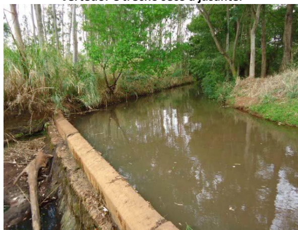
Figura 5.5: Captação no Córrego Sto. Antônio, vista do vertedor e trecho seco a jusante.
