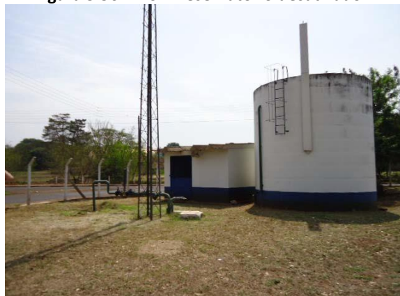
Figura 5.56: RP6 – Reservatório desativado.
