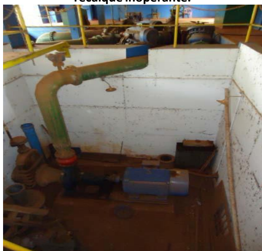
Figura 5.8: Captação Paineiras. Vista do sistema de recalque inoperante.
