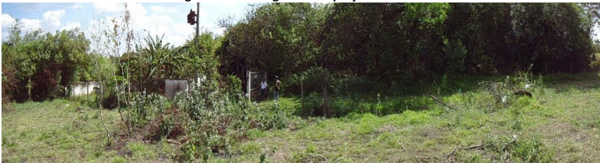
Figura 5.26: Vista geral da Captação dos Pires.
