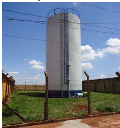
Figura 5.82: Centro de reservação Residencial Paraty - Reservatório R13.
