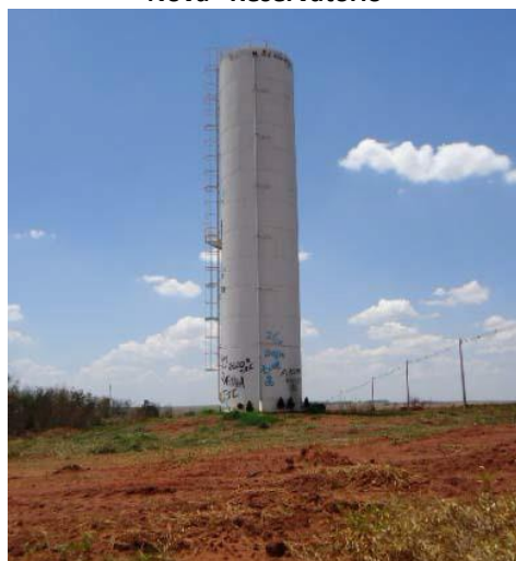
Figura 5.85: Centro de reservação Área Industrial Nova - Reservatório
