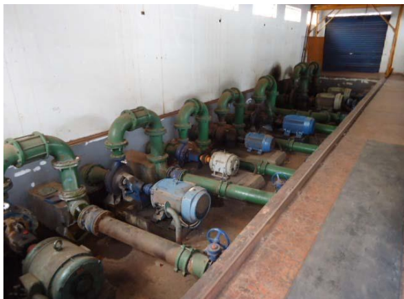
Figura 5.90: Bomba (sem reserva) do sistema de recalque Santo Antônio.
