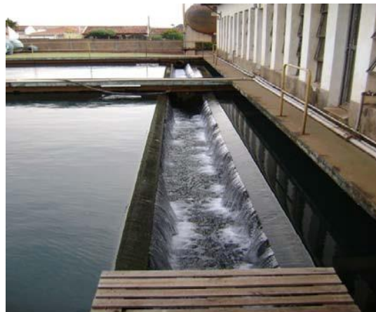
Figura 5.15: Calhas de coleta de água decantada.
