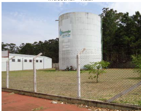
Figura 5.69: Centro de reservação Distrito Industrial – R12.
