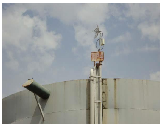
Figura 5.87: Sistema de telemetria.
