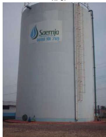
Figura 5.68: Centro de reservação Jd. Nova JAHU – RP8.
