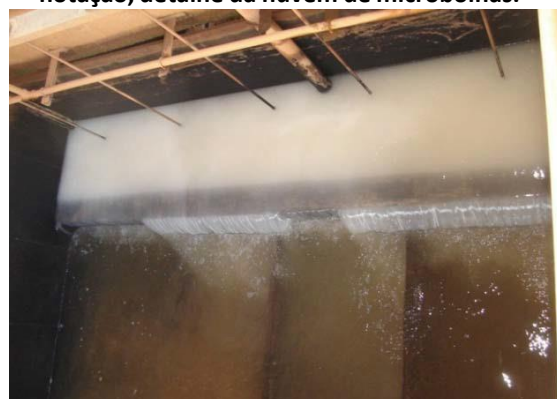
Figura 5.40: ETA II - Porção inicial da câmara de flotação, detalhe da nuvem de microbolhas.
