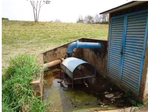
Figura 5.11: Sistema de recalque na Represa São Joaquim. Única bomba instalada ao tempo.
