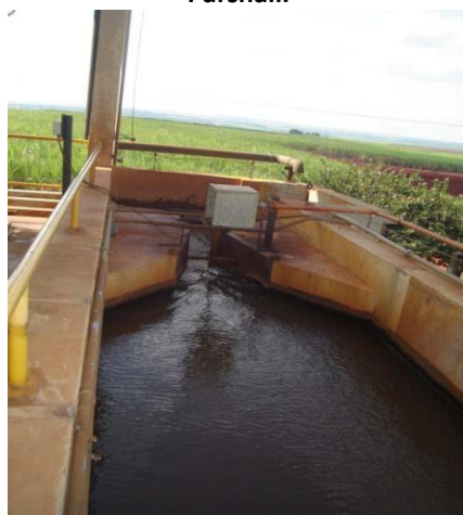
Figura 5.39: ETA II - Canal de chegada com calha Parshall.
