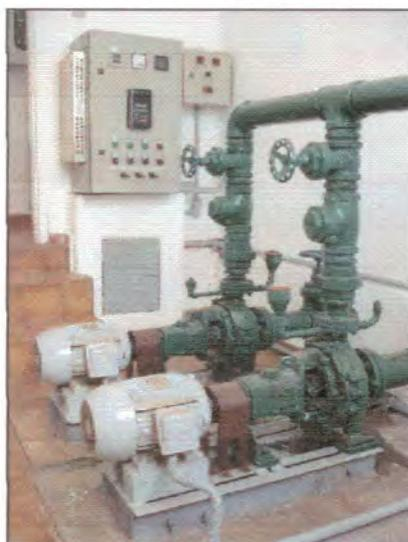
A adutora de água tratada 01 - AAT01 - opera atualmente com uma vazão máxima de 5,3 l/s e durante 24 horas/dia. O acionamento dos conjuntos moto-bomba do booster B01 ocorre de acordo com os valores registrados na pressão da rede de distribuição da zona alta e indicados no pressostato instalado na unidade.
