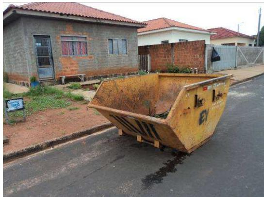
Figura 34. Caçamba utilizada para coleta do resíduo da construção civil
