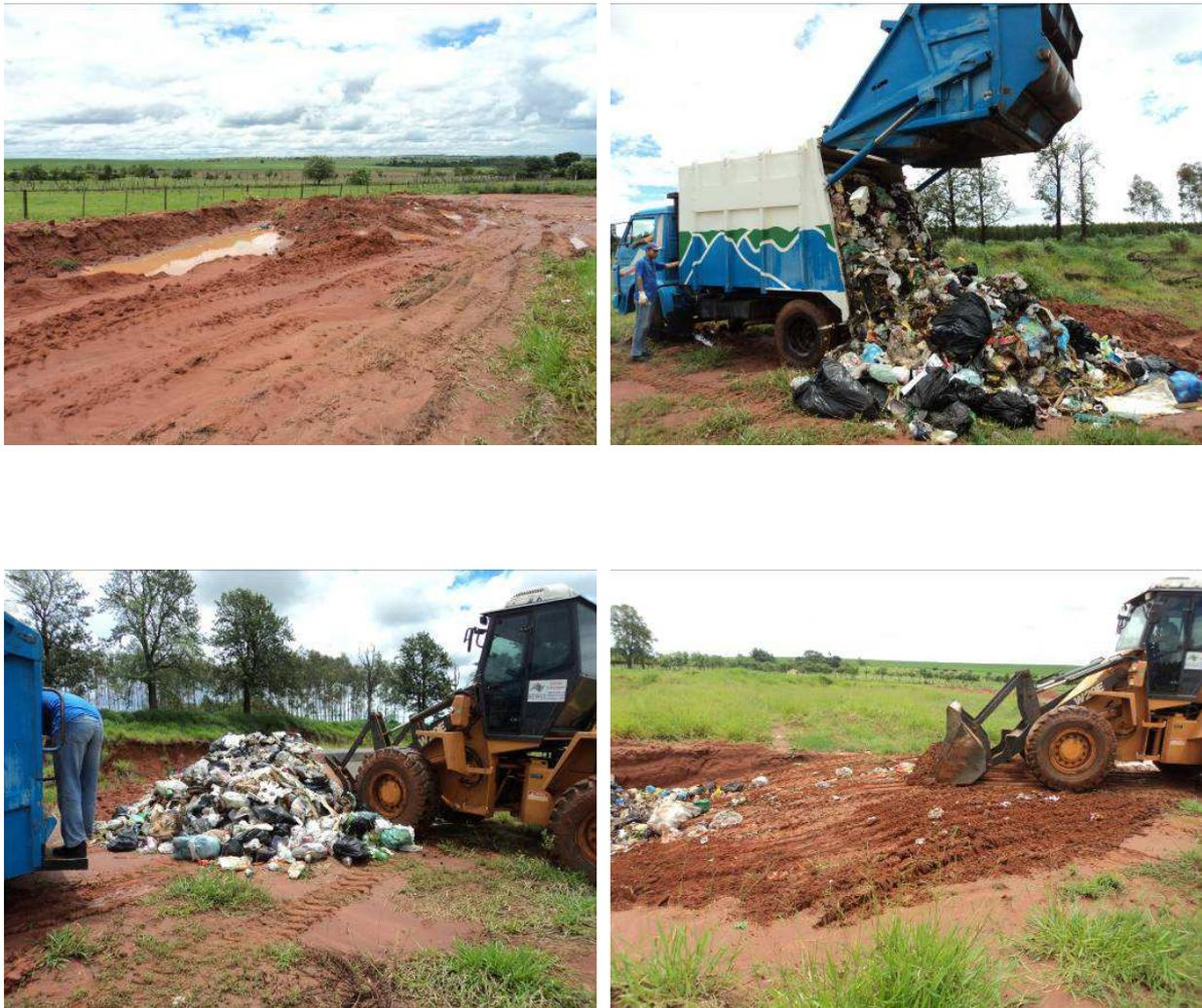
Figura 52. Procedimento do enterro do resíduo sólido no Aterro Sanitário.
