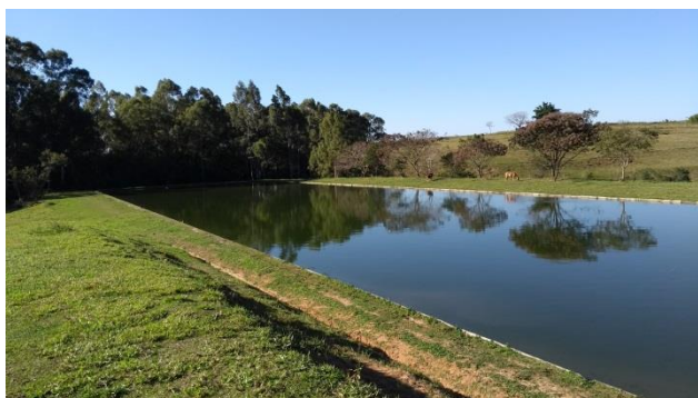
Foto 3.21 – Vista da lagoa facultativa
