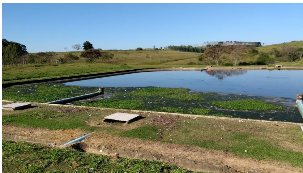
Foto 6.1 – Vista da presença de sobrenadante na superfície líquida da lagoa anaeróbia
