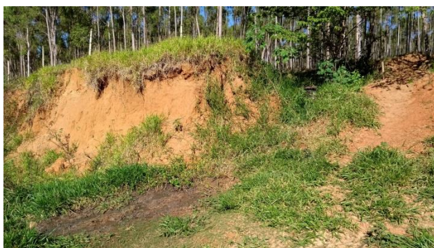
Foto 3.17 – Identificação do vazamento do emissário
