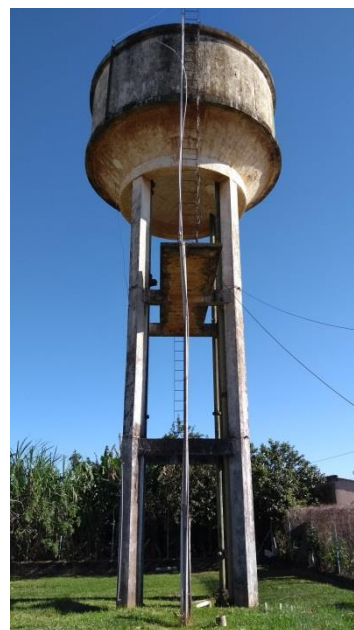
Foto 3.10 - Identificação do reservatório REL03 em manutenção
