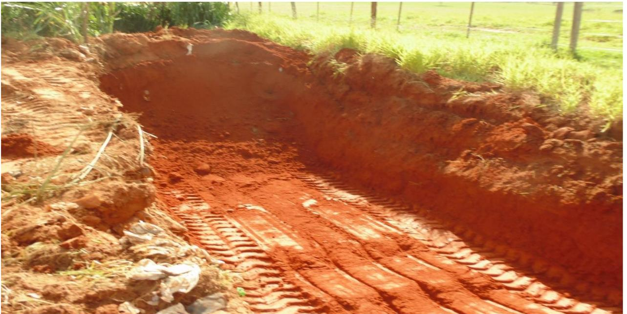
Imagem 17: vista interna do aterro em valas, com destaque para a área disponível para utilização.
