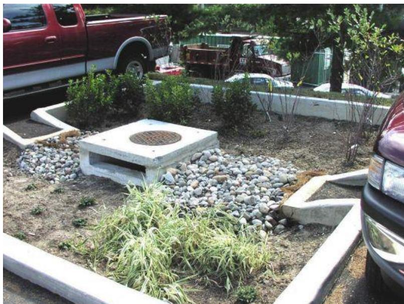
**Figura 7.13 – Exemplo de Bioretenção**
