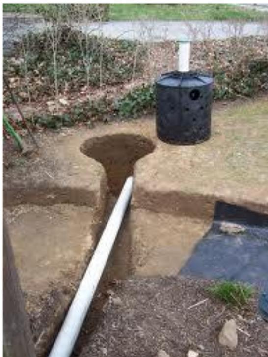
**Figura 7.14 – Poço seco em construção**
