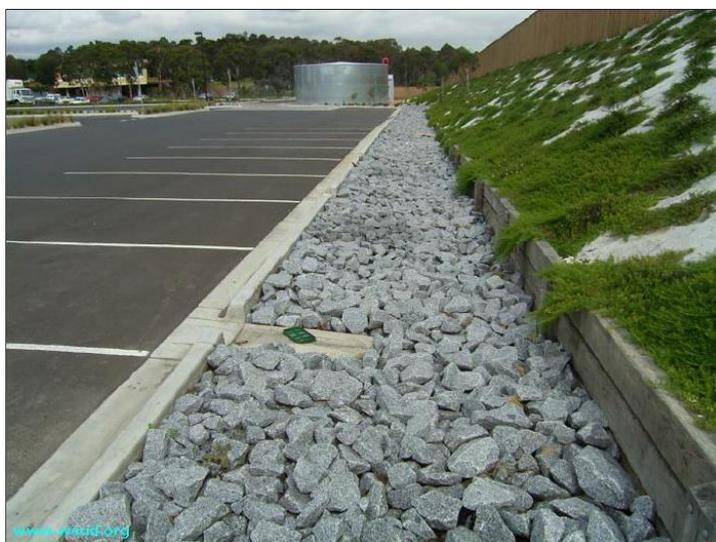
**Figura 7.15 – Trincheira de infiltração**
