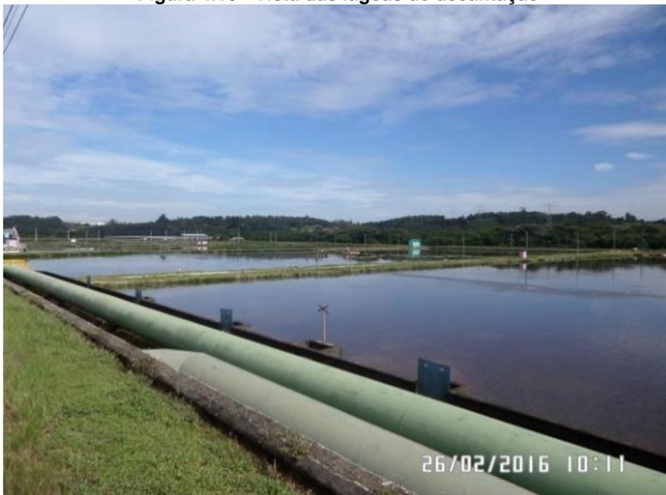
A ETE Jundiaí recebe, em seu poço de entrada, contribuições da rede coletora, do recalque da EEE Novo Horizonte, do Efluente Via Caminhão (EVC) e do clarificado do sistema de desidratação do lodo. Os EVC consistem em contribuições de limpeza de fossas e caixas de gorduras; efluentes de indústrias não interligadas à rede coletora de esgoto pública; chorume e lodo industrial.
