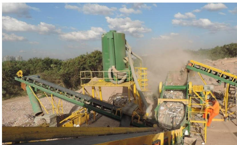
Figura 11: Material de resíduo da construção civil beneficiado - GERESOL.
