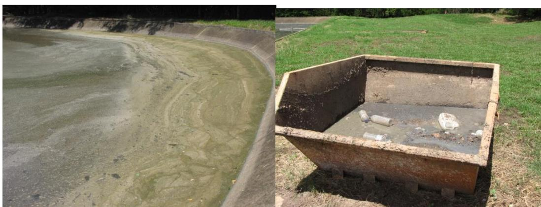
**Figura 63 - Lodo acumulado na ETE e lodo já depositado na caçamba.**
