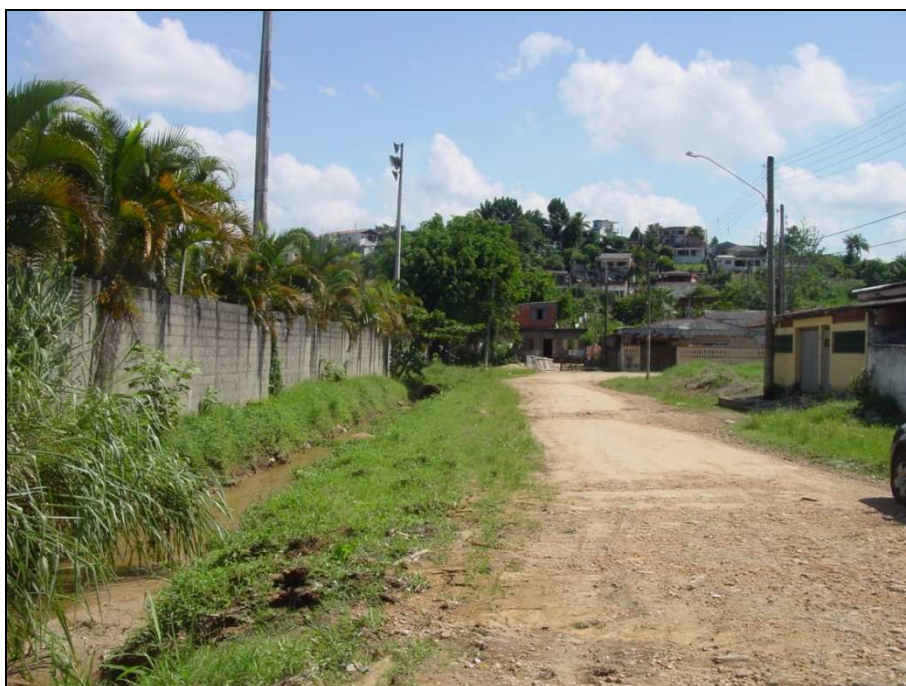
Foto 1 – Área Crítica 1 – Visão do Canal da Rua Pedro Barros Costa
