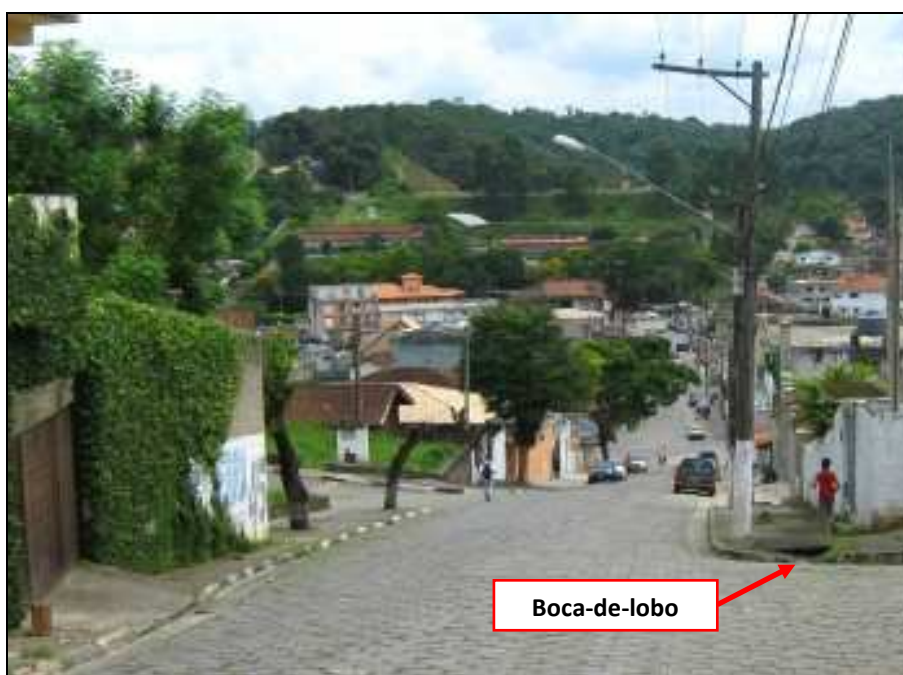
Foto 4 – Boca-de-lobo em Rua de Juitiba
