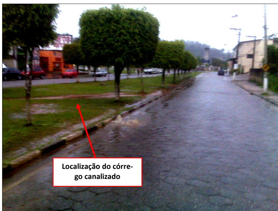
Foto 3 – Visão do Córrego N a . S a . Aparecida, Canalizado, Próximo à Rodoviária
