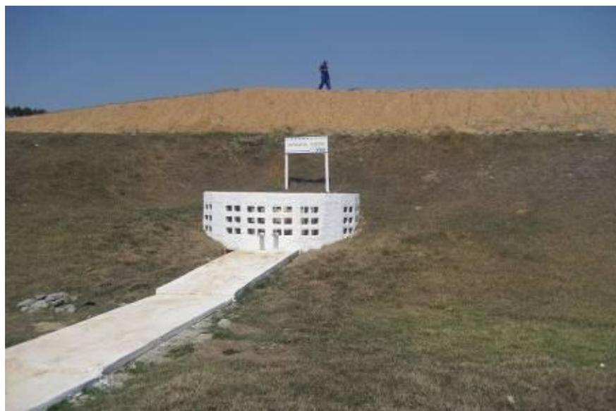
Foto 18 – Poço de Captação de Líquidos Percolados.
