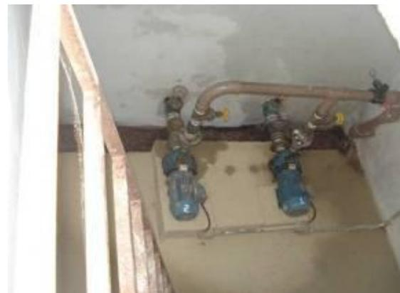
Foto 10 – Booster da Adutora de Água Tratada e Elevatória para o Loteamento
