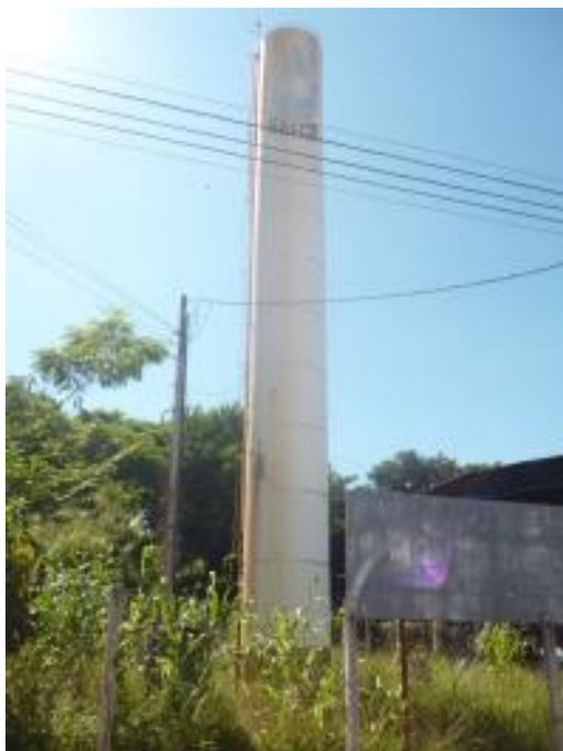
Foto 4.21 – Reservatório R-13 (Bairro Taquari Ponte)
