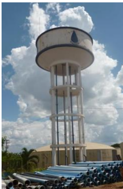
Foto 4.15 – Centro de Reservação Santana
