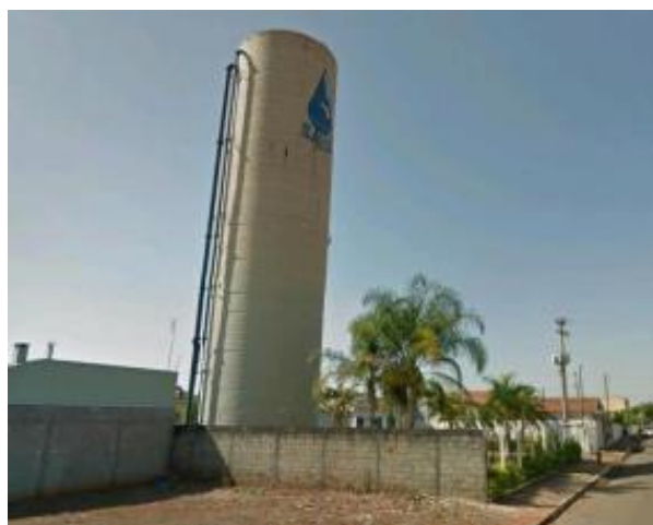
Foto 4.18 – Centro de Reservação Santa Maria
