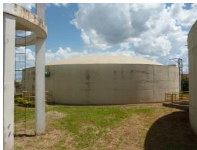
Foto 4.14 – Centro de Reservação Santana
