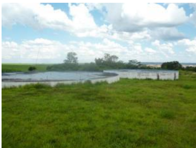
Foto 4.13 – Centro de Reservação da ETA
