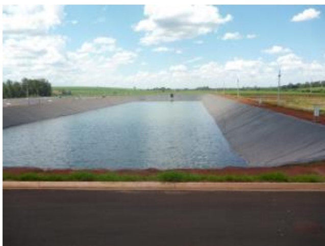
Foto 4.31 – Uma das Lagoas de Aeração
