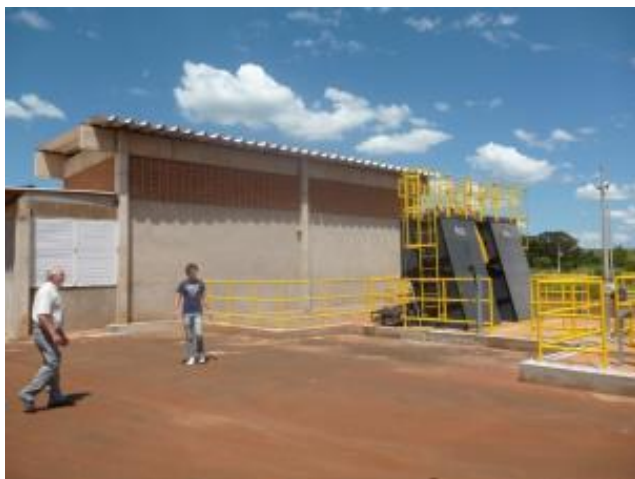
Foto 4.25 – Estação Elevatória de Esgotos Final (EEEF)
