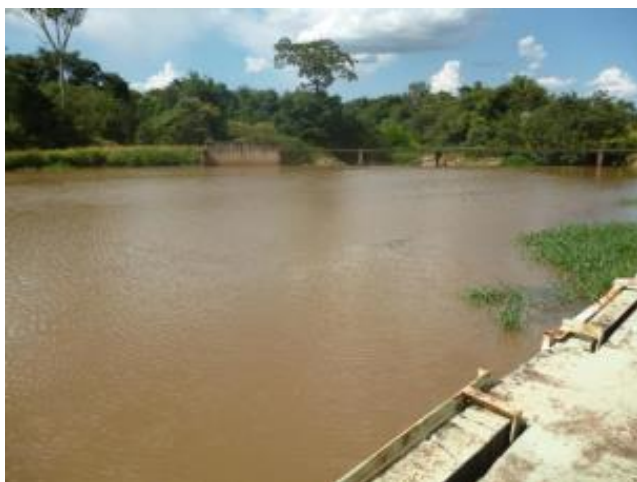
Foto 4.1 – Barragem de Nível do Ribeirão do Roque
