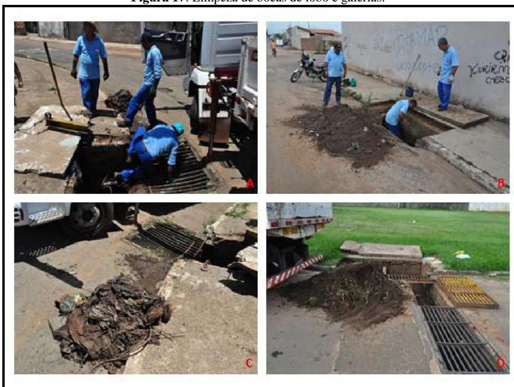
**A e B:** Funcionários da SAECIL realizando a limpeza de bocas de lobo e galerias. **C e D:** sujeira retirada das e galerias. **Fonte:** SAECIL, 2014.
