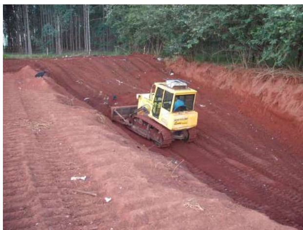
Figura 24: Processo de cobertura dos resíduos no aterro em valas
