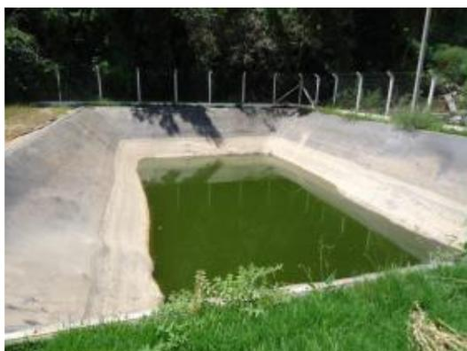
Foto 4.44 - Tanque Pulmão para a EEE 4 e EEE 5
