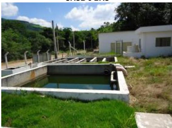
Foto 4.48 - Tanque de Lavagem, Tanque de Contato e Calha Parshall de Saída
