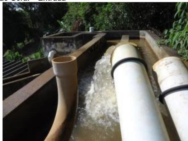
Foto 4.19 – ETA – Canal de Chegada da Água Bruta e Calha Parshall ao Fundo
