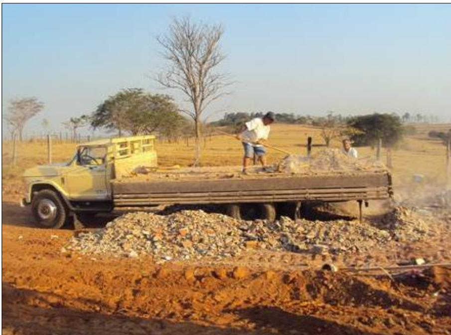
FIGURA 05 – RCC – Entulho sendo descarregado na estrada –
